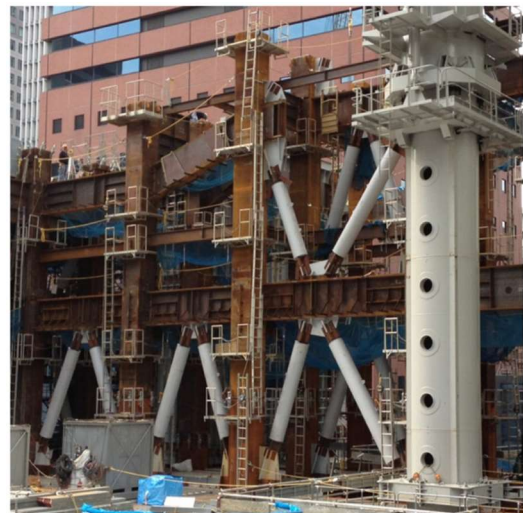
写真 1.2 鋼構造における BRB の配置 1.3)
