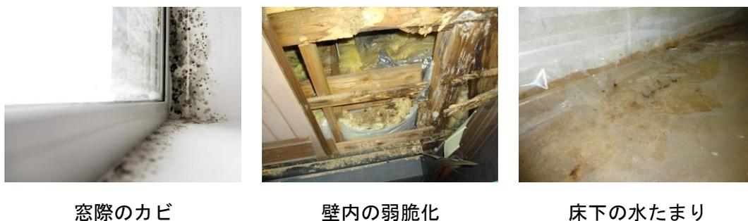
図1-2 結露被害の例
