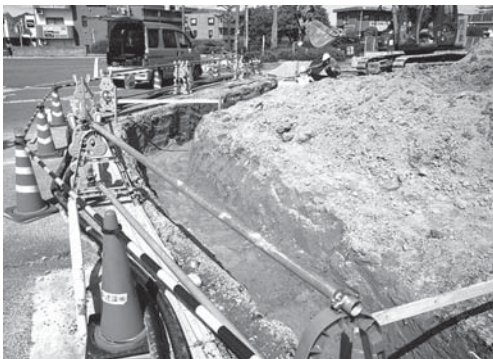
9-5 西端部管路掘削状況（南より）
