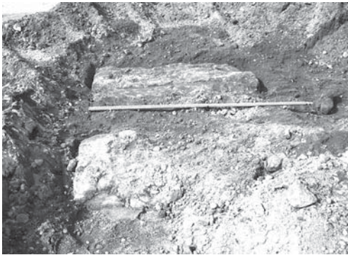
17-3 コンクリート構築物（南より）
