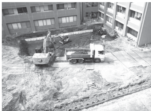
19-2 校舎本体部分掘削状況 (北より)
