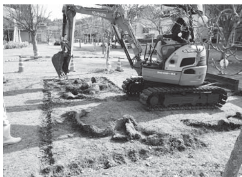
11-1 掘削開始状況 (西より)
