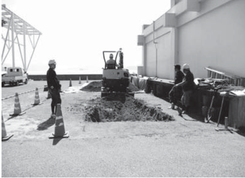
20-1 浄化槽設置箇所掘削風景（北より）
