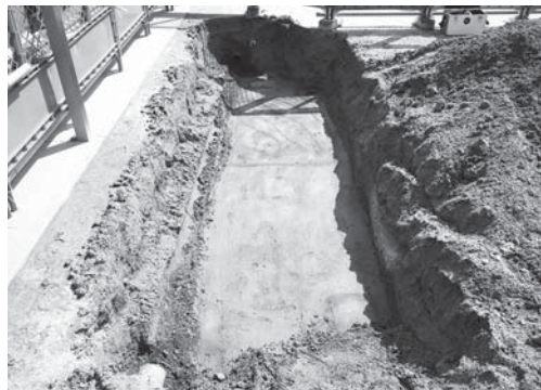
13-6 基礎 4 コンクリート床 (南西より)
