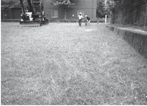
7-1 1トレンチ掘削前状況（南より）
