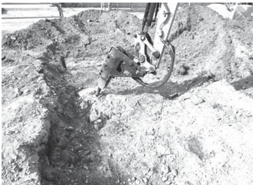
17-5 はつり作業（南より）
