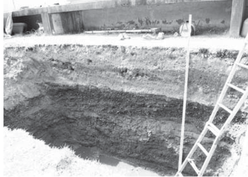
20-2 浄化槽設置箇所完掘後 西壁堆積状況（東より）
