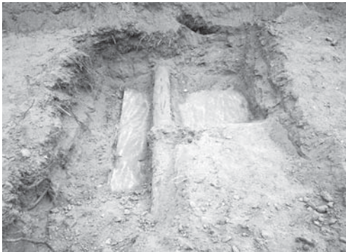
16-3 駐輪場屋根基礎 6 (北より)
