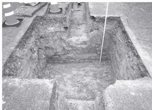
12-6 柵設置部掘削状況（東より）
