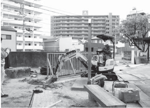
22-1 掘削風景（北東より）
