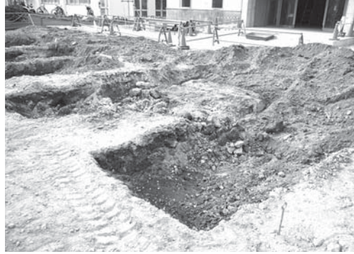
17-2 駐輪場屋根基礎北5（南東より）
