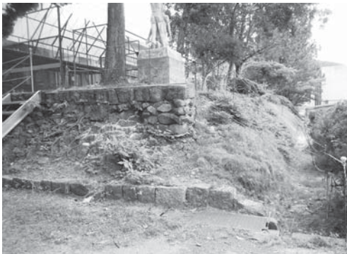
21-1 体育館東側整備前の状況 (西より)
