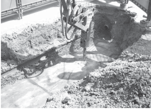
14-1 基礎 4 (南西より)
