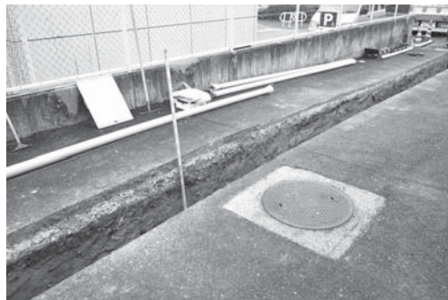
12-4 東西管路掘削状況（南西より）
