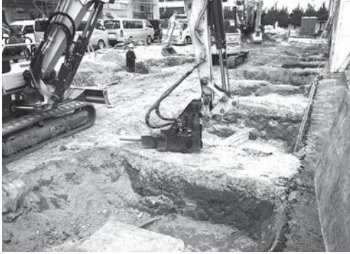
17-1 駐輪場屋根基礎（南列）掘削状況（西より）
