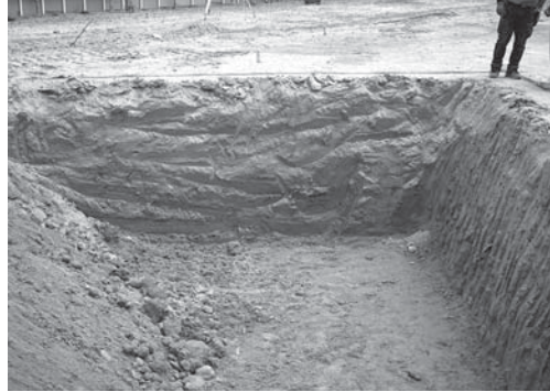
9-2 待合室部分掘削状況（南西より）
