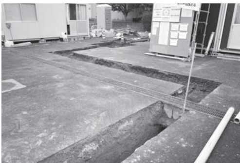
12-5 東西管路掘削状況（北東より）
