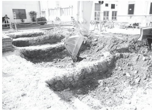
17-4 駐輪場屋根基礎北1～4（南東より）
