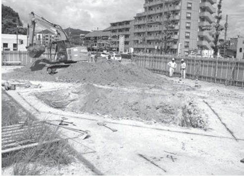
9-1 待合室部分掘削状況（東より）
