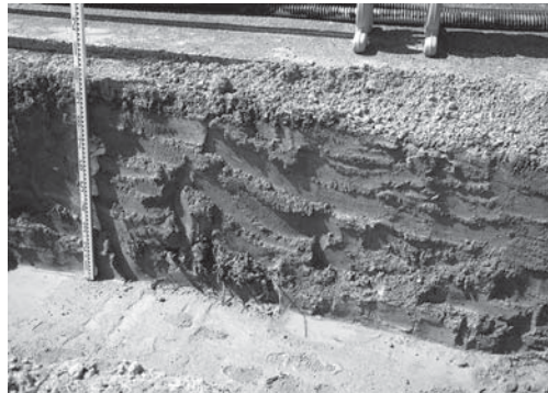
9-4 配管部掘削状況（北東より）
