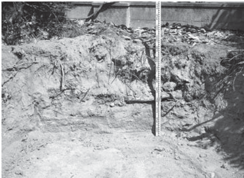
15-3 駐輪場屋根基礎 1（西より）
