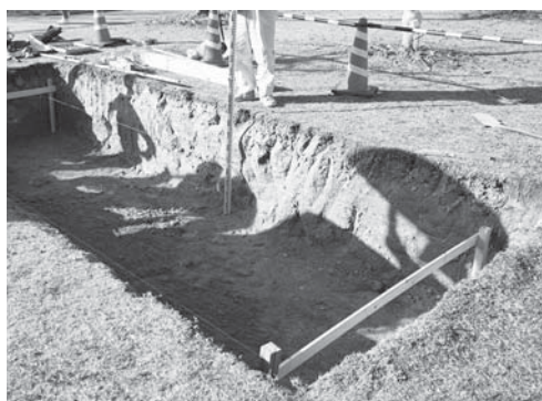
11-2 掘削完了状況 (南東より)
