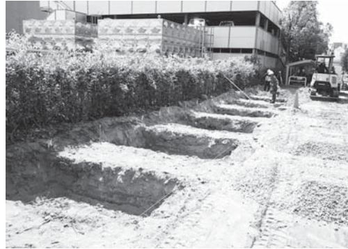
15-2 駐輪場屋根基礎掘削状況（東より）
