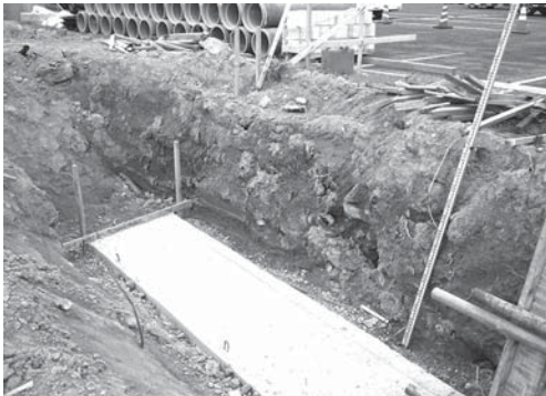
9-3 駐車場との隣接部掘削状況（北西より）
