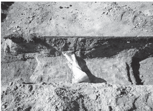
20-5 屋外排水管敷設箇所北側東端部分の 南側コンクリート面検出状況（東より）
