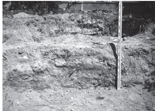
15-4 駐輪場屋根基礎 2（西より）
