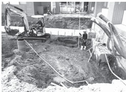
19-1 校舎本体部分掘削状況 (北より)
