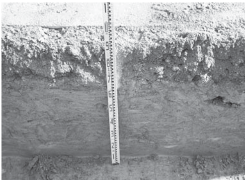
12-3 南北管路東壁（西より）
