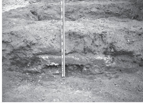
16-2 駐輪場屋根基礎 5 (北より)
