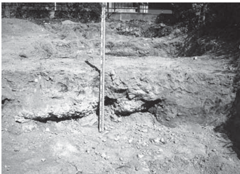
15-5 駐輪場屋根基礎 3（西より）
