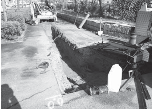
12-1 管路掘削開始状況（南より）
