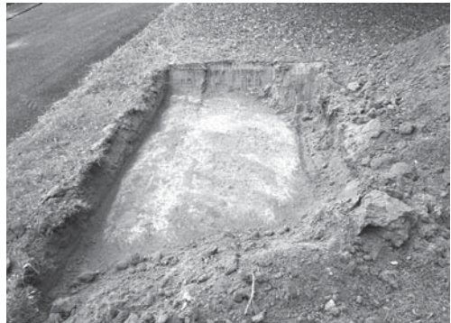
8-4 2 トレンチ掘削後状況 (北より)
