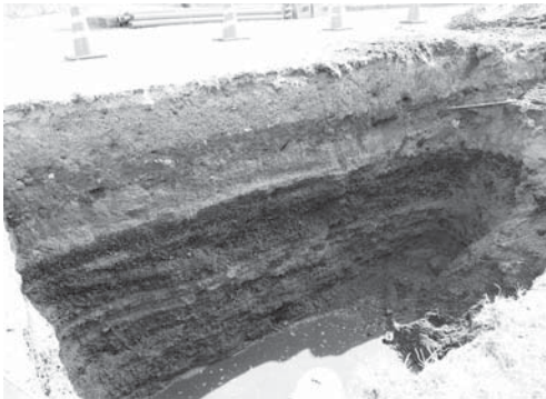
20-3 浄化槽設置箇所完掘後東壁堆積状況 （西より）
