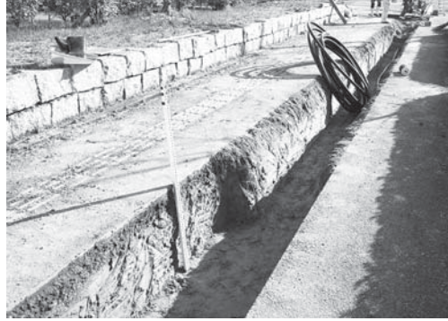
12-2 南北管路掘削状況（北西より）
