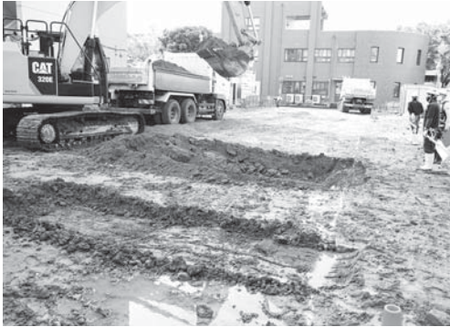
15-1 杭設置箇所確認（南より）
