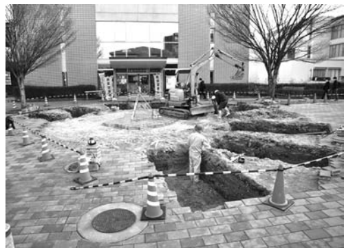
9-6 迎える広場工事掘削完了状況（北より）
