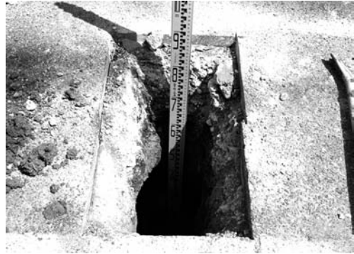
10-2 バリカー基礎掘削（南より）
