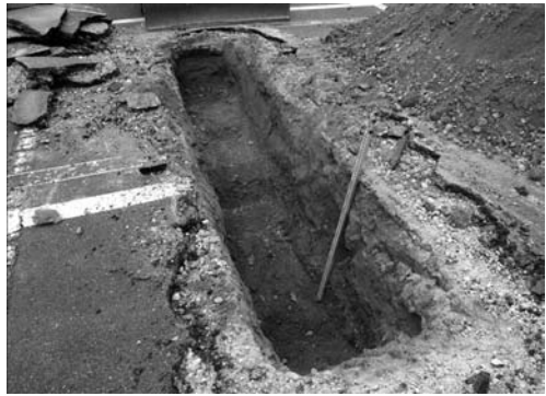
14-4 トレンチ 3 (北東より)
