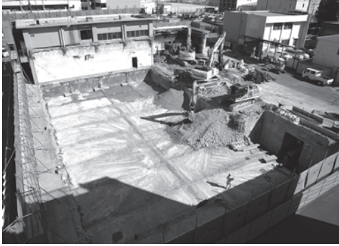
16-1 中央機械棟解体状況（西より）
