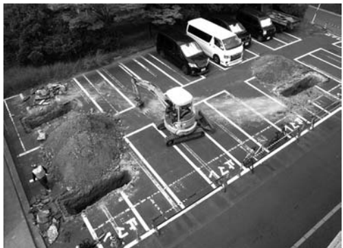
14-6 掘削完了状況 (南東より)
