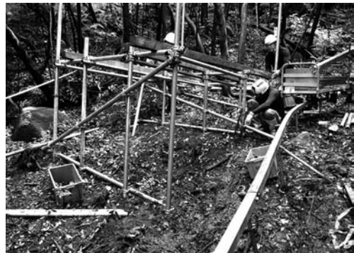
7-6 ボーリング1足場組み立て (南西より)
