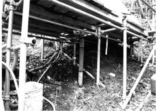
8-2 ボーリング 2 掘削箇所 (南西より)
