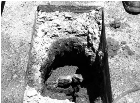
10-3 バリカー基礎掘削（南より）
