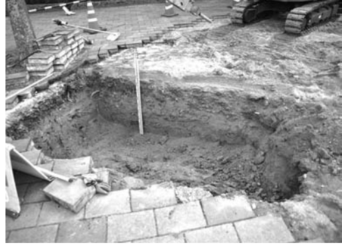
9-2 迎える広場工事掘削状況（北より）
