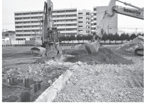
16-2 車庫解体作業（西より）
