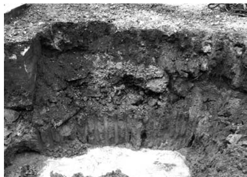
11-6 水槽撤去工事西壁（東より）
