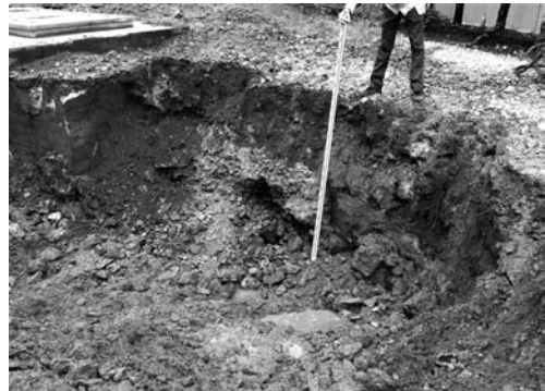
11-4 水槽撤去工事西壁（北東より）
