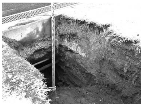
20-2 電気迂回路南部 (北東より)
