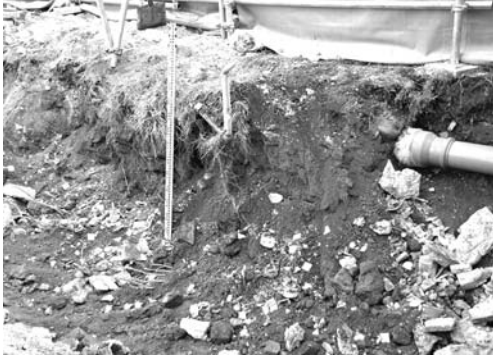
15-1 RI棟解体地点北壁（北西より）
