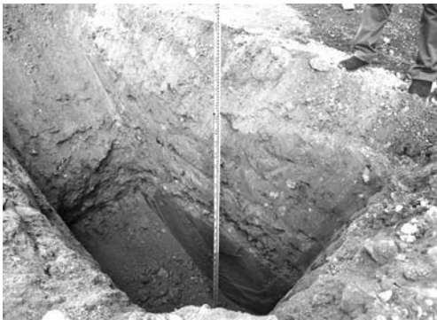
15-3 地中障害物撤去地点3（東より）
