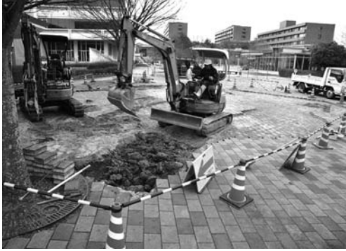
9-1 迎える広場工事掘削開始状況（東より）
