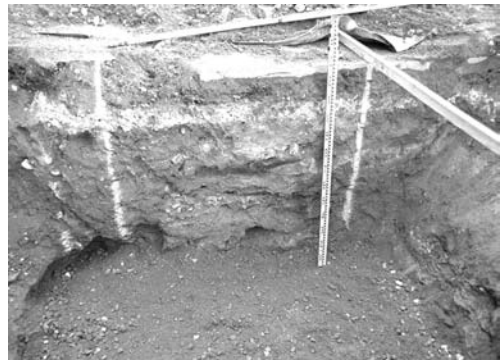
12-4 ハンドホール設置地点西壁（東より）
