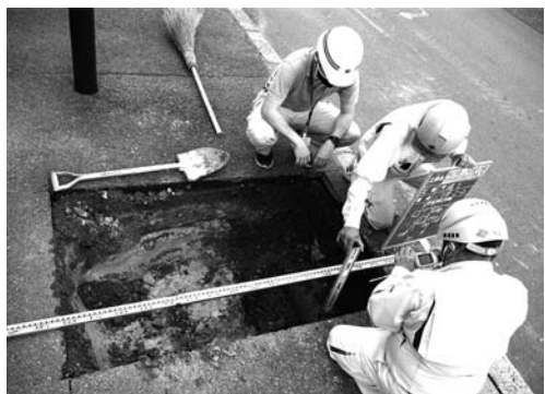
8-6 交通結東点整備 C 地点造成土堆積状況 (東より)
