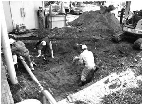
12-3 エネルギー棟北側掘削状況（南東より）
