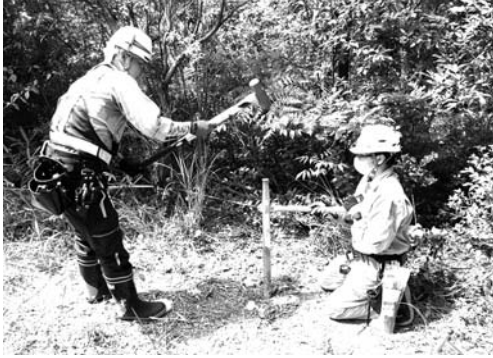
7-1 GNSS 機器設置作業風景 (ががら山山頂) (南より)
