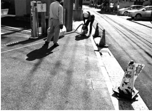
10-1 バリカー設置工事（東より）
