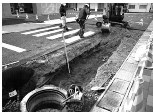
20-1 電気迂回路北部 (北東より)
