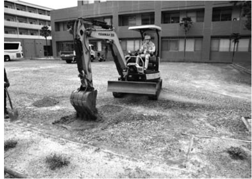
18-2 トレンチ 1 掘削開始状況（北西より）
