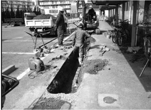
17-1 掘削状況（南より）
