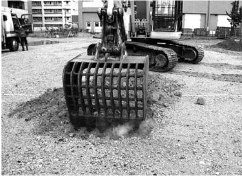
11-1 杭設置箇所確認（南より）
