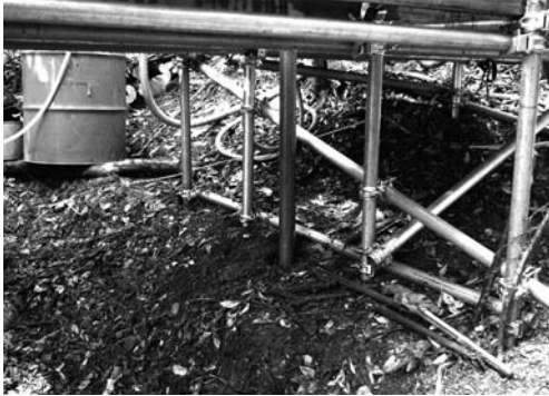
8-1 ボーリング 1 掘削箇所 (南西より)
