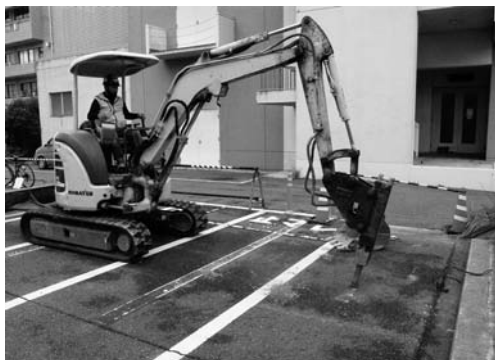
13-1 掘削開始状況 トレンチ 1 (南西より)
