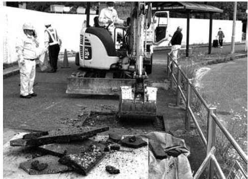
8-4 交通結東点整備 A 地点 (西より)
