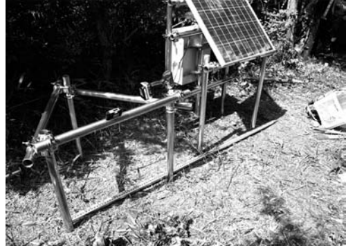
7-2 GNSS 機器設置状況 (ががら山山頂) (南西より)
