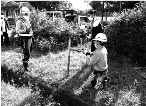
7-3 GNSS 機器設置作業風景 (野球場西側) (北東より)
