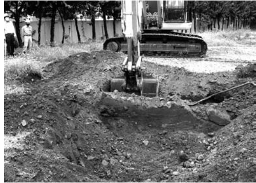
11-2 杭設置箇所確認（北より）
