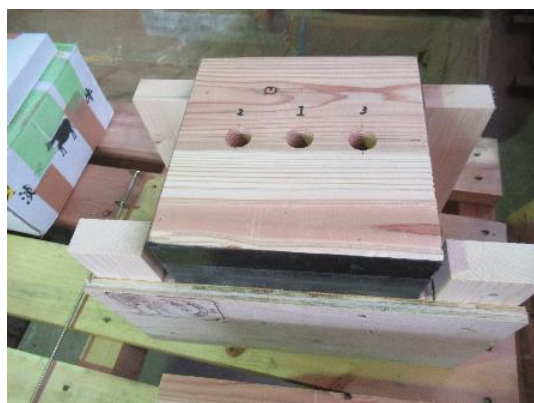
コンクリート打設前
