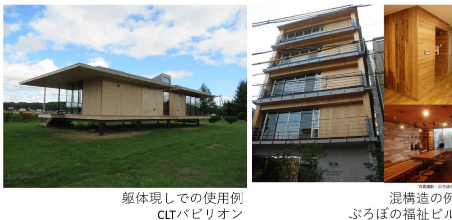
写真 1.2 非住宅分野での木質構造物の例
