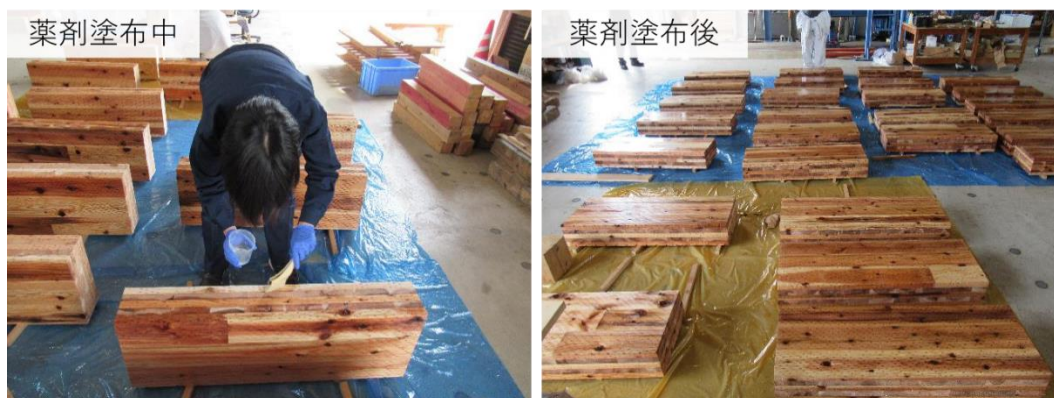
写真 3.4 薬剤塗布の様子
