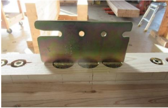
写真 6.2-2 せん断受け金物 (後施工金物 3)
