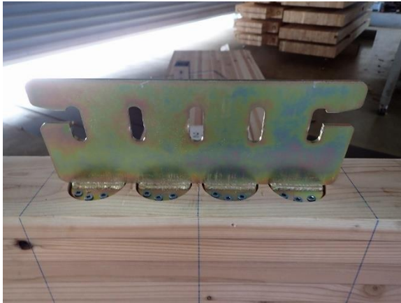
写真 6.2-3 せん断受け金物 (後施工金物 4)
