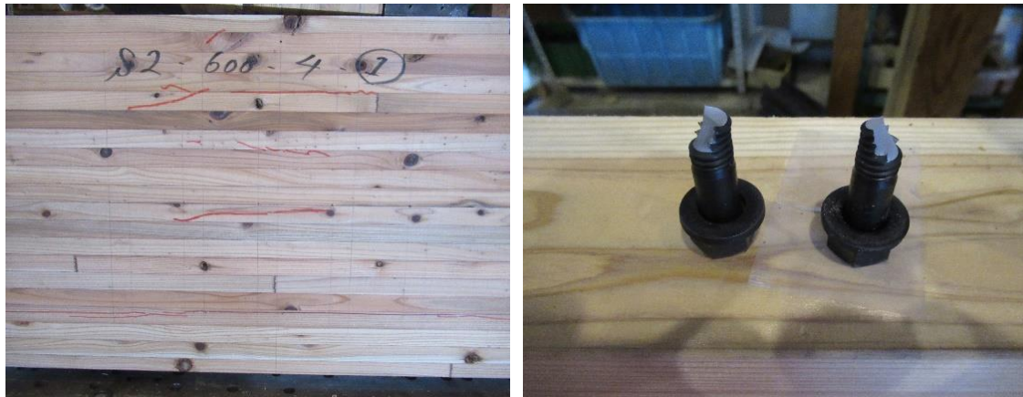
(i) 柱材の損傷
