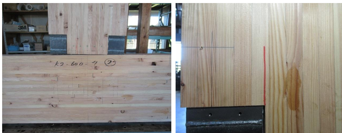
(i) 柱材の損傷
