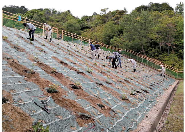
図 1 広島県廿日市市宮島町の一般廃棄物最終処分場の嵩上げ工事に伴う緑化場所の様子（2021 年 5 月）。緑化工に用いた地域性種苗については表 1 を参照。
