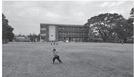
写真3 震災後に建て替えられた校舎 出典：筆者撮影
