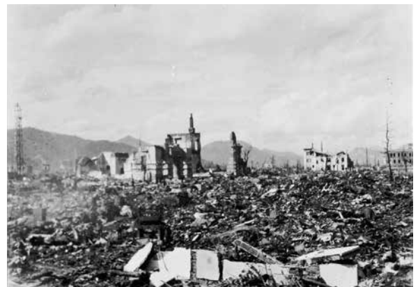
161. 広島県農業会広島支所(左)、広島瓦斯本社(右)の崩壊状況
