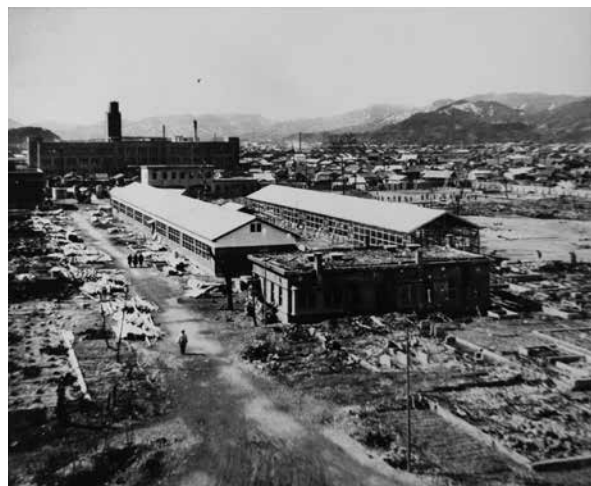
50. 千田町での校舎建築工事 （昭和22年初め）
