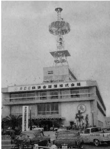
106. 落成した基町放送会館
