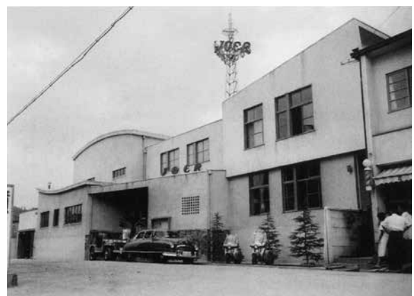
74. 上柳町に完成した放送会館
