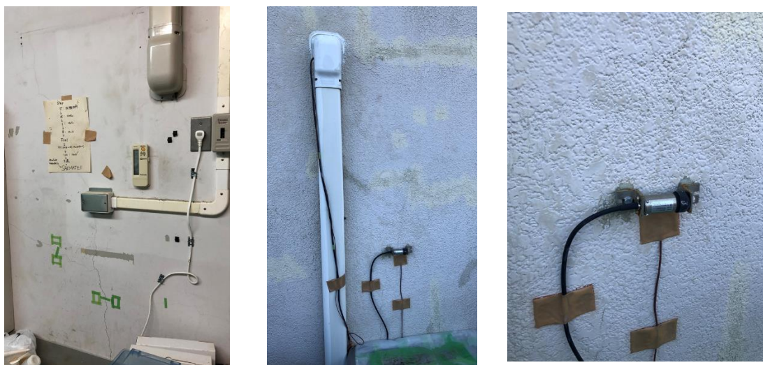
屋内側の恒温室の測定場所
