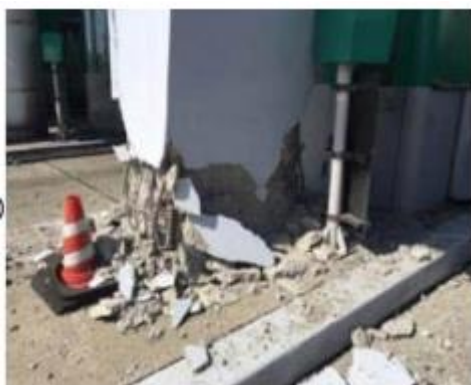
図 5-2 柱脚破壊 2)
