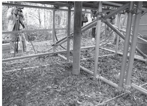
8-4 ボーリング 1 本目 (北東より)
