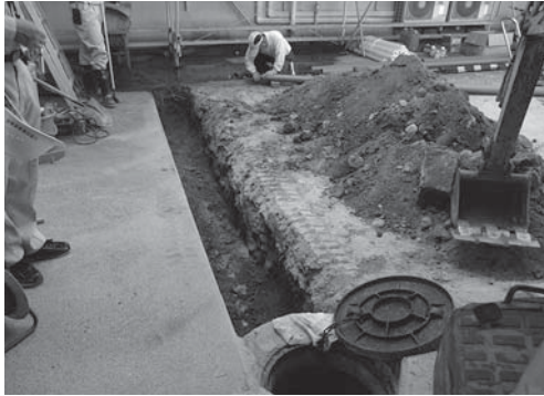
14-1 調査区掘削後全景（北より）
