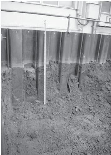
9-3 本体東端土層堆積状況（北西より）
