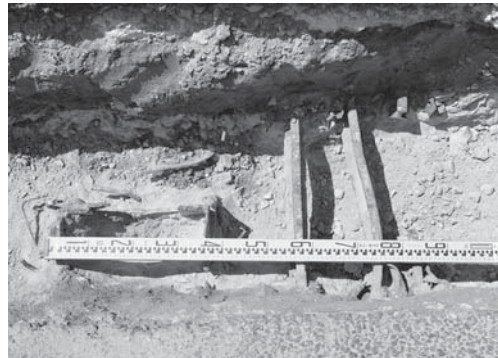
12-4 ガス管路レール・柱検出状況（東より）
