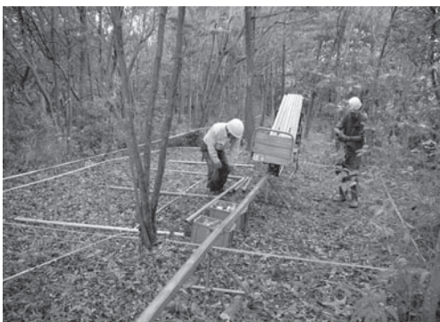
7-5 モノレール設置状況 4（西より）
