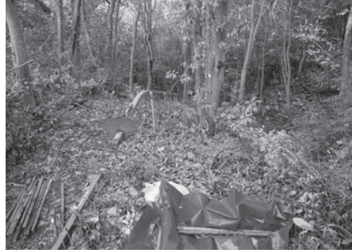
7-2 モノレール設置状況 1（東より）
