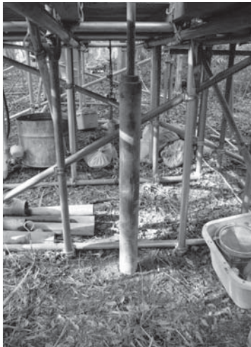
8-5 ボーリング 2 本目 (東より)
