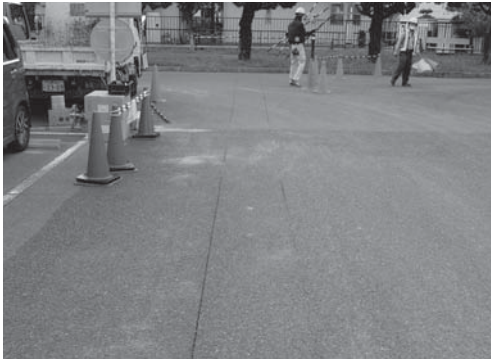
11-3 原医研西側ガス管路掘削前状況（北より）
