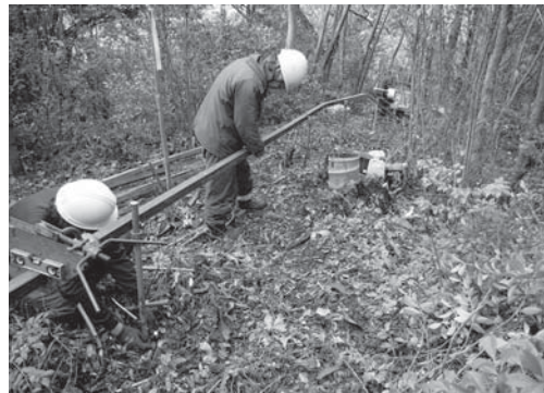
7-4 モノレール設置状況 3（北東より）
