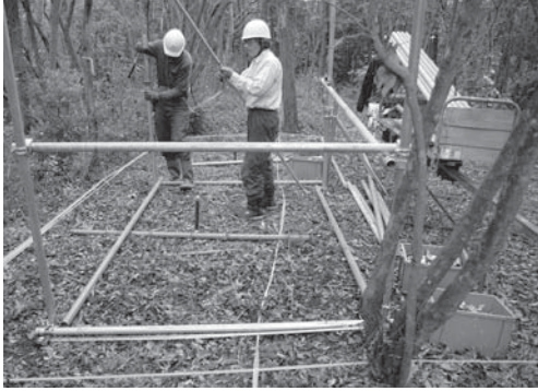
8-1 足場杭設置状況 1 (東より)
