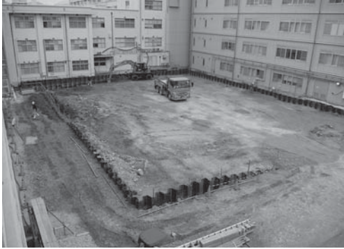
9-1 本体工事区全景（北西より）
