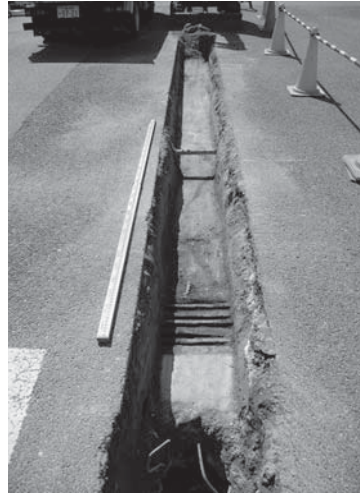
12-2 ガス管路レール検出状況（北より）
