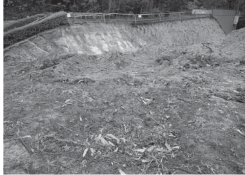
6-2 昨年度調査区1区と掘削部（南西より）
