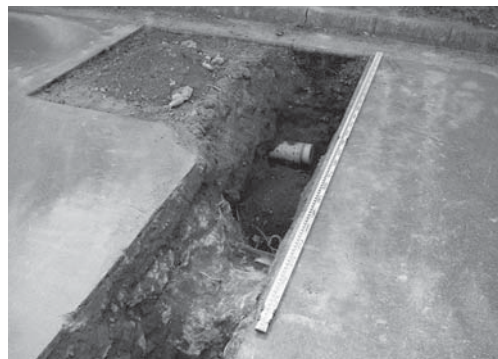
12-6 ガス管路南端部壁基礎検出状況（北西より）
