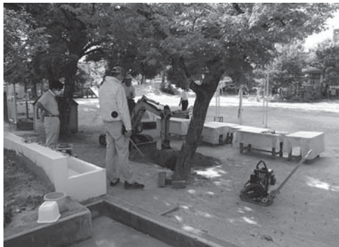
13-1 調査区掘削風景（北西より）
