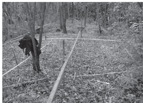
7-6 モノレール設置完了状況（西より）
