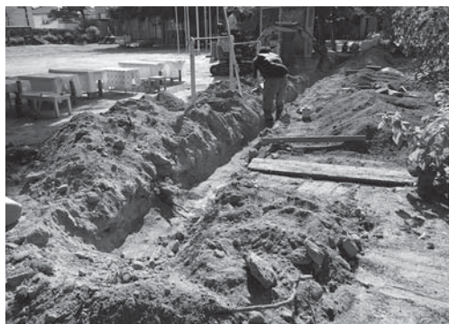
13-4 調査区掘削後全景（北東より）
