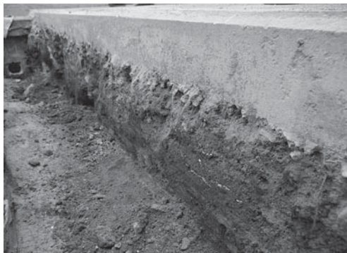
14-3 調査区東壁面（南西より）
