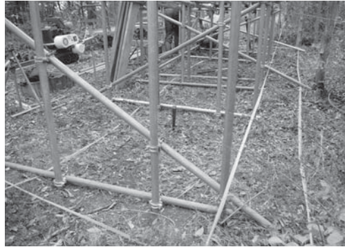
8-2 足場杭設置状況 2 (北東より)
