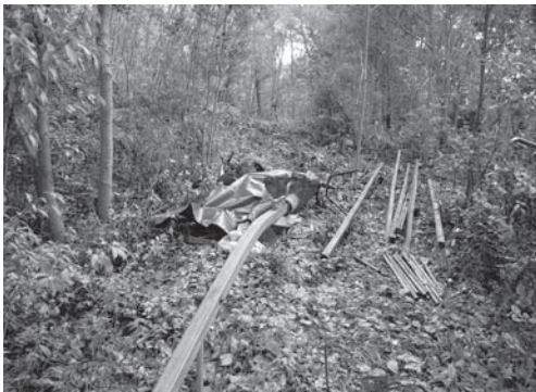
7-3 モノレール設置状況 2（西より）
