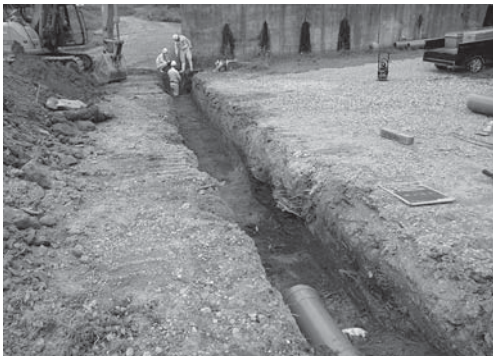
5-5 調査区平坦部掘削後全景（南より）
