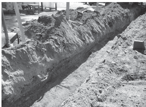
13-3 調査区東側南壁面（北東より）
