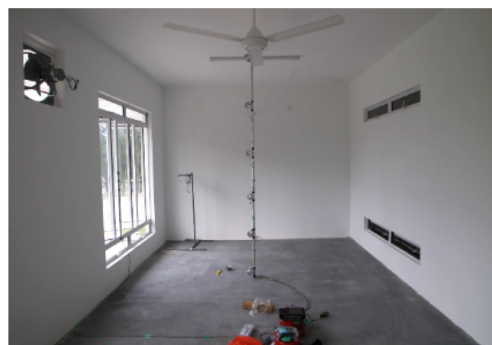
図 3.1 実験住宅の外観と主寝室内観
