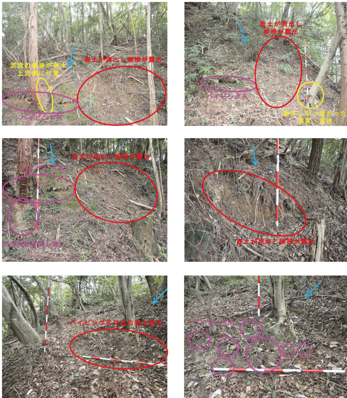
写真-2.2 調査箇所 No. 2 における地表流の流下痕跡（令和 2 年 8 月 8 日撮影）
