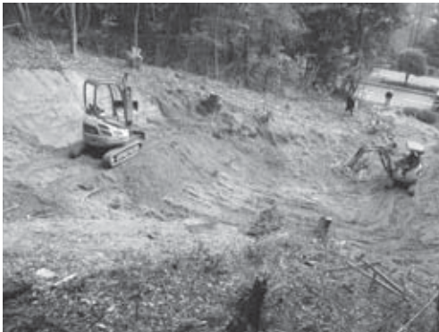
12-3 調査区北東部法面掘削状況（北西より）
