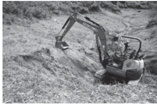
22-4 掘削の様子（西より）
