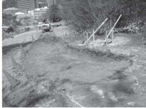
29-2 3区完掘状況（南東より）
