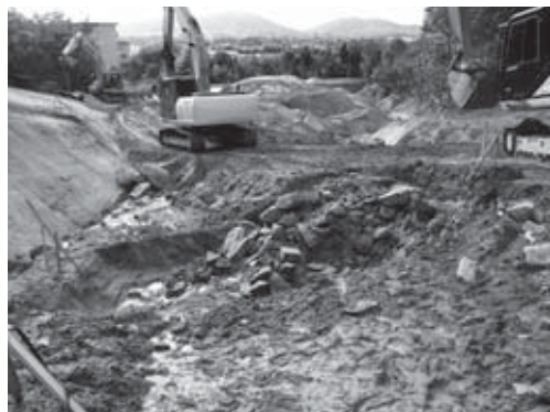
20-6 調査区中央部 11 区 (暗渠排水管支柱基礎) 掘削状況 (北より)
