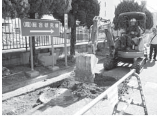
30-2 調査風景（1区）（北西より）
