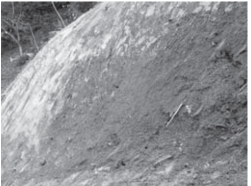
25-4 東側法面堆積状況（南西より）
