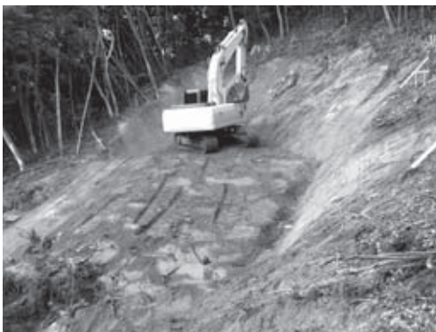
14-5 調査区北端部掘削状況（東より）
