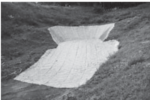
23-5 植生マット敷設後の様子（東より）
