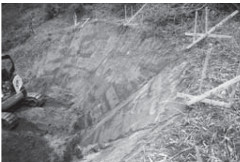
22-5 斜面成形状況（北東より）
