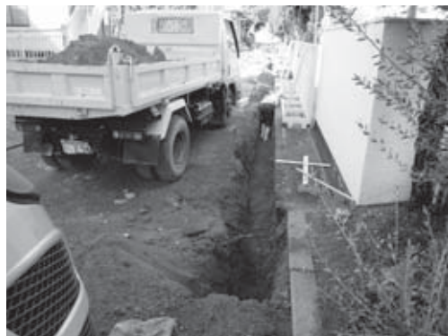
30-6 2区完掘状況（南より）
