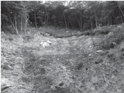
14-3 調査区北端部掘削前の状況（南より）
