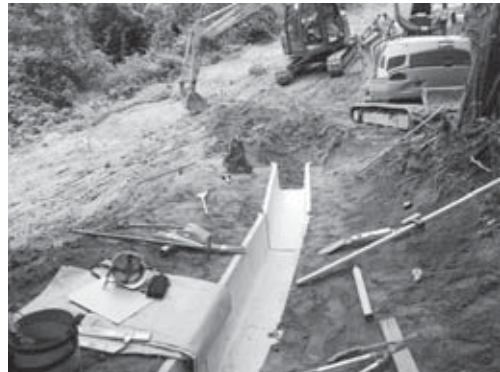
4-4 調査区中央部排水路設置状況（東より）
