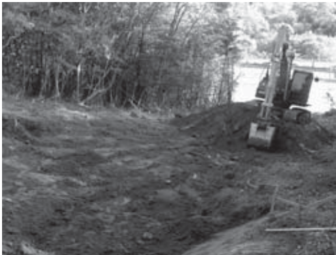
6-3 調査区北部掘削・成形状況（北北西より）
