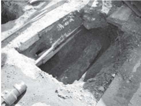
33-1 2区北半コンクリート構築物検出状況（北東より）
