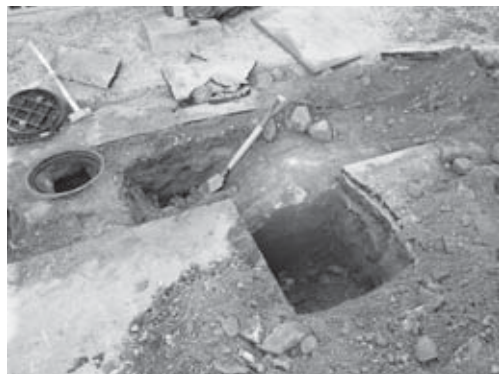
32-6 2区南半コンクリート構築下部確認状況（北西より）
