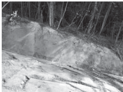
16-6 調査区東端部 No.23-22 水路 2・3 掘り方東 部法面完掘状況 (西より)
