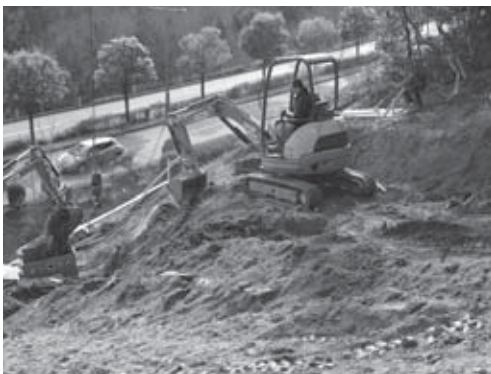
12-5 調査区南西端部掘削状況（北東より）
