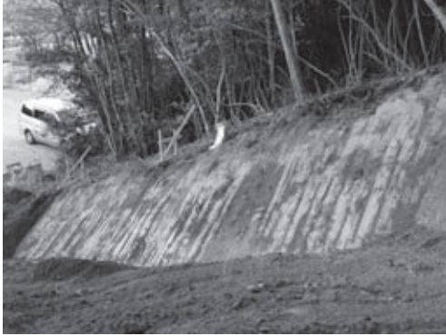
7-1 西側法面完掘状況 (No.2 -No.0) (北東より)
