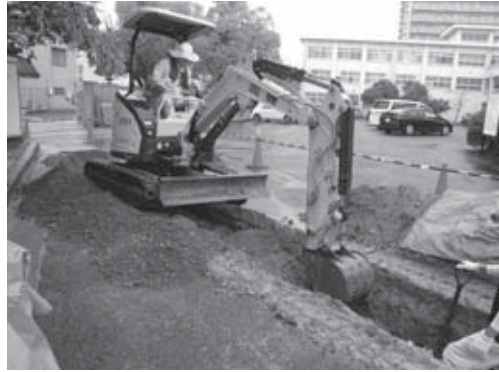
34-2 排水管掘り方掘削状況（南より）
