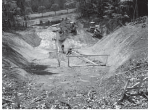
13-2 排水路掘削状況全景（北より）
