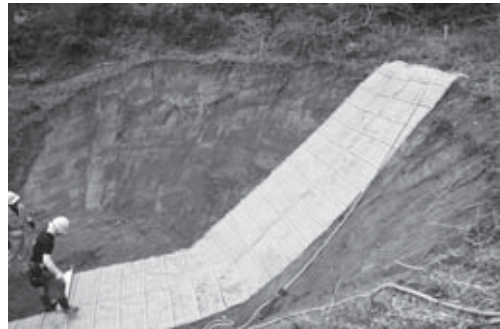
23-4 植生マット敷設の様子（北東より）
