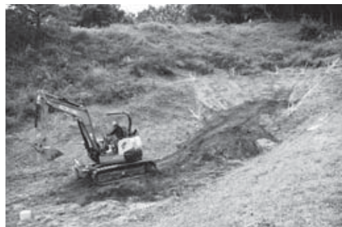
22-6 流出土壌の集積状況（北東より）
