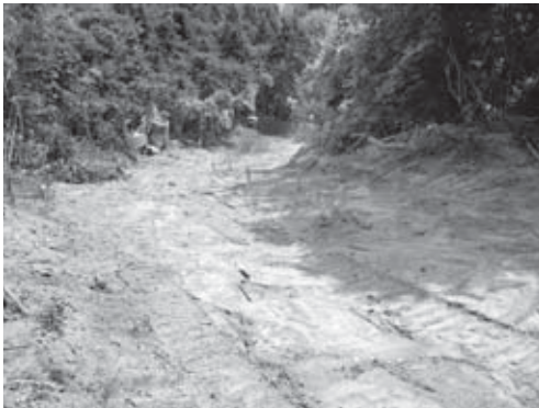
4-3 成形完了状況（北西より）
