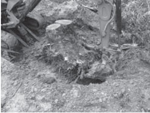
28-1 中木3 撤去状況 (南より)
