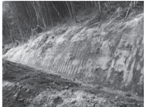
15-4 調査区北部 (No.28-26) 西側法面完掘状況 (北より)
