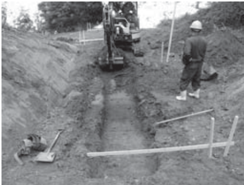
25-3 排水路掘り方北半部掘削状況（南西より）
