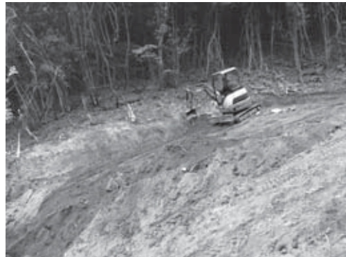
12-4 西側法面(No.0+5 - No.1)掘削状況（東より）
