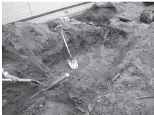
33-4 3区西半給水桝掘り方完掘状況（北東より）
