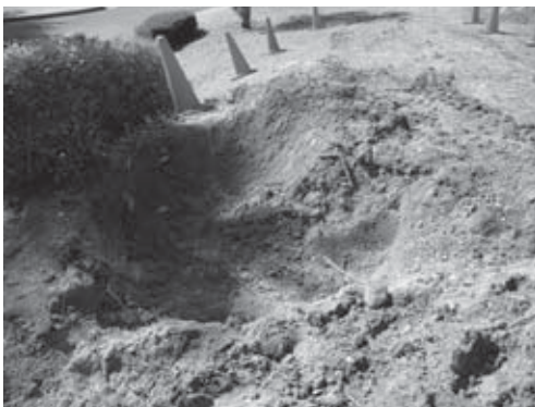
27-5 中木2 掘り上げ状況（東より）
