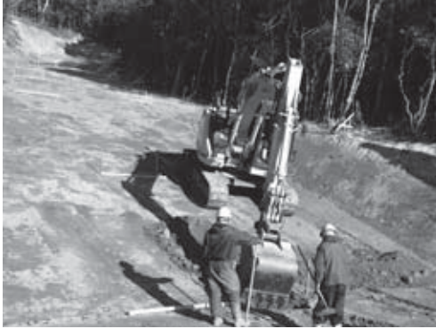
8-1 排水路掘り方掘削状況（南西より）
