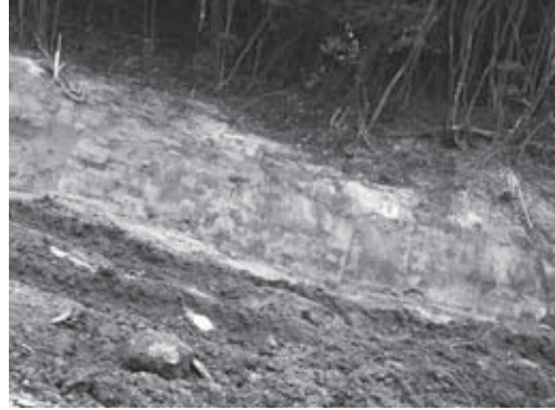
17-2 調査区中央部（No.20-19付近）中央水路東側法面完掘状況（西より）
