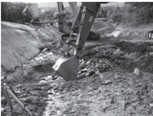
20-5 調査区中央部 11 区 (暗渠排水管支柱基礎) 岩盤掘削状況 (北より)
