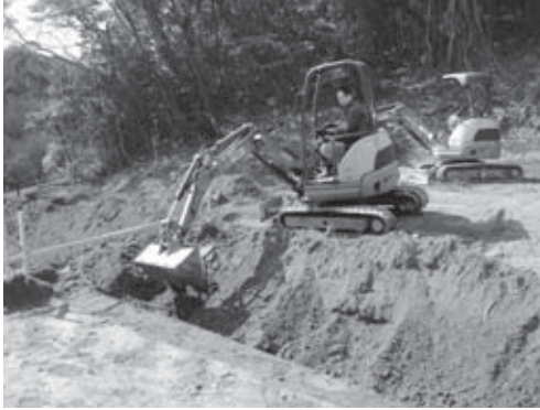
13-1 調査区南部排水路掘り方掘削状況（北西より）
