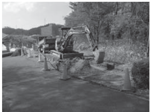
26-6 1・2区掘削状況（南東より）
