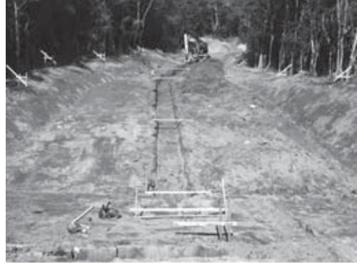
8-2 排水路掘り方掘削状況（南より）
