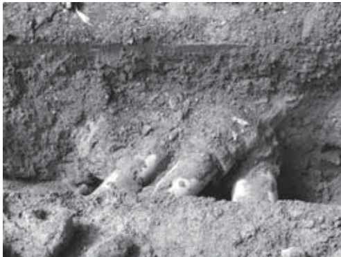
34-3 調査区中央部配管検出状況（北東より）
