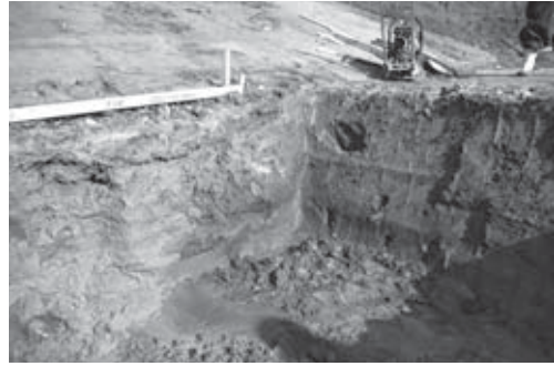
11-2 流路工南側集水柵部掘削状況（南西より）
