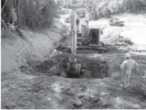
19-1 調査区中央部 3 区 (暗渠排水管支柱基礎) 掘削状況 (北より)
