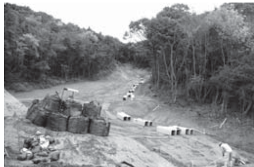
10-6 災害箇所掘削成形後全景（南より）
