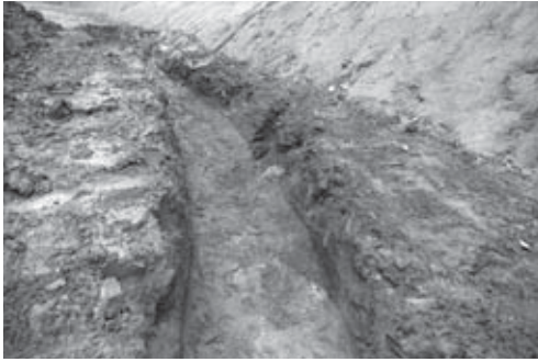
11-1 流路工北側掘削状況（南より）
