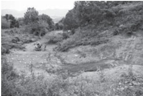
23-3 成形後全景（北西より）
