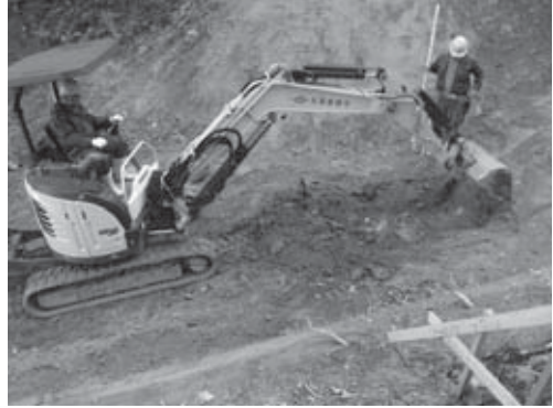
25-2 排水路掘り方北西端部の掘削状況（北西より）
