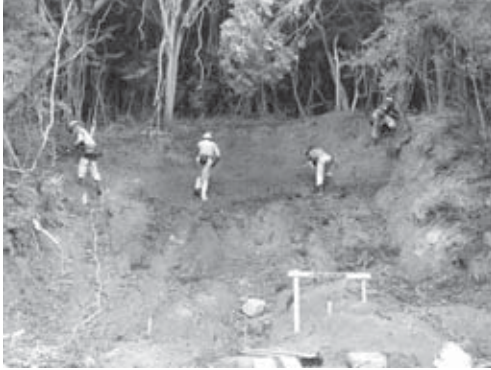
4-1 調査区北端部掘削状況（南より）
