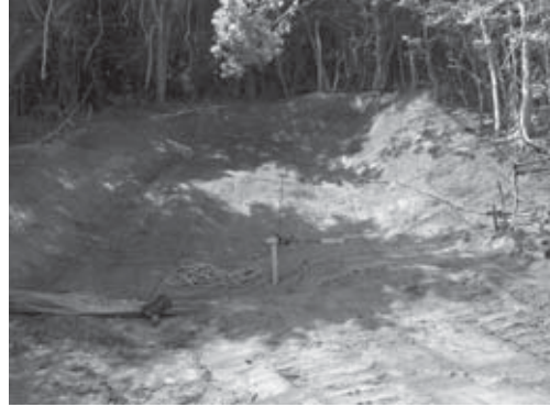
4-2 調査区北端部施工完了状況（南より）
