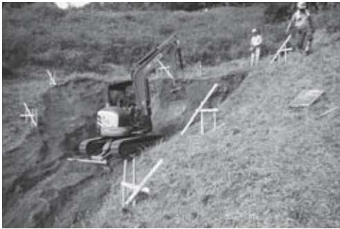
22-3 掘削の様子（東より）
