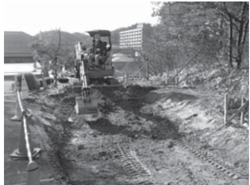
28-4 2区掘削状況 (東より)
