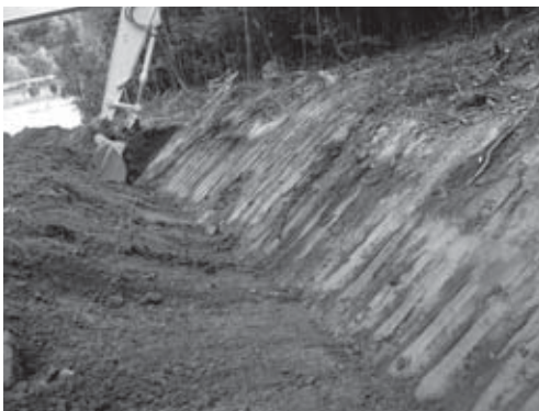
6-5 西側法面（No. 5 - No. 6）完掘状況（北より）
