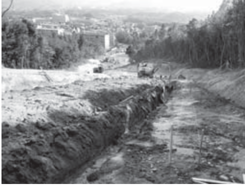
21-1 調査区北部～中央部1号水路・暗渠排水管掘り方南部掘削状況（北より）
