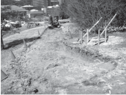
27-1 4区掘削状況（南東より）
