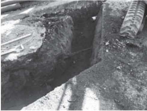
31-1 1区・2区境界柵部分掘削状況（南西より）
