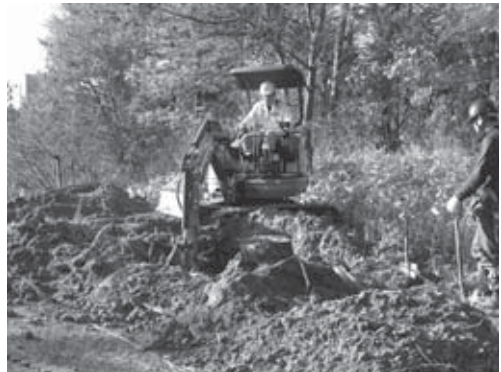
26-4 樹木撤去風景（中木3）（南東より）
