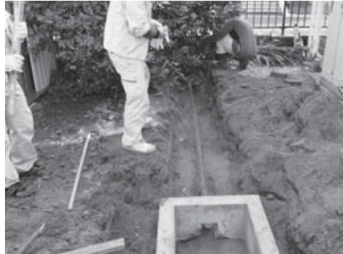
33-2 3区調査区完掘状況（西より）
