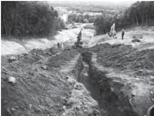
21-3 調査中央部2号水路・暗渠排水管掘り方掘削状況（北より）
