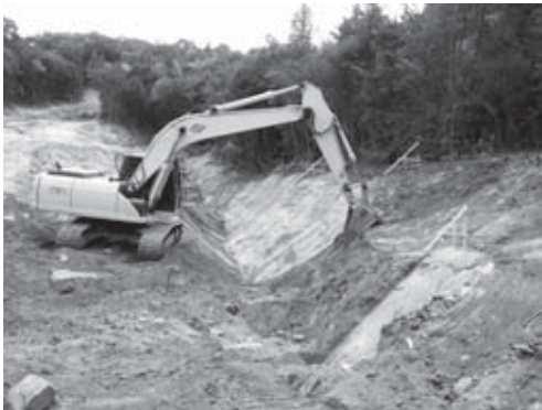
15-3 調査区北部 (No.16-15 付近) 東側法面掘削状況 (北より)
