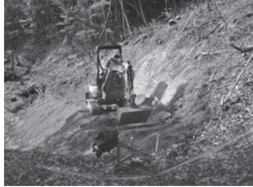
12-2 調査区北端部掘削状況（西より）
