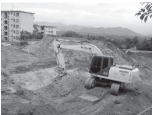
18-6 調査区南部試掘調査区2区掘削（削平）状況（北西より）
