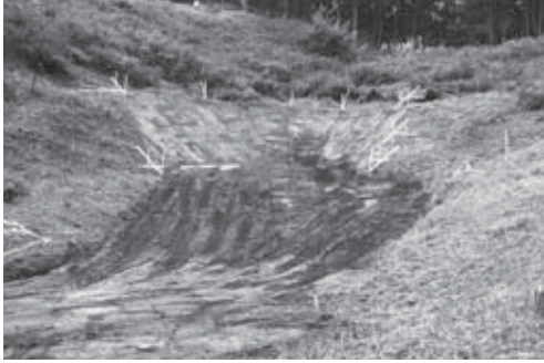
23-1 斜面成形後の状況（東より）
