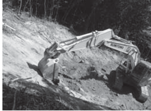
6-2 調査区北端部掘削状況（北西より）
