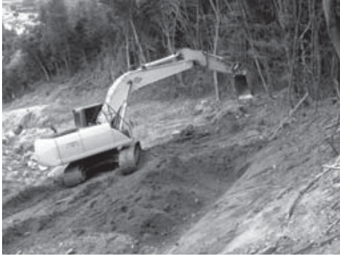
15-1 調査区北部 (No.26-25 付近) 西側法面掘削状況 (東より)
