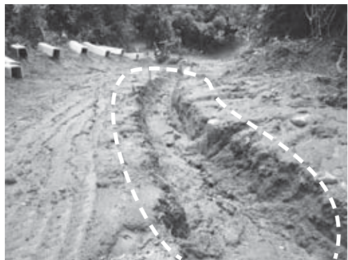
4-6 調査区北部～中央部排水路掘り方完掘状況 （北西より） （破線内は土器の出土範囲を示す）
