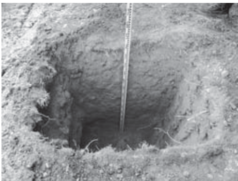
24-5 新設外灯基礎掘り方完掘状況（西より）
