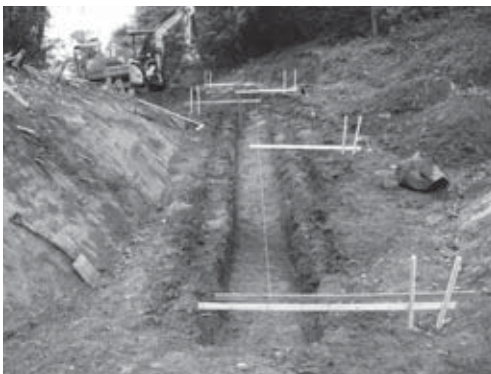
25-5 排水路掘り方完掘状況（南西より）
