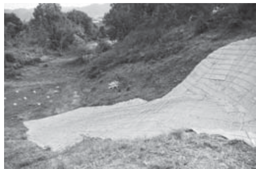
23-6 植生マット敷設後の様子（北西より）
