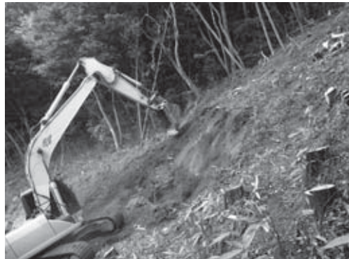
14-4 調査区北端の掘削状況（東より）
