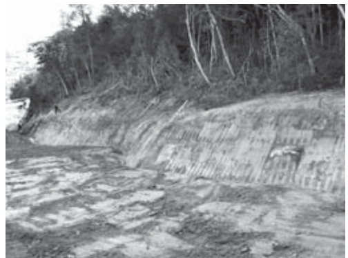
15-6 調査区北端部 (No.23-19 付近) 西側法面および床面削平状況 (北東より)
