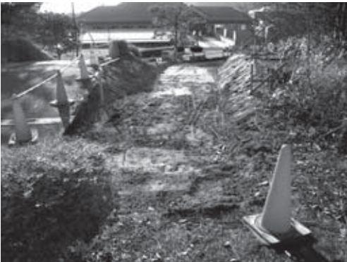
29-3 掘削作業完了状況（1～3区）（東より）
