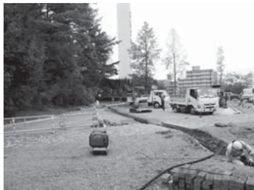
24-6 調査終了状況（南東より）
