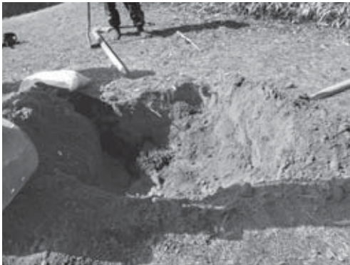
27-3 中木1 掘り上げ状況（東より）
