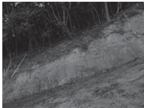
6-6 西側法面（No. 6 - No. 7）完掘状況（南東より）
