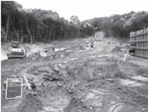
20-3 調査区中央部 9 区 (暗渠排水管支柱基礎) 完掘状況 (南より)
