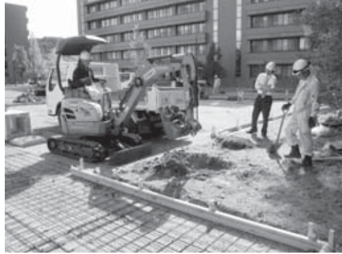
24-2 新設外灯基礎掘り方掘削状況（北西より）
