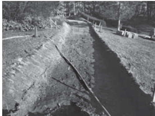
29-4 掘削作業完了状況（2～5区）（北西より）
