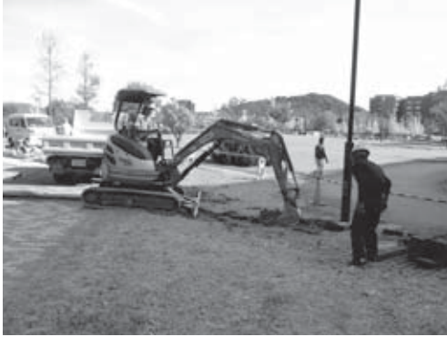
24-1 電気配管路掘り方掘削状況（南西より）
