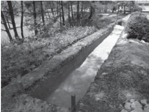
3-1 2 区完掘状況 (西より)
