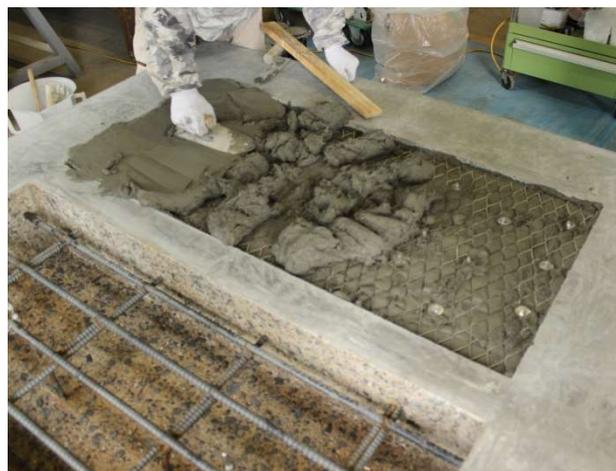
写真 5-6 モルタルの打込み状況
