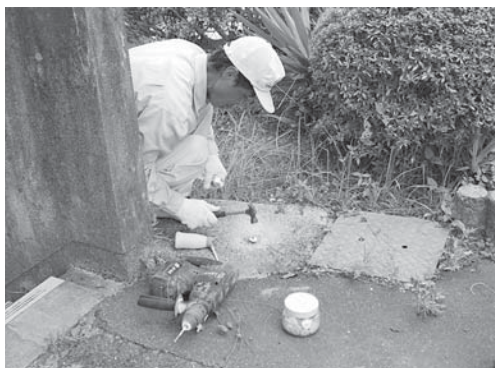
写真 103 杭設置の様子 1
