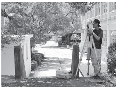
写真 104 杭設置の様子 2
