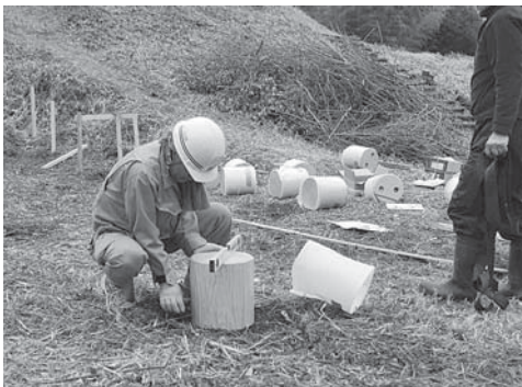
写真 60 擬木設置作業の様子 2
