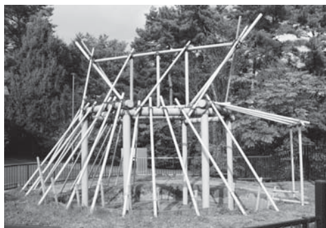
写真 63 蔓取替作業完了状況
