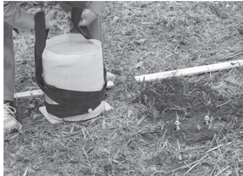
写真 59 擬木設置作業の様子 1
