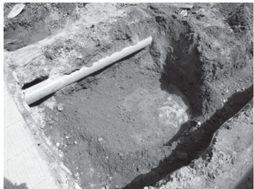
32-4 6区兵器支廠造成土露出状況（南より）
