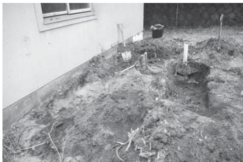
38-1 1区掘削風景(南東より)
