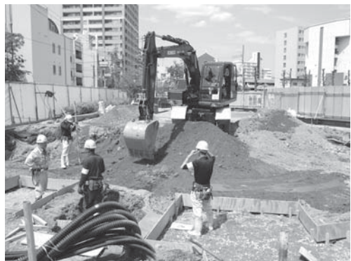
32-6 10区掘削状況（南より）
