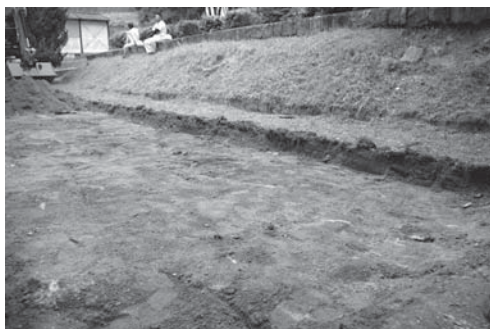
38-6 2区掘削後(南東より)
