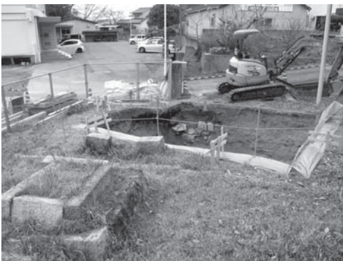
36-5 完掘状況（東より）
