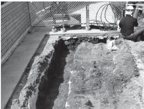
32-3 外構工事地区（3・5～9区掘削完了状況） （北東より）
