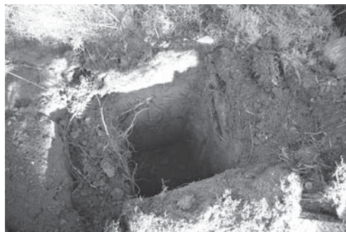
39-2 基礎抜き取り後（南より）
