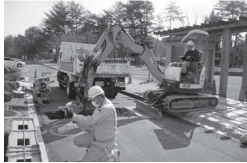
31-2 掘削状況（西より）
