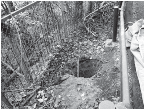
35-3 電柱基礎掘り方完掘状況（北西より）
