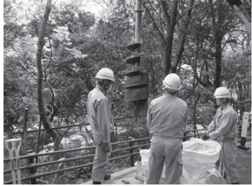
35-2 機械掘削(ドリル)による堆積土排出状況(西より)
