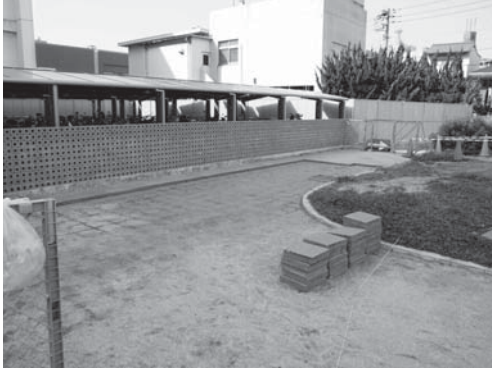
32-1 外構工事予定地区（4～9区）全景（北より）
