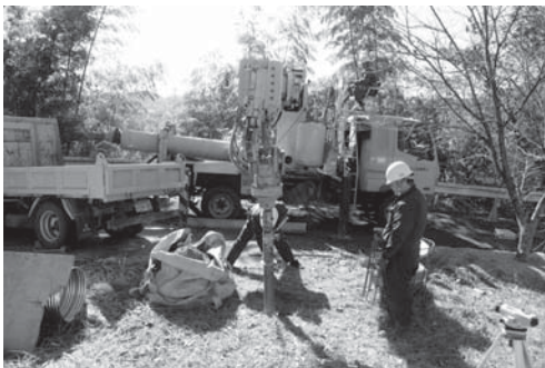
30-2 機械（ドリル）による掘削状況（北より）
