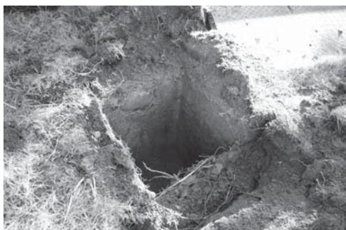
39-3 基礎抜き取り後（西より）
