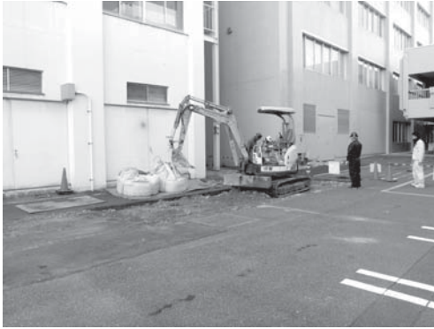
23-1 調査区全景（北東より）
