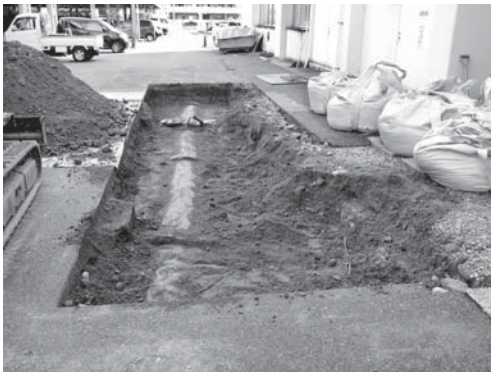
23-3 完掘状況（西より）
