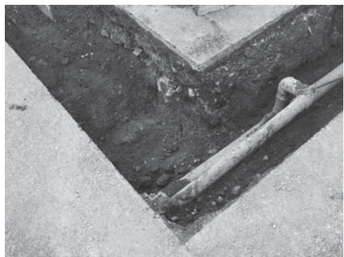
25-6 2区西端部南北コンクリート壁検出状況（西より）
