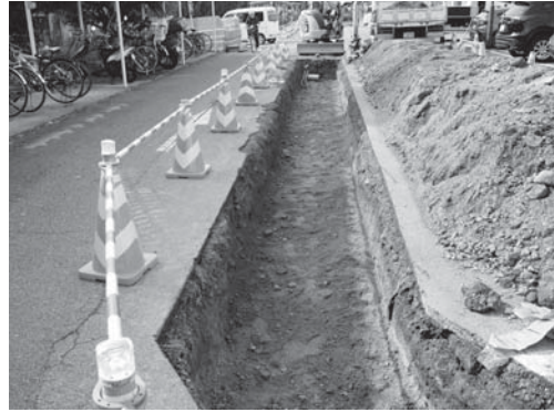
18-2 3区完掘状況（東より）
