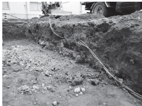
19-6 コンクリート床2撤去状況とコンクリート床断面 （南より）
