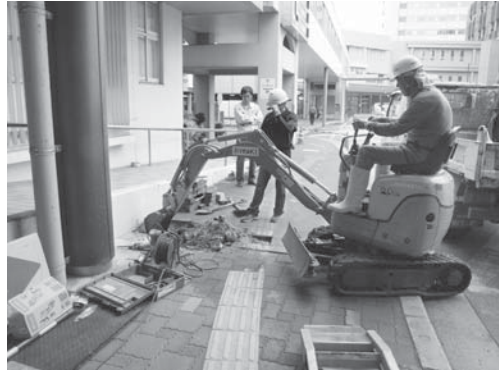
12-2 支柱掘り方（1区）掘削状況（北より）
