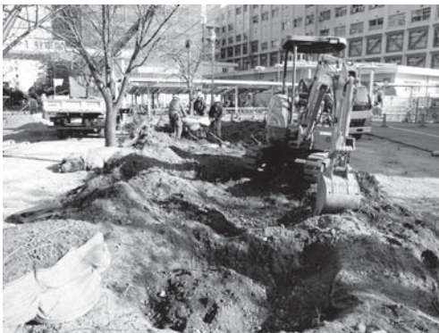
13-5 5区高木移設状況と1～4区完掘状況(西より)
