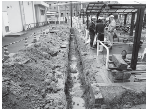
21-4 完掘状況 (東より)
