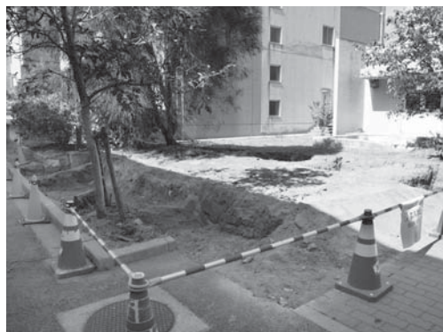
8-6 駐輪場D・20～23区完掘状況（南西より）
