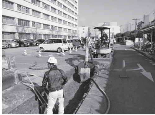
16-2 1区掘削状況（西より）
