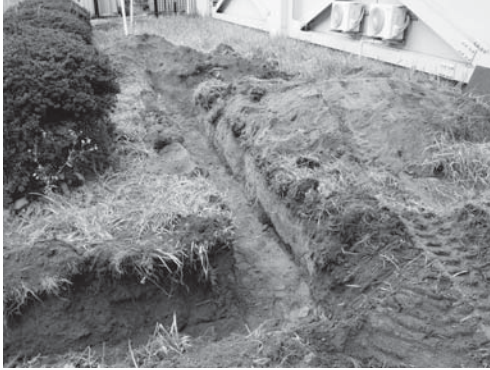
15-1 2区完掘状況（東より）
