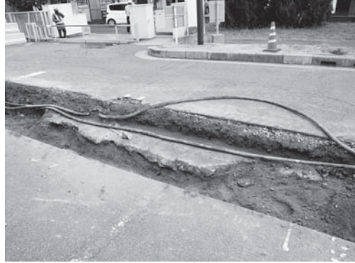
17-2 1区コンクリート床（東半部）検出状況（北西より）
