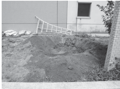
9-4 駐輪場D高木移設先掘り方完掘状況（南より）
