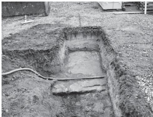
14-3 1区コンクリート床検出状況（北より）
