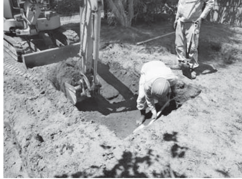
8-2 駐輪場D屋根支柱基礎掘り方掘（18区）削 状況（南東より）
