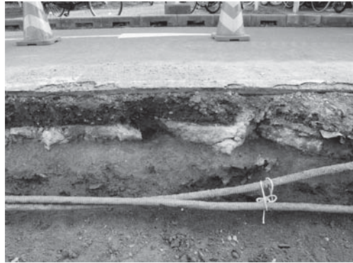
17-4 1区コンクリート床（西半部）断面（北より）
