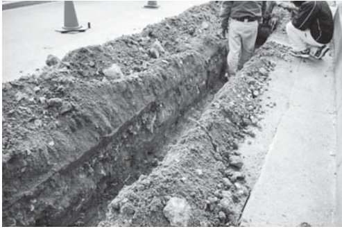
26-1 1区掘削後（南西より）
