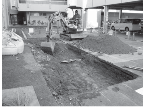
23-2 掘削状況（南西より）
