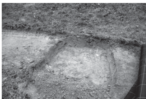
6-6 西側暗渠排水掘り方完掘状況（南より）
