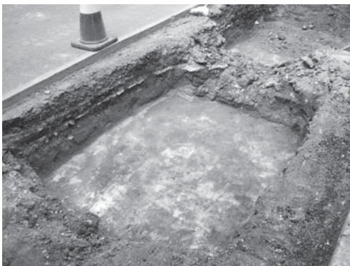
10-5 駐輪場E・4区コンクリート床検出状況（南東より）
