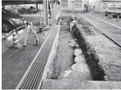
19-2 コンクリート床1検出状況（南より）
