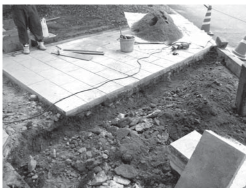
24-4 縁石掘り方完掘状況（北西より）
