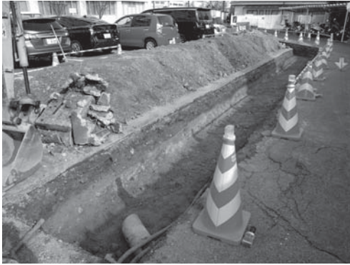
18-1 3区堆積状況（南西より）
