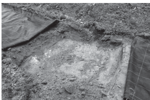
6-5 東側暗渠排水掘り方完掘状況（南より）
