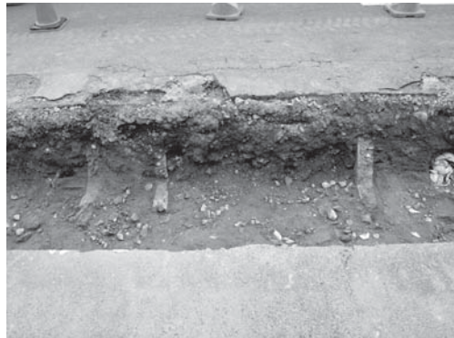
16-4 1区コンクリート構築物撤去状況（北より）
