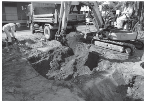
7-2 駐輪場C屋根支柱基礎掘り方 (10 区) 掘削状況 (北より)
