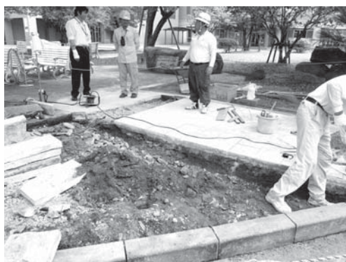
24-3 土系舗装範囲完掘状況（西より）
