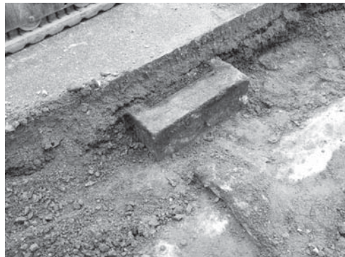
23-4 コンクリート構築物（南より）
