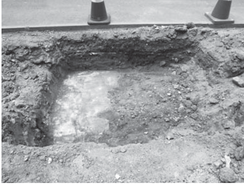
11-1 駐輪場E・6区コンクリート床検出状況(東より)
