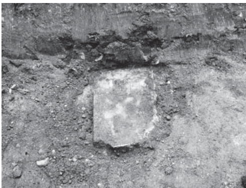
10-3 駐輪場E・1区構造物検出状況（北より）
