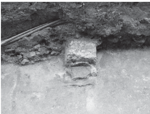
19-5 コンクリート床2中央部煉瓦コンクリート構築物 （西より）
