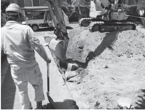
9-1 駐輪場D調査区南縁石垣撤去状況（東より）
