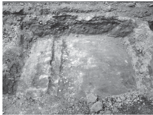
10-4 駐輪場E・2区コンクリート基礎、コンクリート床検出状況（東より）
