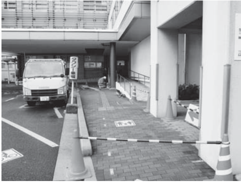
12-1 調査区全景（南より）
