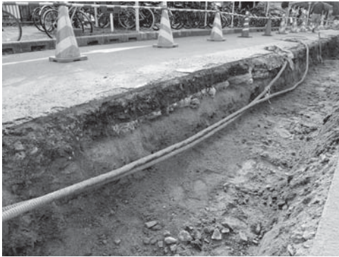
17-3 1区コンクリート床撤去状況（北東より）
