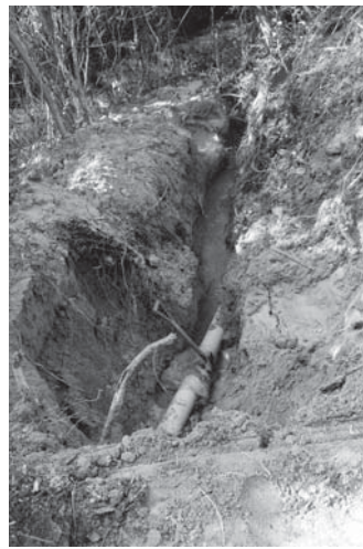
4-4 排水用溝掘削完了状況（北東より）
