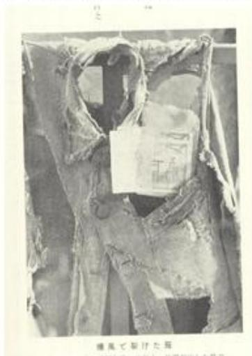
上着は大きく破損・焼損しているが、ポケットの中の紙幣には損傷は見られない。
