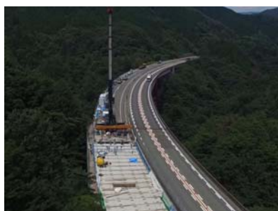
図-1.1 高速道路の橋梁床版取替え工事の事例（左：工事全景、右：床版取替え状況）
