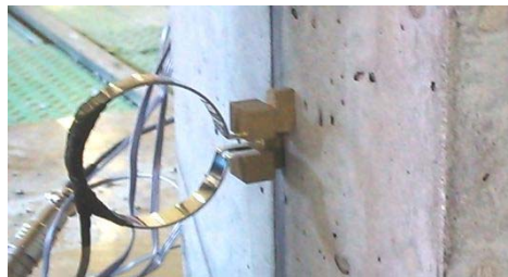
図-3.4 クリップ型変位計によるずれ計測
