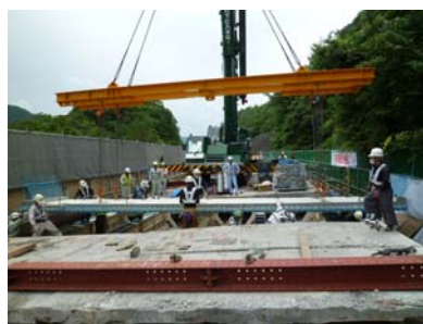
図-1.1 高速道路の橋梁床版取替え工事の事例（左：工事全景、右：床版取替え状況）
