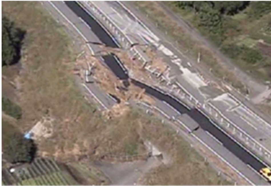
写真 1.3 関越道堀之内地区
