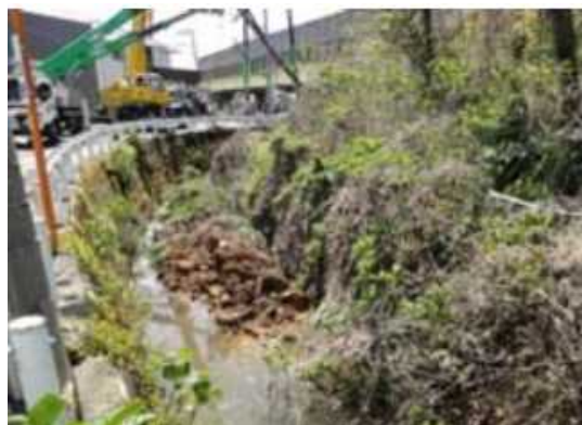
写真 1.6 盛土のり面状況
