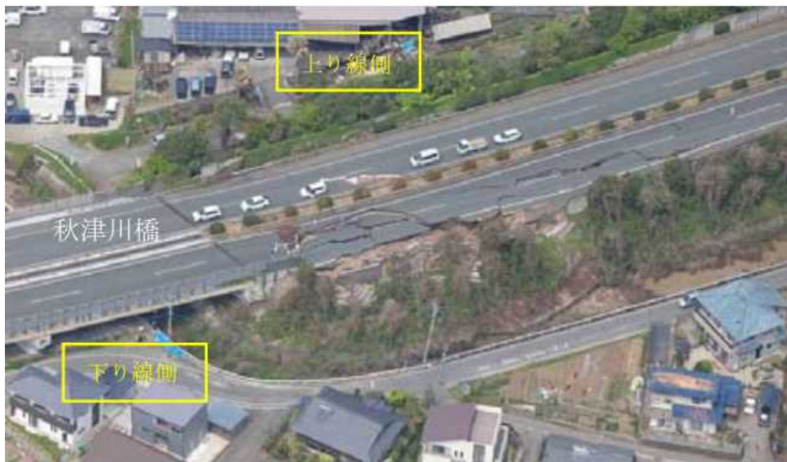
写真 1.5 九州自動車道 益城地区
