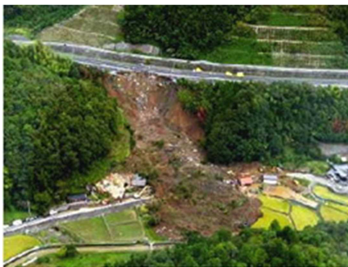
写真1.8 山陽車道甘木地区
