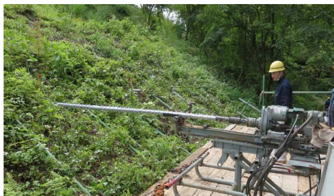
写真 2.1 SDPR の施工状況 (遠景)
