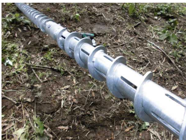
写真 2.2 SDPR の施工状況 (近景)
