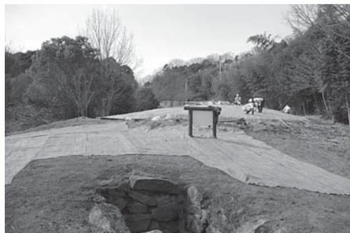
写真 50 ティフブレアシート設置後
