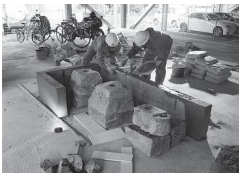
写真 51 外枠モルタル塗り作業
