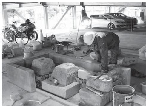
写真 52 ガンコマサの充填・成形作業
