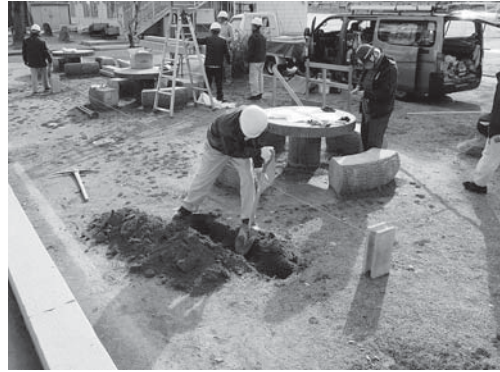
6-2 休憩所側溝掘り方掘削状況(北西より)
