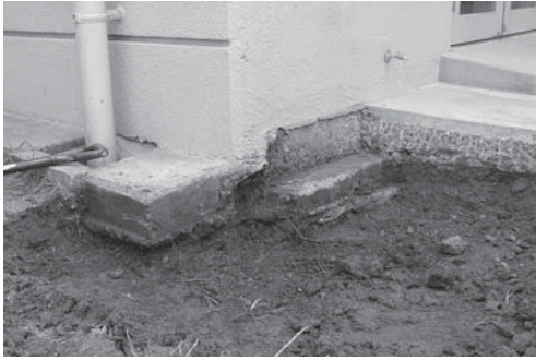
7-1 1区掘削後（南西より）
