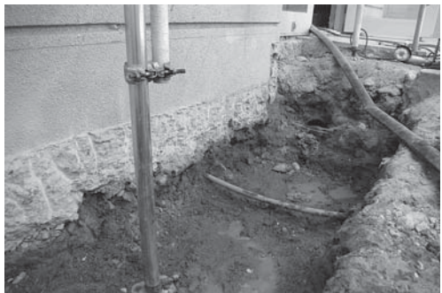
7-6 4区掘削後北側（南東より）
