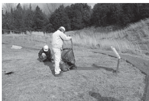
写真5 山中池南遺跡第2地点須恵器焼成窯跡改修工事盛土状況（北西より）
