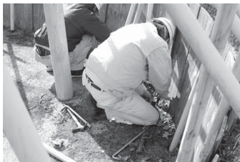
写真4 鴻の巣南遺跡復元住居改修工事掘削状況（北より）
