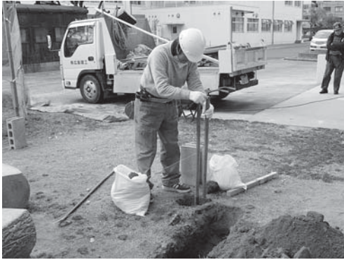
6-1 休憩所支柱掘り方(3区)掘削状況(北東より)
