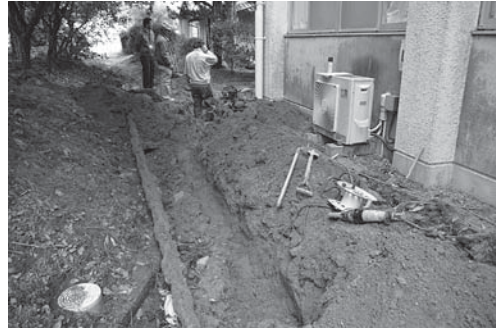
8-2 2区東端掘削状況(西より)
