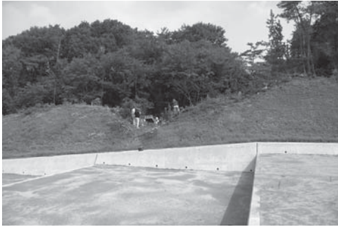
2-1 調査区全景（南より）
