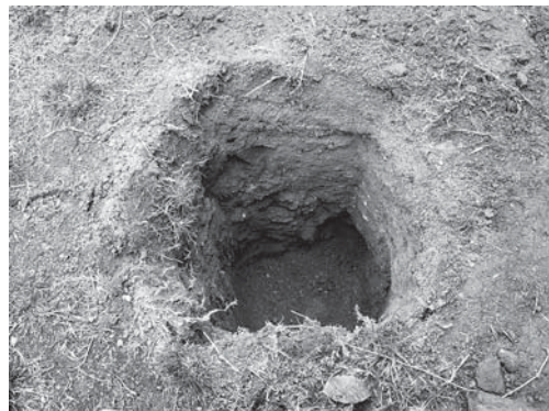
6-6 休憩所支柱基礎掘り方10区完掘状況(南より)
