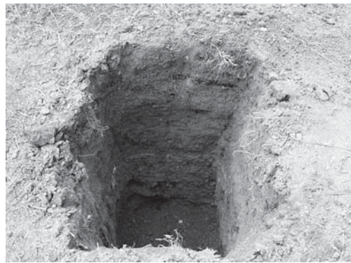
6-4 休憩所支柱基礎掘り方8区完掘状況(東より)
