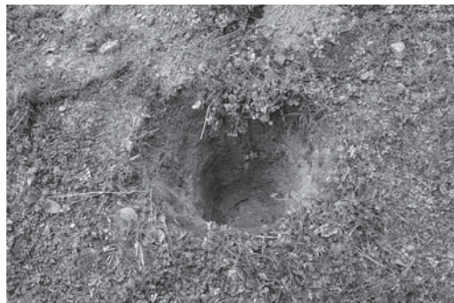
9-4 No.7 アース掘り方完掘状況（東より）
