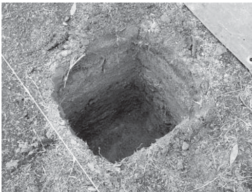
6-5 休憩所支柱基礎掘り方9区完掘状況(南東より)
