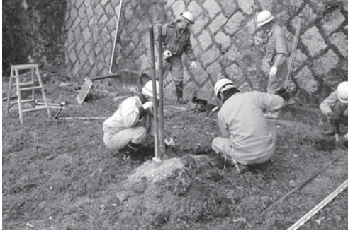
9-1 受電設備等修繕掘削状況（北東より）
