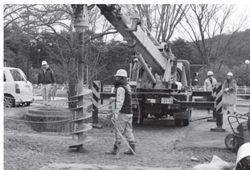
3-2 作業風景（西より）
