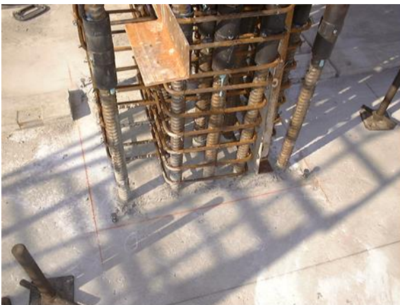
写真 4.17 墨出しおよび レベル調整用ボルト用インサート
