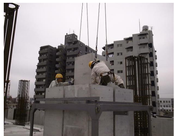
写真 4.20 シェルコラム吊り揚げ
