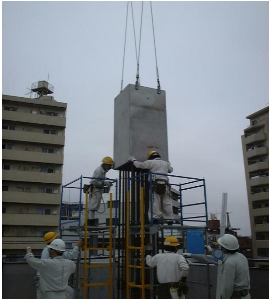
写真 4.21 シェルコラム吊り込み 1
