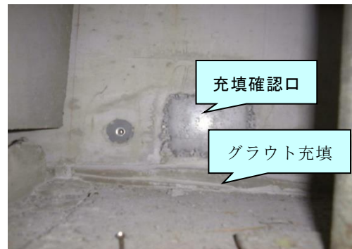
写真 4. 36 柱脚部後打ちコンクリート充填状況
