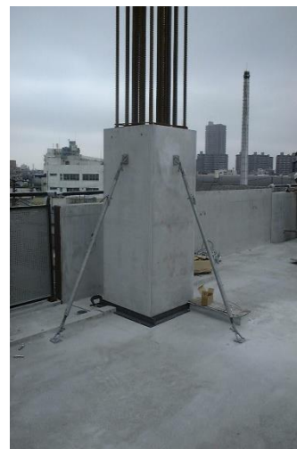
写真 4.26 シェルコラム取付け完了
