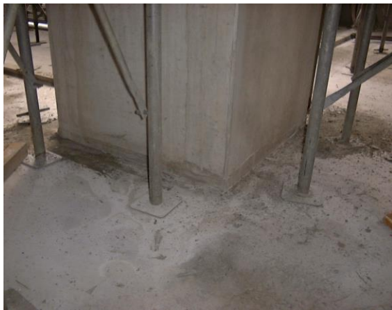
写真 4.29 柱脚部充填状況
