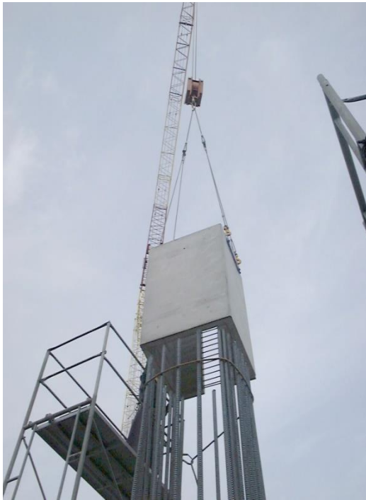
写真 4. 33 シェルコラム建て方
