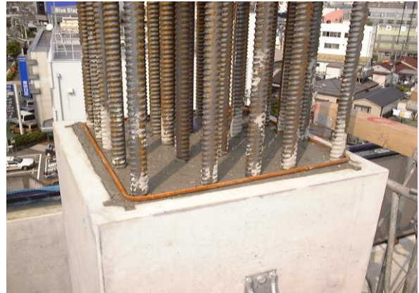
写真 4.28 柱コンクリート打設天端
