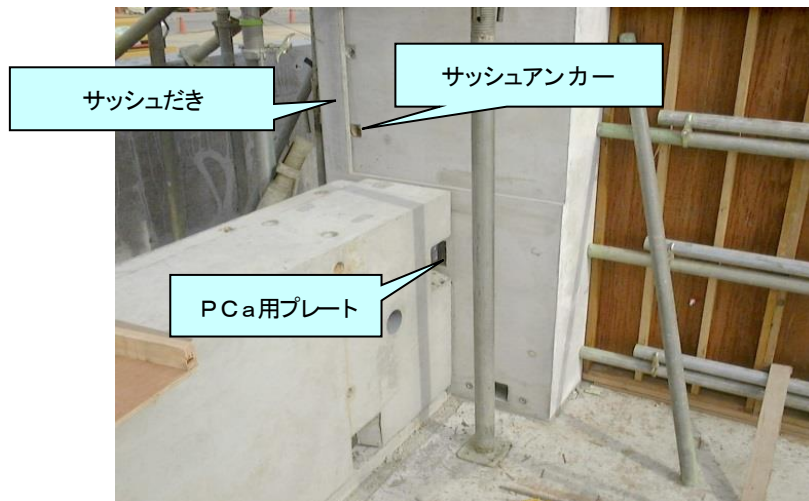
写真4.37 シェルコラムのサッシュアンカー，だき およびPCa用プレート打込み状況
