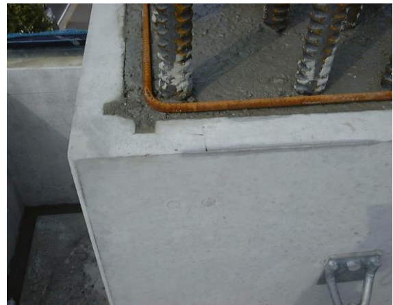
写真 4.30 シェルコラム天端梁位置墨出し
