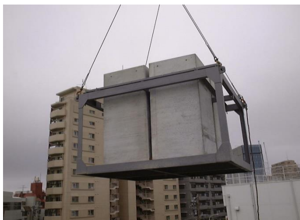
写真 4.19 パレット荷揚げ
