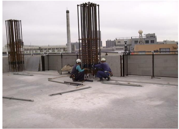
写真 4.16 柱筋継手部中子筋配筋
