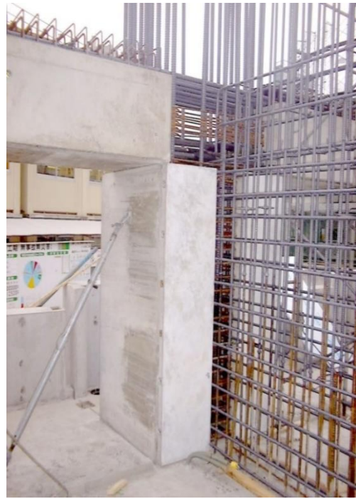
写真 4. 34 シェルコラムの建入れ調整と壁配筋
