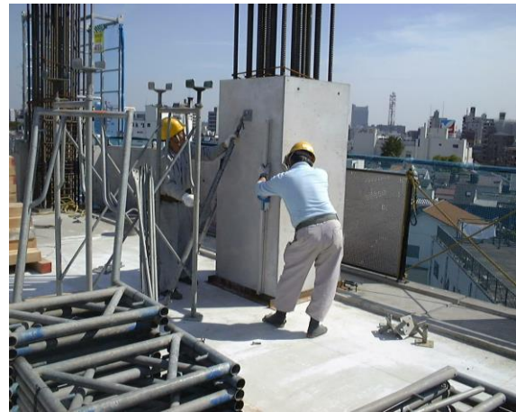
写真 4.24 押しきサポート取付け
