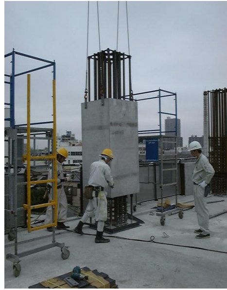
写真 4.22 シェルコラム吊り込み 2
