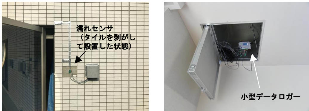
写真 5.5 タイル裏面濡れセンサ設置状況と天井内ロガー設置状況
