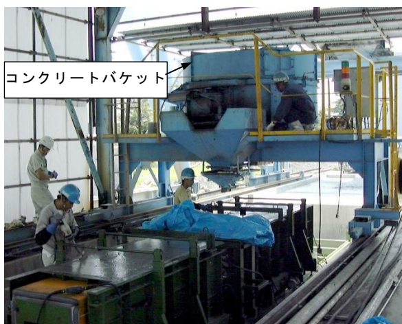
写真 4.2 コンクリートの打設状況
