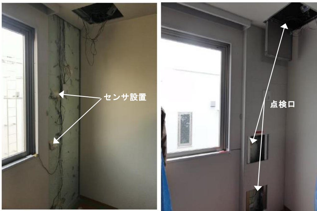
写真 5.6 居室内壁のセンサ設置状況と復旧後状況
