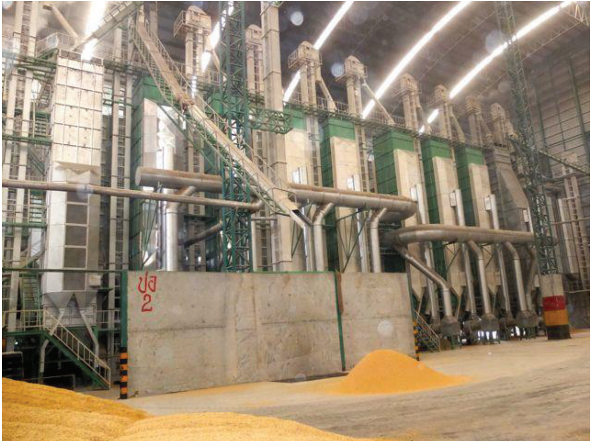
写真 3-3 熱交換型連続流下式乾燥機
