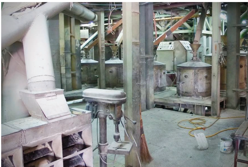
写真 4-3 A 精米工場の工場内部
