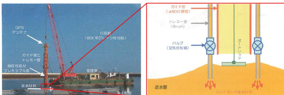
図-1.13 遮水地盤材料の打設方法<sup>23)</sup>
