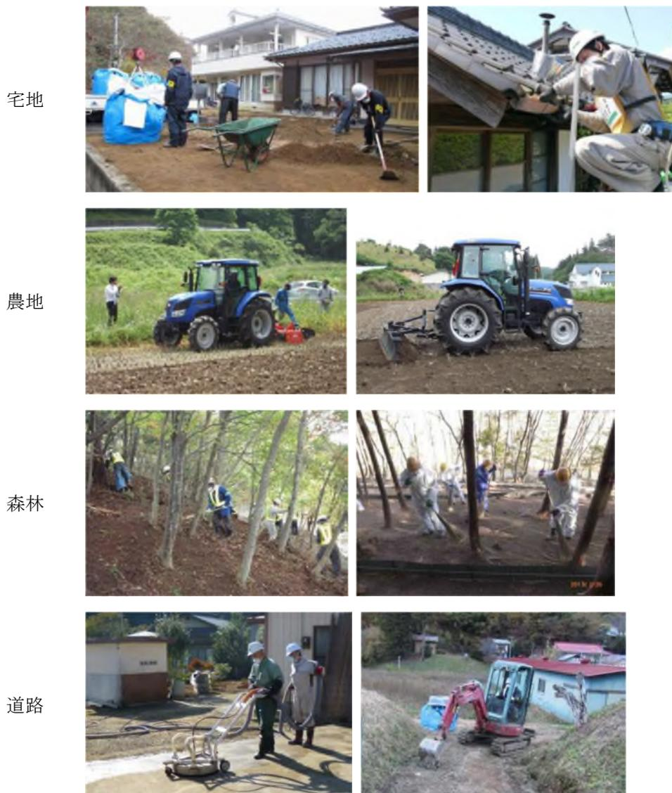
図-1.3 除染作業の例<sup>7)</sup>
