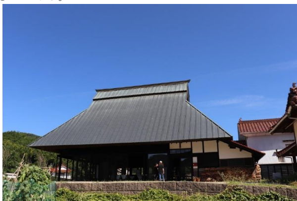
図2 古民家「星降るテラス」の外観
