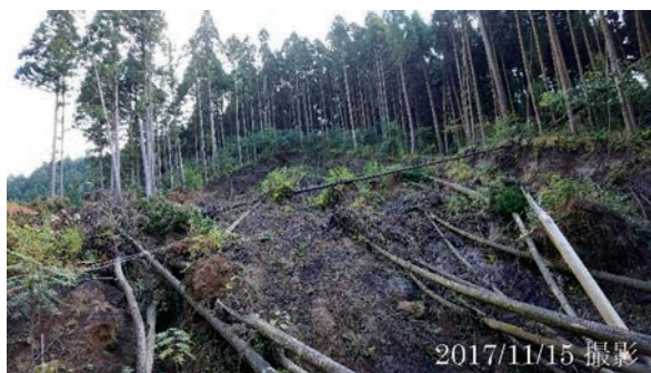
写真5 山王谷川砂防堰堤付近の左岸側地すべり
