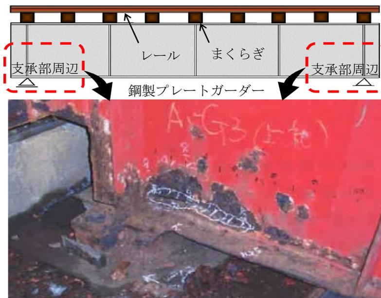
図 4.1 支承部周辺のウェブと下フランジ間の剥離状況
