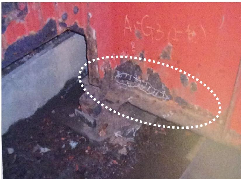
図 1.5 支承部近傍の劣化腐食および分離（ウェブと下フランジ間）状況（国内）
