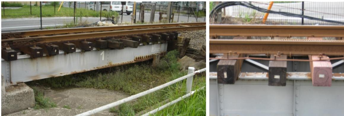
図 1.4 一般的な鋼製プレートガーダー鉄道橋（国内）
