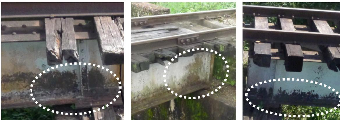
図 1.6 支承部周辺の劣化腐食状況（海外）
