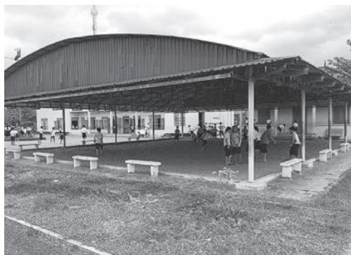
写真2 屋根付きの運動施設
