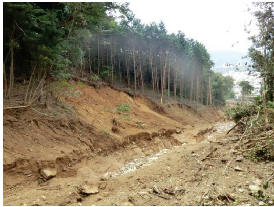
a) 土砂流出状況
