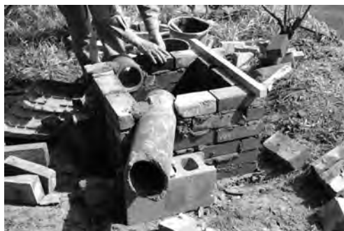
写真 106 レンガ組み柵設置の様子 2
