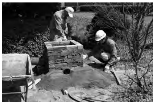
写真 107 レンガ組み柵設置の様子 3
