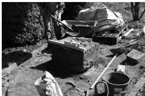
写真 105 レンガ組み柵設置の様子 1
