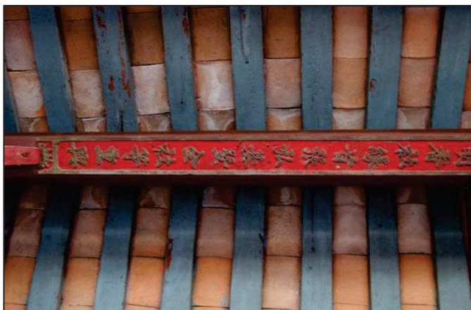
写真8 来遠橋の修復棟木に「張宏基」(張A族の三代目) 写真 澤田
