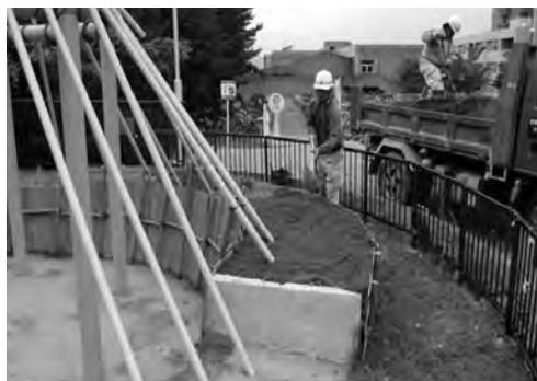
写真168 竪穴住居周堤への盛土作業状況(2)
