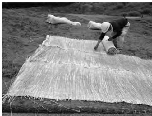
写真 142 ティフブレア敷設作業状況 (2)
