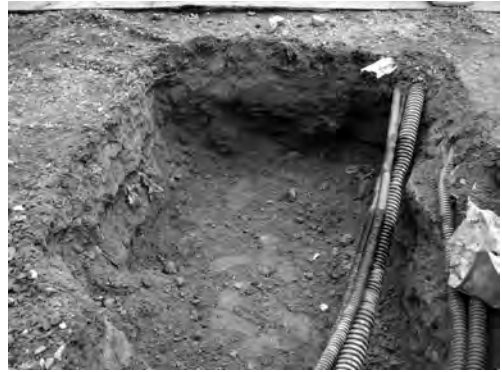
写真 76 ロータリー北通路屋根取設その他工事 27区完掘状況 (東より)
