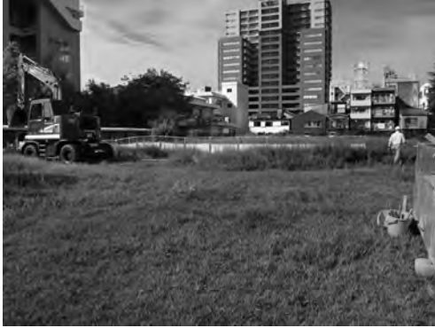
写真 81 知的人材育成センター新営工事近景 (東より)
