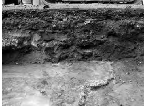
写真 7 霞会館北側渡り廊下設置工事 2 区西壁煉瓦構築物断面状況（東より）
