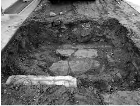
写真 75 ロータリー北通路屋根取設その他工事 24区切石コンクリート構造物検出状況 (北より)
