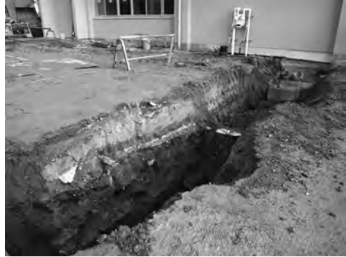
写真 49 医療支援センター・総合研究棟ほか外構 工事 7-1区完掘状況(南西より)
