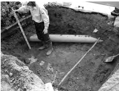
写真 67 ロータリー北通路屋根取設その他工事 16区完掘状況（北西より）
