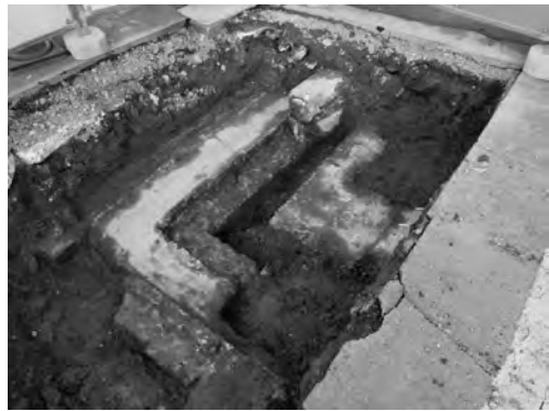
写真 60 ロータリー北通路屋根取設その他工事 1区石組排水路床面およびコンクリート 基礎露出状況(南西より)
