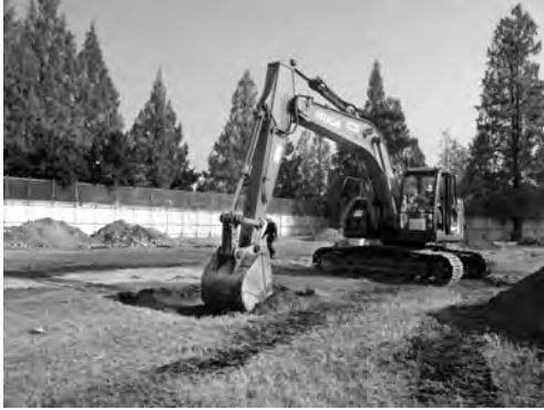
写真 89 知の人材育成センター新営工事 5 区 掘削状況（南西より）
