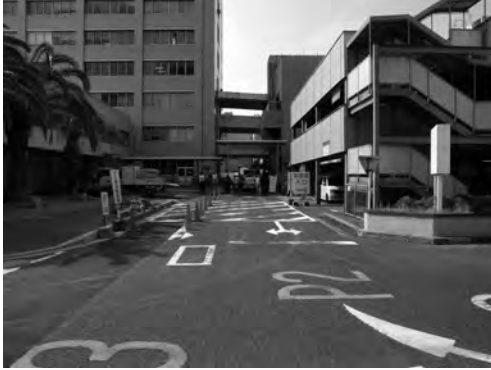
写真 32 医療支援センター等改修工事調査区 全景（北より）
