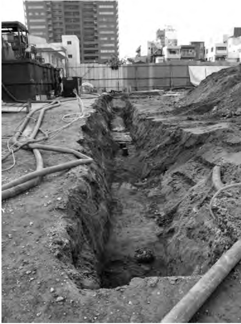
写真 94 知的人材育成センター新営工事 11 区 コンクリート構築物および木杭検出状 況（東より）
