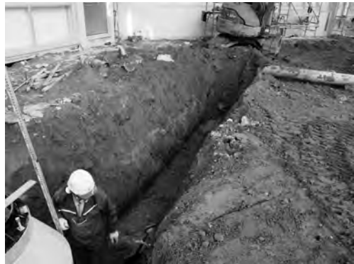
写真 51 医療支援センター・総合研究棟ほか外構 工事 7-4区完掘状況(南西より)
