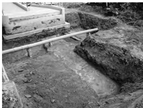
写真4 霞会館北側渡り廊下設置工事1区コンクリート床・基礎検出状況（北西より）
