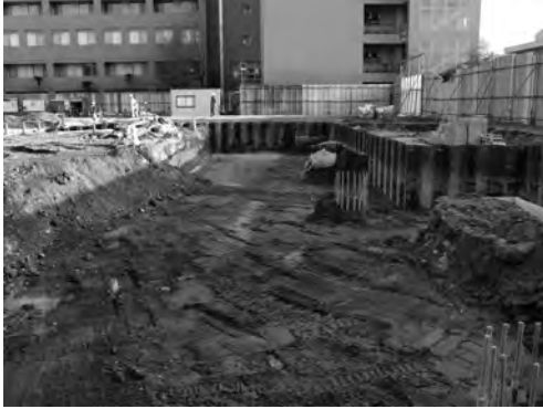
写真 98 知的人材育成センター新営工事 14 区 完掘状況（北より）
