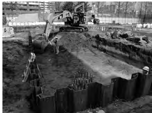
写真 97 知的人材育成センター新営工事 14 区 掘削状況（南より）
