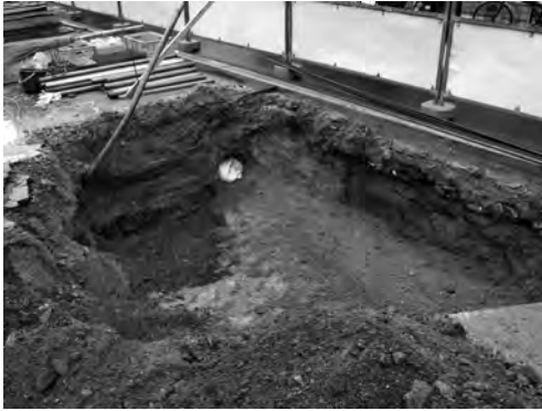
写真 69 ロータリー北通路屋根取設その他工事 21区完掘状況（南西より）
