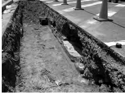
写真 33 医療支援センター等改修工事北側南 北区北半部煉瓦建物基礎遺構検出状 況（北より）
