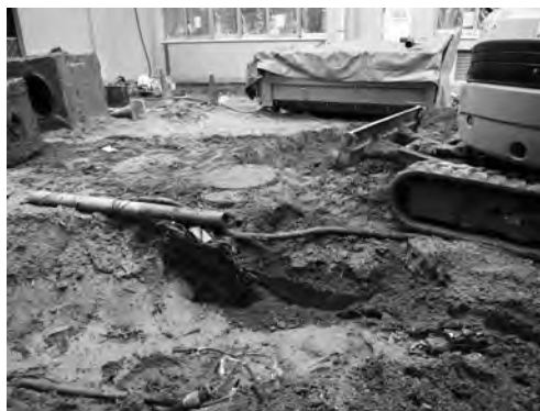
写真 56 医療支援センター・総合研究棟ほか外構工事 8区完掘状況（南より）
