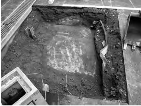
写真 28 震地区北西部渡り廊下設置工事Ⅱ区 西区コンクリート床検出状況（南より）
