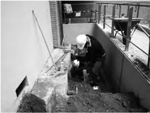
写真 8 霞会館北側渡り廊下設置工事 3 区掘削状況（西より）
