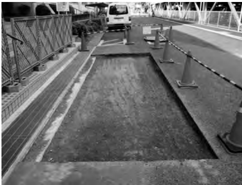
写真 30 震地区北西部渡り廊下設置工事Ⅲ区 コンクリート面検出状況（東より）
