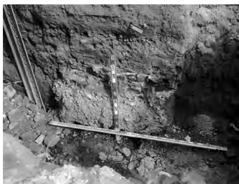
写真 55 医療支援センター・総合研究棟ほか外構工事 7-6区煉瓦・コンクリート基礎断面（西より）
