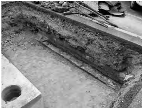
写真 24 震地区北西部渡り廊下設置工事Ⅱ区 東区コンクリート基礎検出状況（北東 より）
