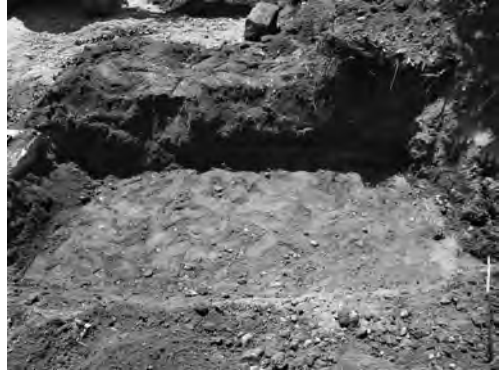
写真 11 霞会館北側渡り廊下設置工事 8 区完掘状況（北より）
