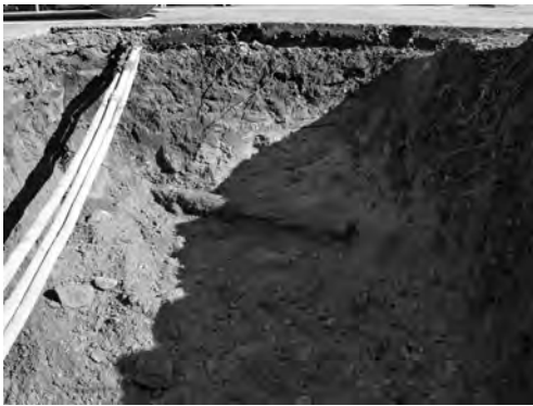
写真 65 ロータリー北通路屋根取設その他工事 5区鉄管検出状況（西より）
