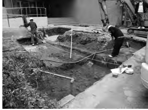
写真 9 霞会館北側渡り廊下設置工事 5 区共同溝露出状況（南西より）
