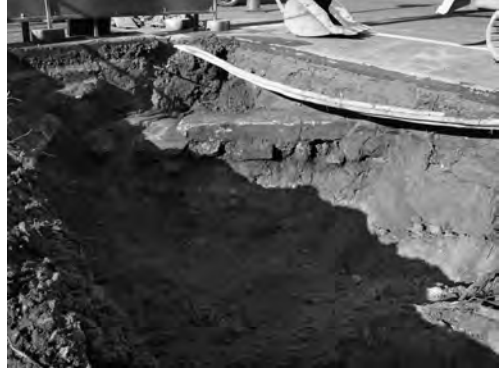
写真 64 ロータリー北通路屋根取設その他工事 5区コンクリート基礎（南東より）
