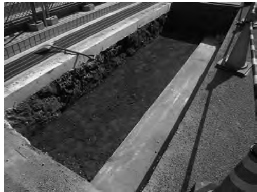
写真 31 震地区北西部渡り廊下設置工事Ⅲ区 完掘状況（北東より）
