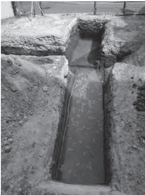
写真 41 ファミリーハウス新営工事 1 トレンチ完掘状況（北西より）
