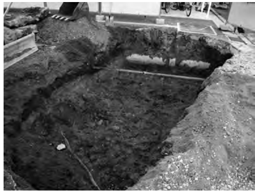
写真 66 ロータリー北通路屋根取設その他工事 8区掘完掘状況（南西より）
