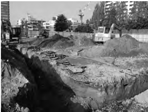
写真 92 知の人材育成センター新営工事 9 区 掘削状況（南東より）
