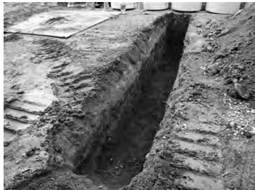
写真 53 医療支援センター・総合研究棟ほか外構 工事 7-3区完掘状況(東より)
