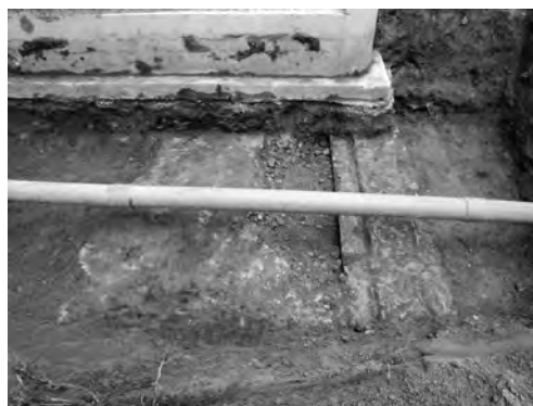
写真5 霞会館北側渡り廊下設置工事1区東部コンクリート床・基礎検出状況（西より）
