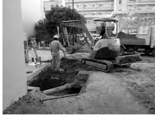
写真 13 霞会館北側渡り廊下設置工事 10 区掘削状況（南より）
