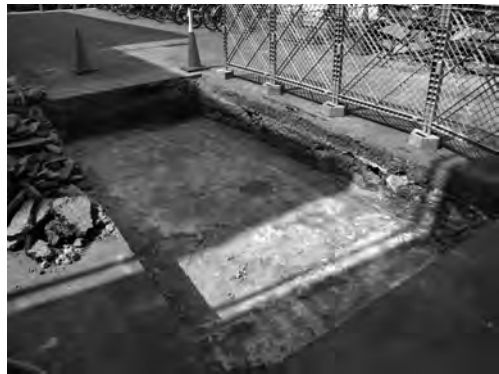
写真 25 震地区北西部渡り廊下設置工事Ⅱ区 中央区コンクリート床・コンクリート基礎 検出状況（南西より）
