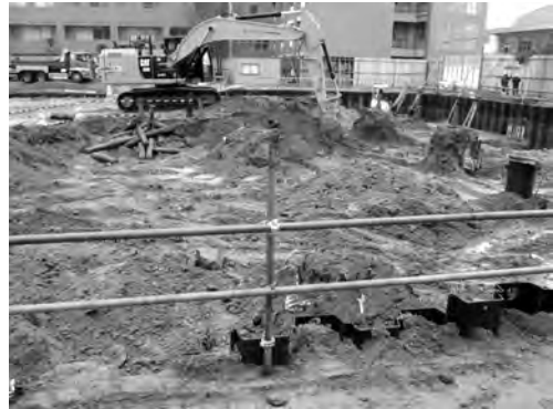
写真 101 知的人材育成センター新営工事 15 区掘削状況（北より）
