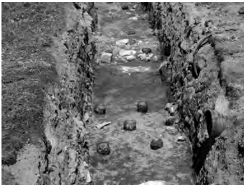
写真 83 知的人材育成センター新営工事 1 区 杭列近景 (写真中央が第 3 杭列) (南 より)
