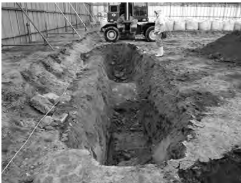
写真 96 知的人材育成センター新営工事 12 区 コンクリート基礎検出状況（南より）
