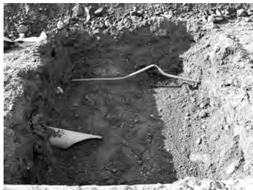
写真 68 ロータリー北通路屋根取設その他工事 18区完掘状況（東より）
