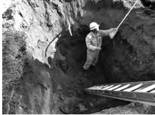
写真 90 知の人材育成センター新営工事 8 区 木杭検出状況（西より）
