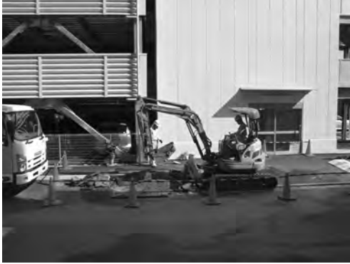
写真 16 震地区北西部渡り廊下設置工事Ⅰ区 掘削状況（南より）
