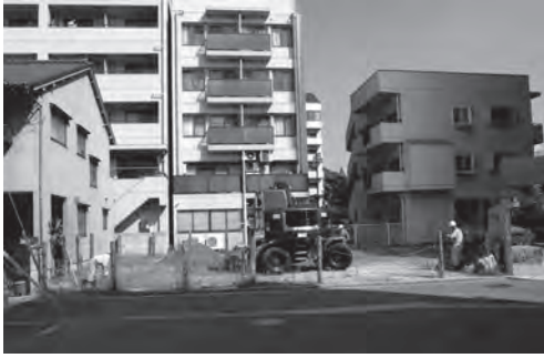
写真 40 ファミリーハウス新営工事調査区近景（南東より）
