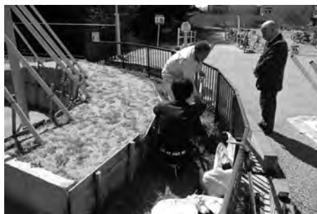
写真1 鴻の巣南遺跡説明板設置工事 説明板支柱基礎掘り方掘削状況
