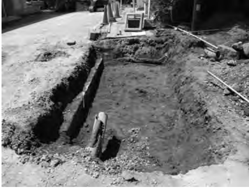
写真 12 霞会館北側渡り廊下設置工事 9 区完掘状況（東より）
