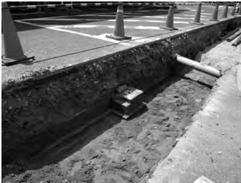
写真 34 医療支援センター等改修工事北側南 北区中央部煉瓦建物基礎遺構検出 状況（南東より）
