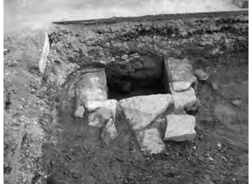
写真 17 震地区北西部渡り廊下設置工事Ⅰ区 石組柵（北より）
