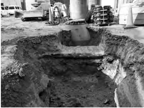
写真 48 医療支援センター・総合研究棟ほか外構 工事 7-1区コンクリート層検出状況(東より)
