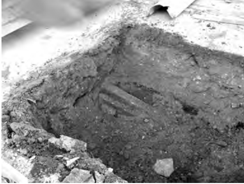
写真 63 ロータリー北通路屋根取設その他工事 4区切石確認状況（南東より）。
