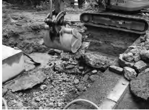
写真 23 震地区北西部渡り廊下設置工事Ⅱ区 東区コンクリート床ほか撤去状況（北 西より）
