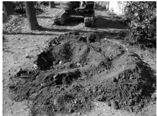
写真 80 ロータリー北通路屋根取設その他工事 14区完掘状況 (東より)
