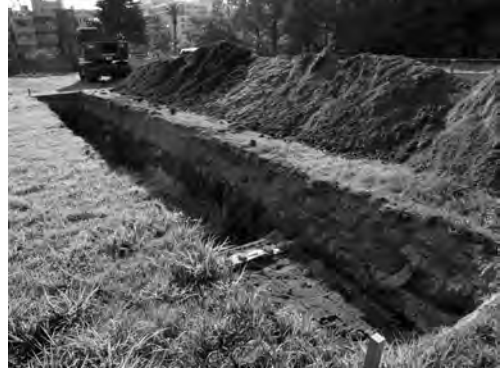
写真 88 知的人材育成センター新営工事 2 区 完掘状況（南東より）
