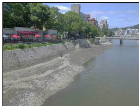
写真-4.3.2 大規模試験区構築 8) (施工後 2013年5月)
