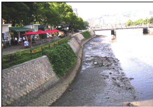
写真-4.3.1 対象干潟の外観 8) (施工前 2009年12月)
