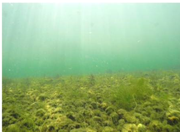
写真-2.1.1 海域への石炭灰造粒物の敷設状況
