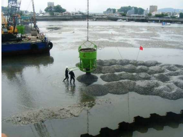
写真-4.1.1 コンクリートバケットを用いた覆砂材の投入状況 2) 出典) 石炭灰造粒物を用いた河口域干潟および浅海域の底質環境改善手法の評価 (図-5.5.3, 藤原哲宏, 3/2014) 2) 掲載図を転載
