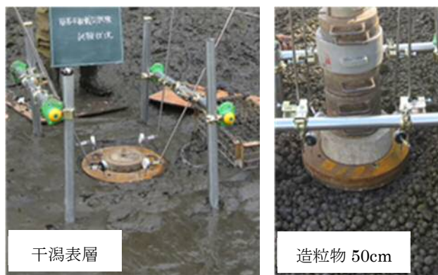
写真-4.3.4 石炭灰造粒物層の平板載荷試験状況 8)
