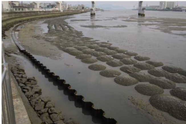
写真-4.1.2 覆砂材（石炭灰造粒物）の小山状投入完了時の状況 3) 出典) 地下水が遮断された河口干潟でのアサリ育成場の構築, (写真-3, 藤原哲宏 ら, 土木学会論文集 B3 (海洋開発), Vo1.69, No.2, 6/2013) 3) 掲載図を転載
