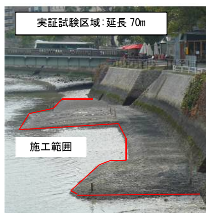
写真-4.2.4 実証試験区の構築 7)
