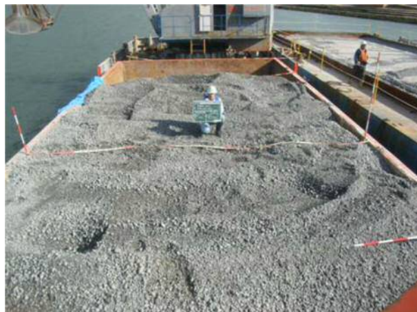
写真-4.1.3 石炭灰造粒物の海上運搬状況
