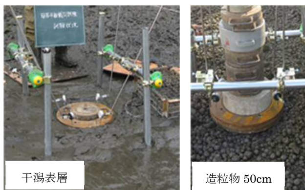
写真-7.4.3 石炭灰造粒物層の平板載荷試験状況
