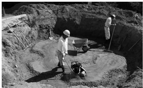
写真 207 復元住居跡柱基礎基盤の成形
