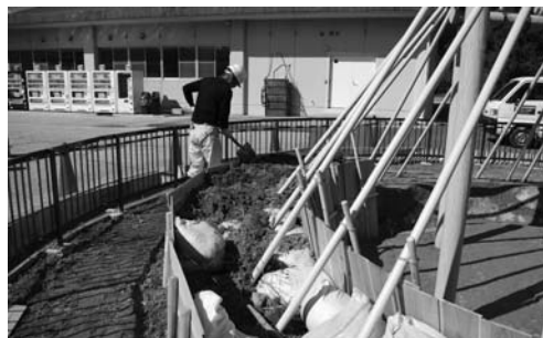
写真 266 周堤の構築（土入れ）
