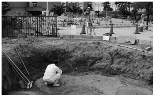
写真 208 復元住居跡柱中心の位置出し
