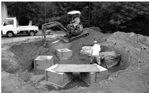
写真 213 復元住居跡柱基礎掘り方の埋め戻し
