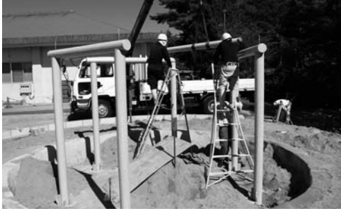
写真 224 梁・桁の設置
