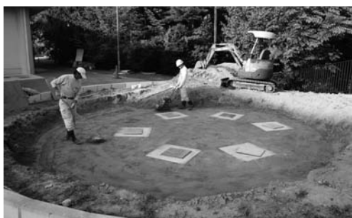
写真 214 復元住居跡柱基礎上面の成形
