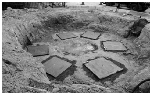
写真 209 復元住居跡柱基礎基盤の構築（コンクリート打ち）
