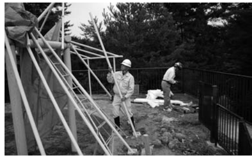
写真 257 入口付近の下部垂木の追加設置
