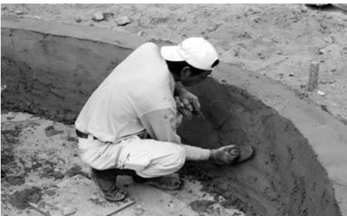
写真 219 復元住居跡壁面の整形
