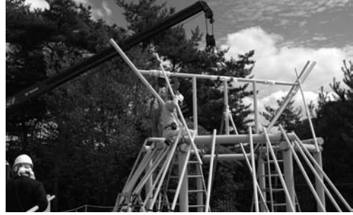
写真 253 上部垂木の設置
