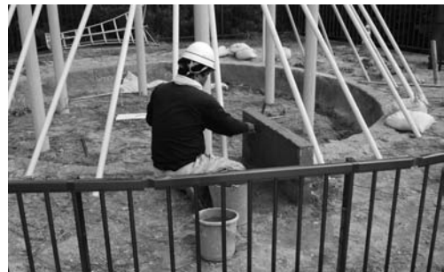
写真 265 周堤の設置（土留め壁の設置）
