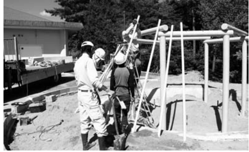
写真 225 垂木の設置と固定
