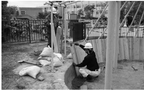
写真 262 矢板（板壁）の設置
