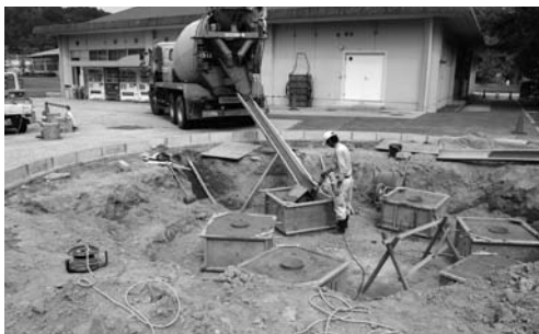
写真 211 復元住居跡柱基礎コンクリート流し込み
