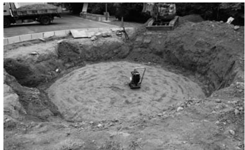
写真 205 復元住居跡掘り方底面の成形
