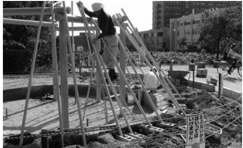
写真 227 垂木基礎の追加工事
