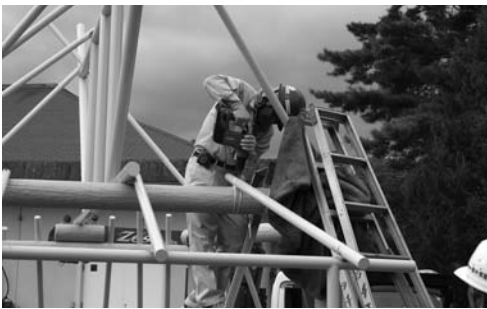
写真 256 垂木ほかのネジ留め
