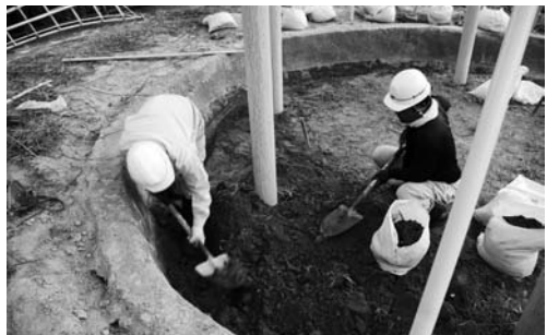
写真 259 周溝の構築準備（掘削）
