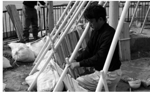
写真 263 矢板の固定用支柱設置
