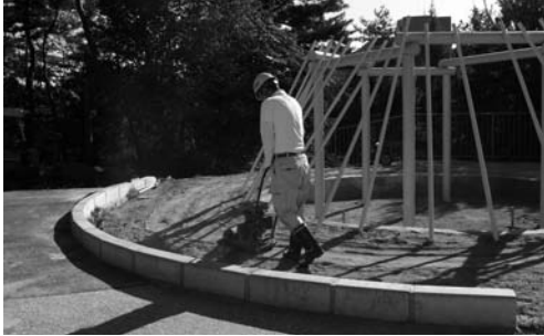
写真 228 復元住居跡周辺の整形と填圧
