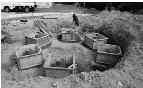
写真 210 復元住居跡柱基礎型枠の設置
