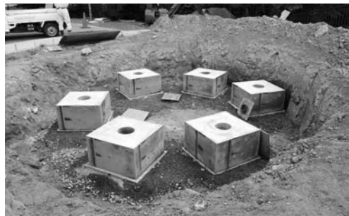
写真 212 復元住居跡柱基礎完成と乾燥
