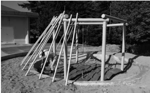
写真 226 復元住居跡床面の仮成形
