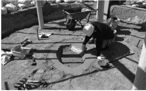
写真 260 硬化土による住居内炉の構築
