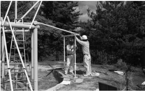
写真 254 入口部の設置
