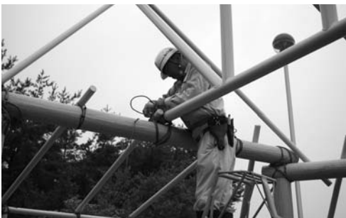
写真 258 蔓による骨組材緊縛状況の復元
