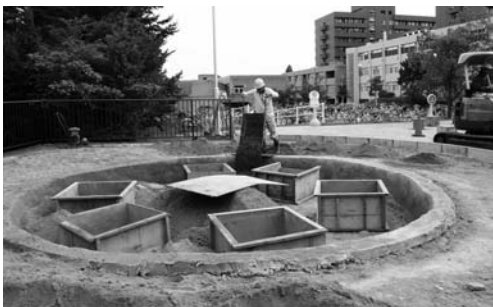
写真 221 復元住居跡床面成形のための土搬入
