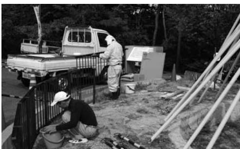
写真 273 保護柵の設置
