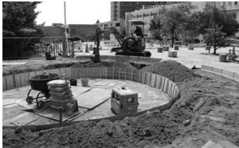
写真 217 復元住居跡壁型枠外側の埋め戻し
