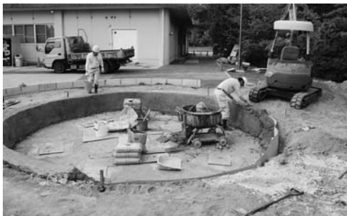
写真 218 復元住居跡壁面の構築
