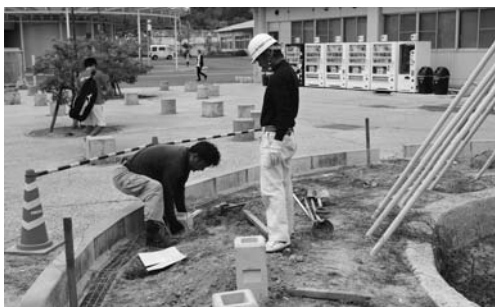
写真 272 保護柵基礎の設置
