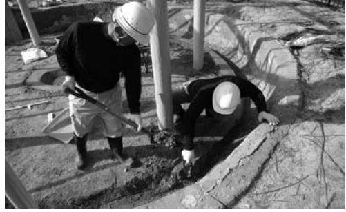
写真 261 硬化土による周溝の構築
