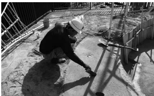
写真 270 垂木穴の復元(検出状態の表示)
