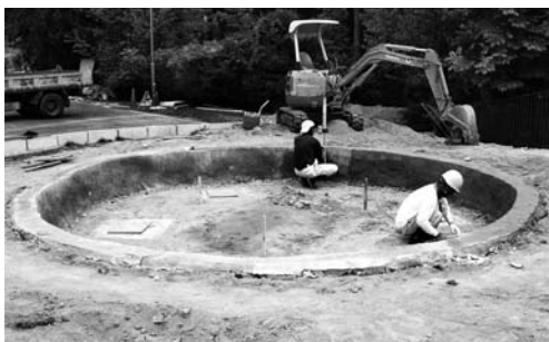
写真 220 復元住居跡壁面の形状確認作業
