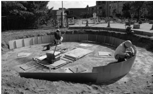
写真 216 復元住居跡壁面構築のための型枠設置
