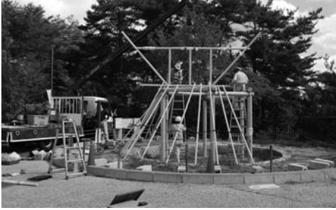
写真 252 棟および小屋束・桁の設置
