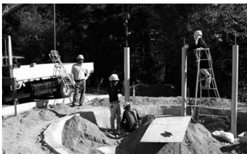
写真 222 復元住居跡支柱の設置 (1)
