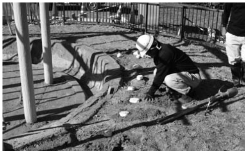
写真 269 垂木穴の復元準備(垂木穴雄型設置)
