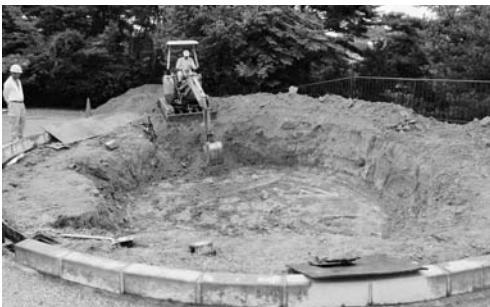
写真 204 復元住居跡掘り方の構築
