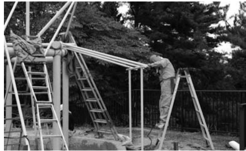
写真 255 垂木ほかの骨組材相互の溶接
