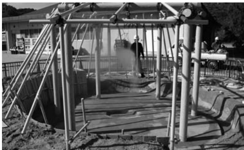
写真 268 床面への散水
