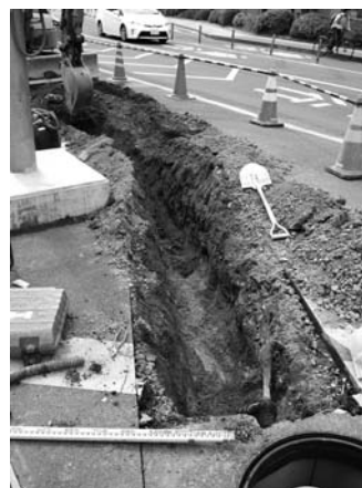
写真 98 中央分離帯配管工事地区 / 左：A地区電気配管掘り方掘削状況（西より）、中央：B地区電気配管掘り方掘削状況（東より）、右：D地区電気配管掘り方完掘状況（東より）
