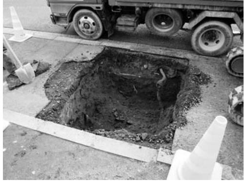
写真 167 ガス本管位置確認のための掘削状況 (南西より)
