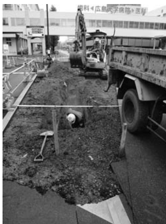
写真 98 中央分離帯配管工事地区 / 左：A地区電気配管掘り方掘削状況（西より）、中央：B地区電気配管掘り方掘削状況（東より）、右：D地区電気配管掘り方完掘状況（東より）
