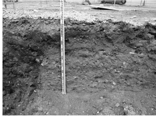
写真 95 駐輪場設置工事地区屋根支柱基礎掘り方中央列南壁
