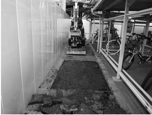
写真 177 消防設備掘り方全景（南より）
