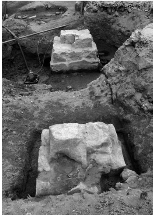
写真 115 SB 01 柱独立基礎 (手前: 基礎 2、奥: 基礎 1) (東より)
