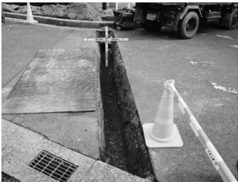
写真 168 道路横断部配管路掘り方完掘状況 (西より)
