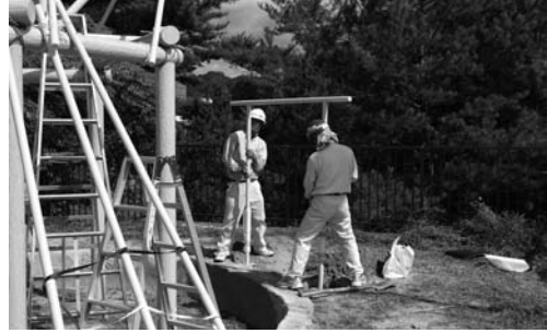
写真 81 入口部の骨組の設置
