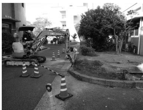
写真153 集水樹掘り方掘削状況（東より）
