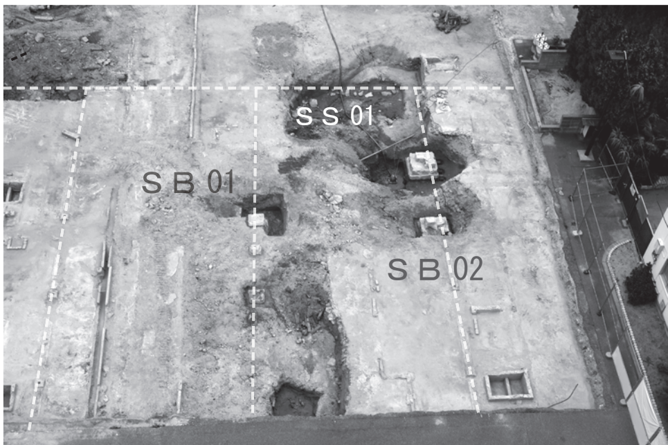
写真 110 調査区東部の遺構（大型礎石建物SB 01・建物遺構SB 02・石組遺構SS 01ほか） （東より）
