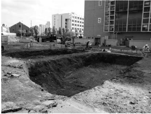
写真 94 駐輪場設置工事地区屋根支柱基礎掘り方中央列・南列掘削状況（南西より）
