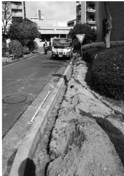
写真 170 道路縁石沿い配管路掘り方掘削状況 (南より)
