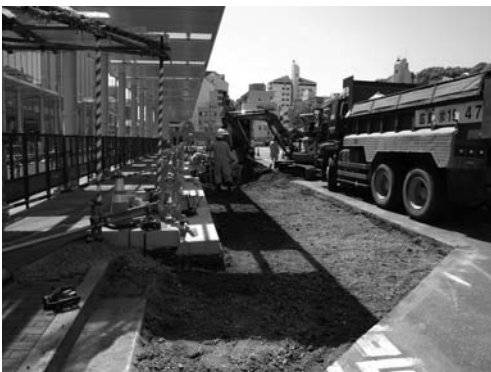
写真 92 バス停土壌改良工事地区調査区全景（東より）
