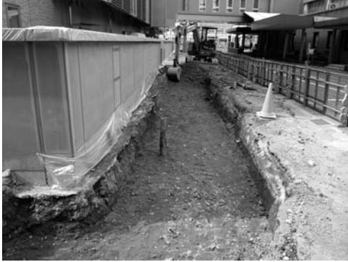
写真 88 キャンピー設置工事地区南部キャンピー基礎掘り方完掘状況（南より）
