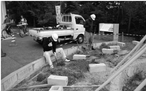
写真 82 保存区保護柵支柱基礎掘り方の掘削
