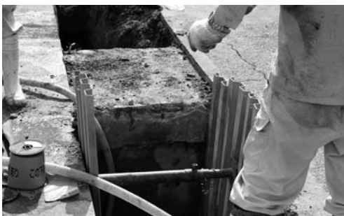
写真 185 南地区コンクリート構築物1検出状況（東より）
