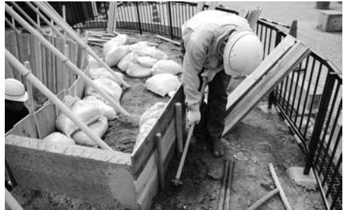
写真 85 周堤外側の土留め設置
