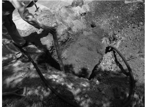
写真 100 中央分離帯配管工事地区C・D地区境界外灯基礎掘り方完掘状況（西より）
