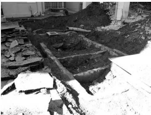
写真 158 西地区浄化槽検出状況（南東より）
