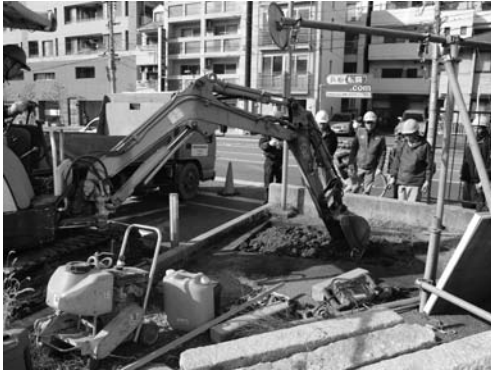
写真 171 満空灯基礎掘り方掘削状況(北東より)
