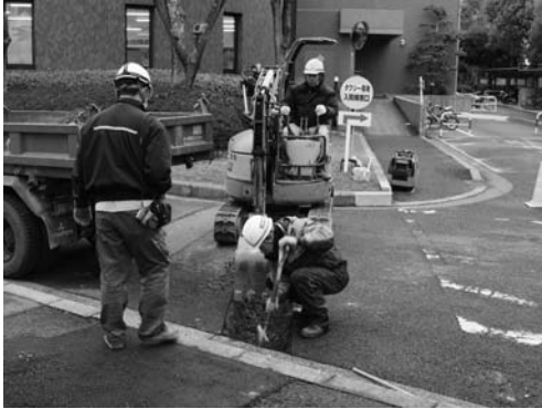
写真 166 道路横断部配管路掘り方掘削状況 (西より)
