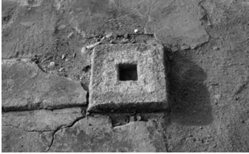
写真 111 SB 01 柱礎石 (基礎 10) (南より)
