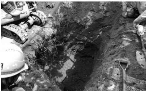
写真 183 南地区ガス配管確認のための掘削状況（北より）
