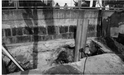
写真 180 北地区敷地外側掘り方掘削状況（西より）
