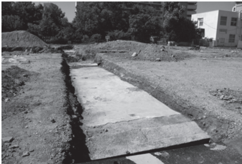
写真 107 中央部南北トレンチ (南より)
