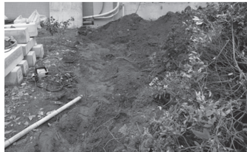
写真 174 低木撤去完了状況 (東より)
