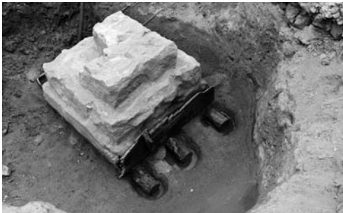
写真 114 SB 01 柱独立基礎 (基礎 1) (南東より)
