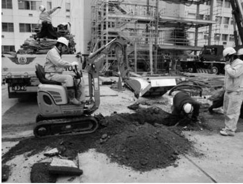
写真 162 立体駐車場接続部掘削状況（北より）
