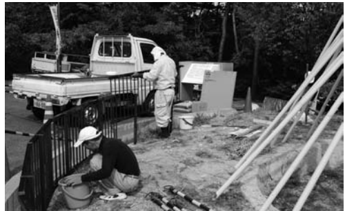
写真 83 保存区保護柵の設置
