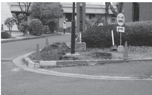
写真 175 看板移設場所全景 (南より)
