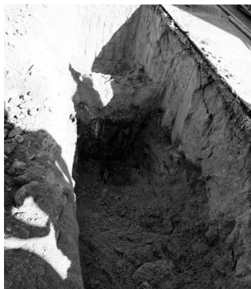
写真 159 東地区東半部東側コンクリート構築物（壁）検出状況（西より）
