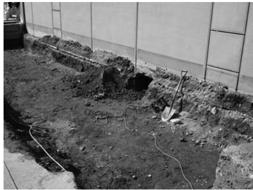
写真 91 外気ファン設置工事地区配管掘り方掘削状況（北東より）
