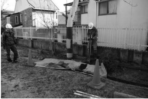
写真 189 アース掘り方掘削状況（西より）
