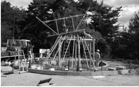
写真 80 屋根上部骨組の設置
