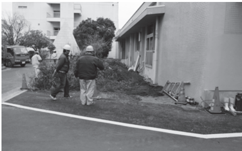
写真 173 低木撤去場所全景 (東より)
