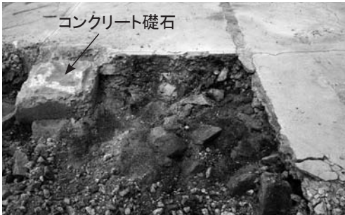
写真 128 SB 05 コンクリート床面下 (F 4区) の栗石地業 (西より)
