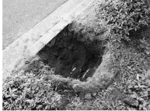
写真 155 カーブミラー基礎掘り方完掘状況 (南 西より)
