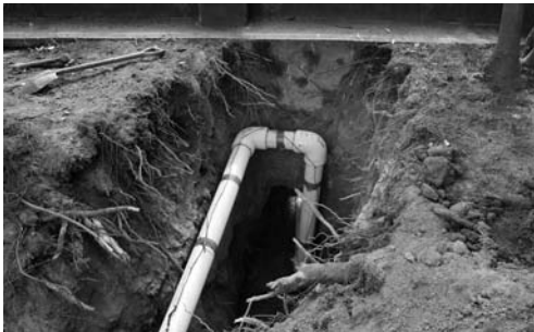
写真 181 北地区外堀付近掘り方掘削状況（東より）
