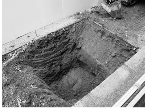
写真 178 消防設備掘り方完掘状況（南東より）
