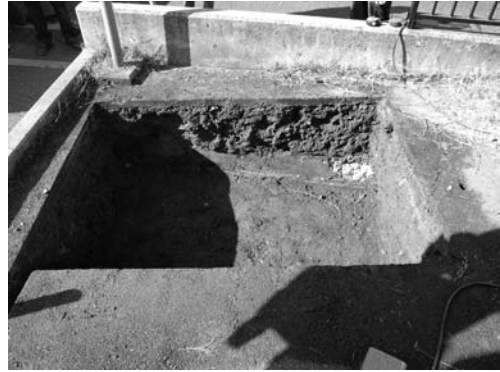
写真 172 満空灯基礎掘り方完掘状況(北東より)
