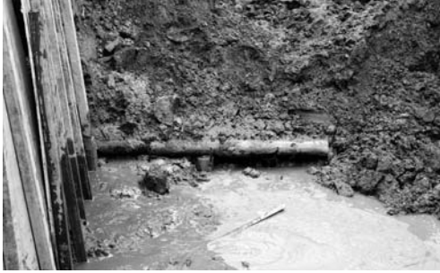
写真 118 SB 01 基礎杭 (I3・4区) (北より)
