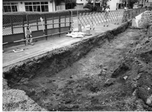
写真 106 擁壁設置工事地区擁壁掘り方南部掘削状況（南東より）
