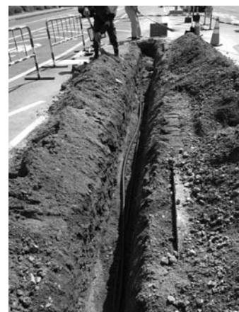
写真 98 中央分離帯配管工事地区 / 左：A地区電気配管掘り方掘削状況（西より）、中央：B地区電気配管掘り方掘削状況（東より）、右：D地区電気配管掘り方完掘状況（東より）
