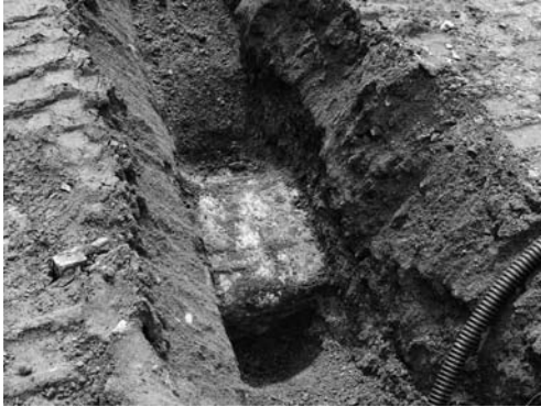
写真 99 中央分離帯配管工事地区C地区電気配管掘り方コンクリート遺構（東より）
