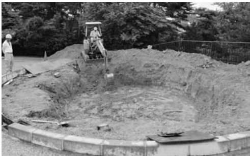
写真3 復元住居跡柱基礎設置のための掘り方構築
