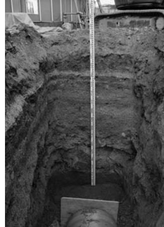
写真23 汚水管布設工事地区中央部堆積状況(西より)
