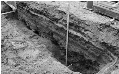
写真 28 汚水管布設工事地区東部堆積状況(南東より)
