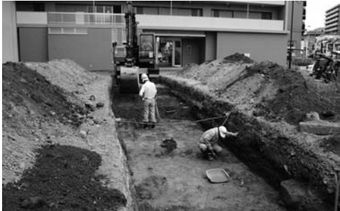
写真 32 エネルギーセンター増設工事ほか試掘調査区掘削状況（北より）
