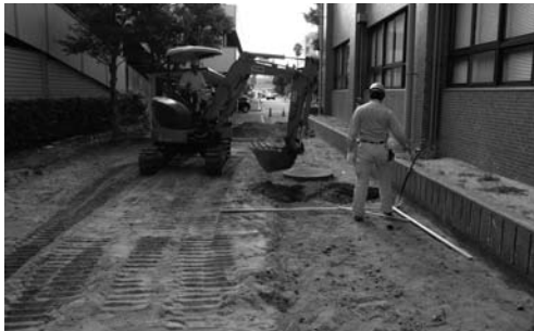
写真 60 自転車転倒防止柵基礎掘削状況（東より）
