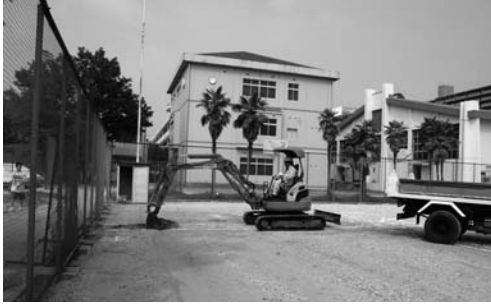
写真 64 1区掘削状況 (東より)
