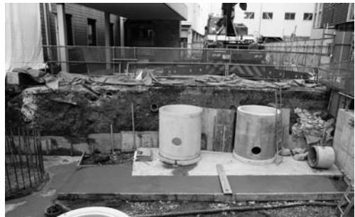
写真12 渡り廊下設置工事(既設外来棟地区)掘削状況(南より)
