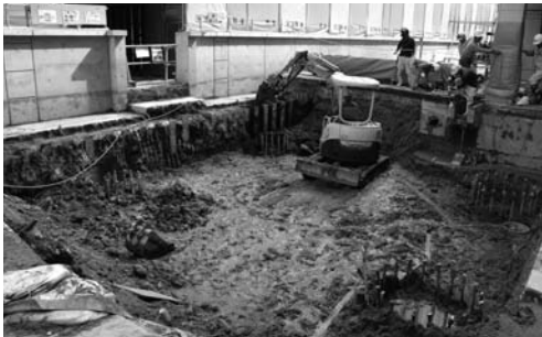
写真11 渡り廊下設置工事(入院棟地区)掘削状況(南西より)
