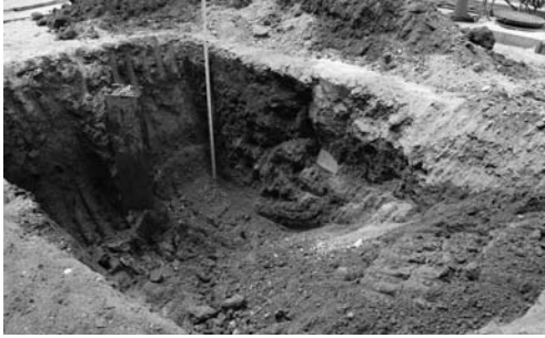
写真9 共同溝布設工事1区完掘状況(北西より)
