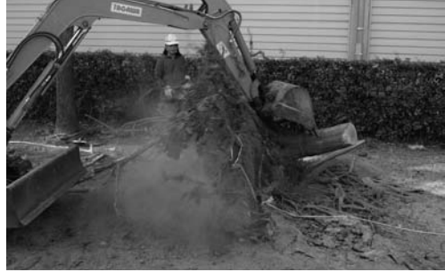
写真 59 高木撤去状況（北より）
