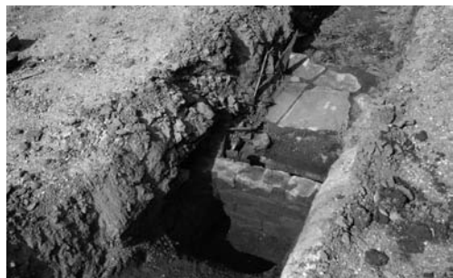
写真 69 3区西部No.4 遺構 (煉瓦積遺構) 構築状況 (東北東より)
