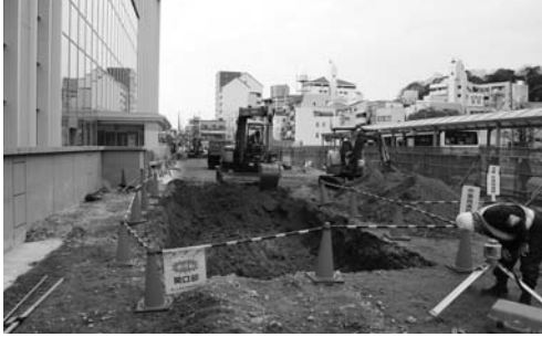
写真 13 キャンピー基礎掘り方掘削状況（東より）
