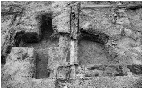
写真 17 キャンピー設置工事地区第1暗渠状遺構中央部木組状況（南より）
