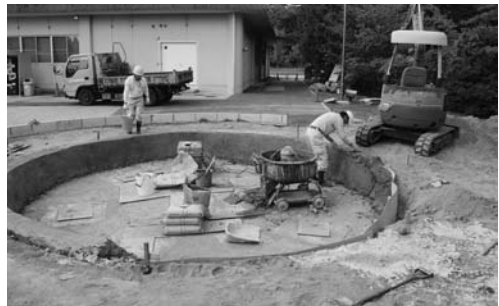
写真6 復元住居跡壁の構築
