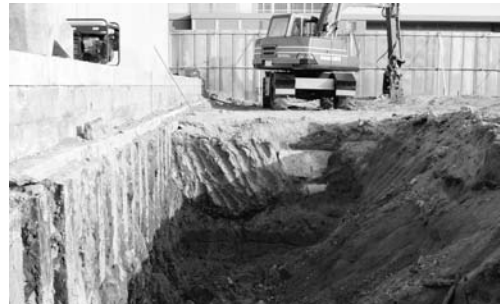
写真 47 エネルギーセンター増設工事ほか立会調査区コンクリート構築物検出状況 (北西より)
