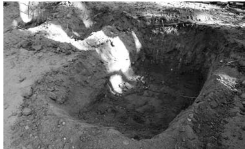
写真 63 駐輪場屋根支柱基礎掘り方(第13図2) 完掘状況（北西より）
