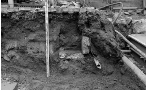
写真 24 キャンピー設置工事地区排水路断面(南より)
