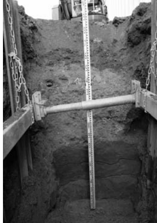
写真22 雨水排水管布設工事地区IV区東部堆積状況(東より)
