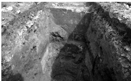
写真 56 エネルギーセンター増設工事に伴う電 気工事コンクリート構築物（西より）
