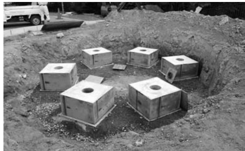
写真4 復元住居跡柱基礎の設置
