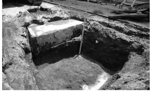
写真10 共同溝布設工事2区完掘状況(西より)
