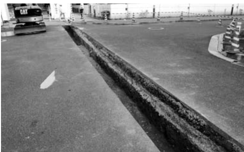
写真 50 エネルギーセンター増設工事ほか（ガス管 布設工事）配管掘り方完掘状況（西より）
