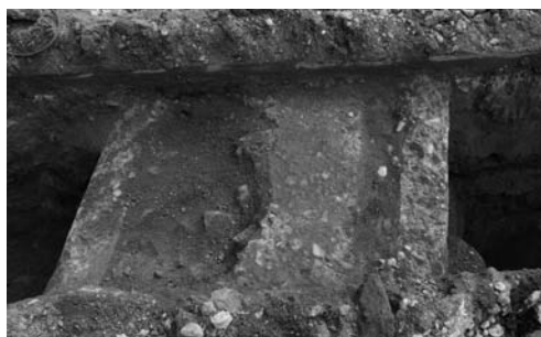
写真 55 エネルギーセンター増設工事に伴う電 気工事コンクリート構築物（北より）
