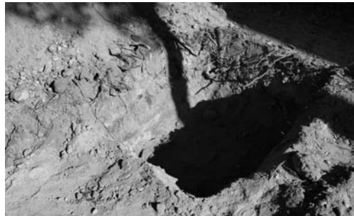
写真 61 駐輪場屋根支柱基礎掘り方(第13図6) 完掘状況（西より）
