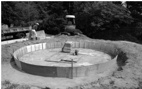
写真5 復元住居跡壁面型枠の設置
