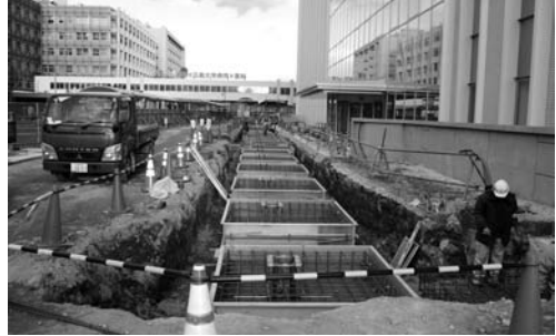
写真 25 キャンピー設置工事地区基礎設置状況(西より)
