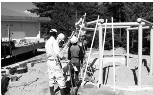
写真7 復元住居跡主柱・梁・桁・垂木の設置
