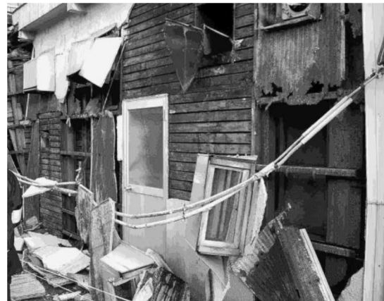
(b) 下地の腐食 (中越地震)
