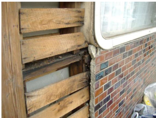
(c) サッシ取り合い部からの漏水による下地およびステープル・メタルラスの腐食 (中越沖地震)
