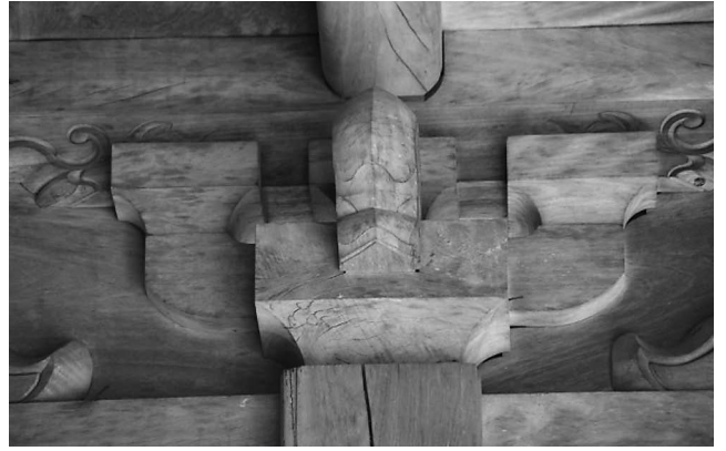
写真 20 玄関柱上組物
