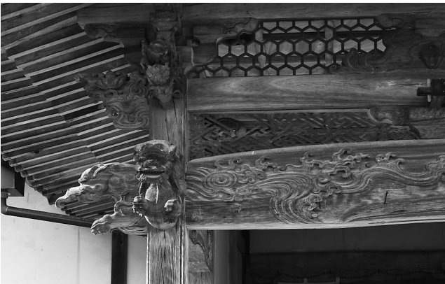
写真 18 玄関正面虹梁形
