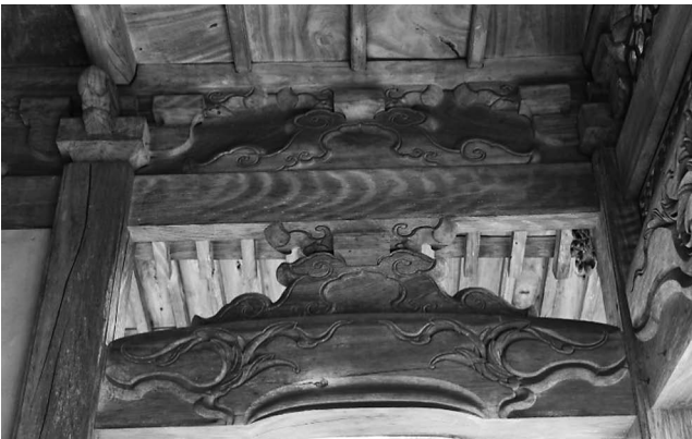
写真 19 玄関側面虹梁形
