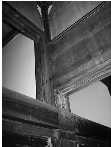
写真 22 内陣の長押の切り欠き痕
