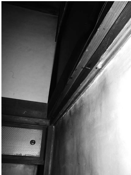
写真 24 一の間東側の土壁に残る鴨居
