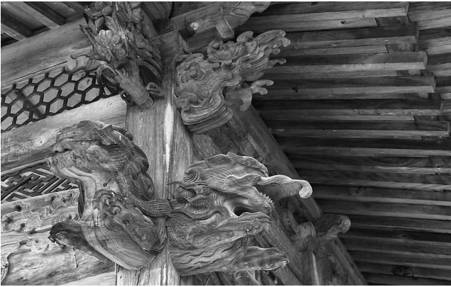
写真 17 玄関柱頭及び内法貫木鼻
