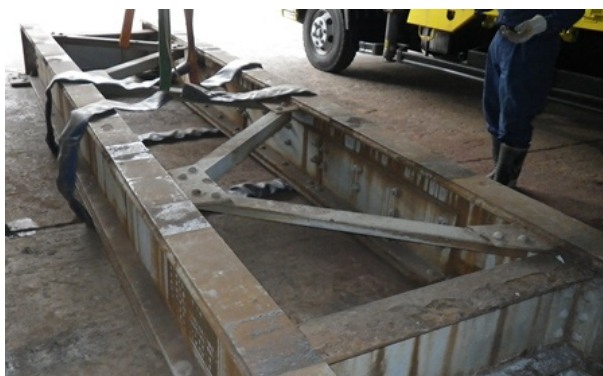
写真-6.1 対象橋梁
