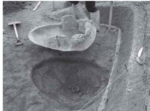
写真 165 復元石組炉の掘り方掘削と排水施設の設置
