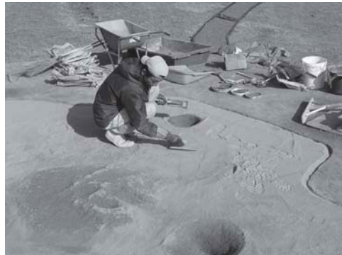
写真 171 硬化剤（ガンコマサ）を使用した住居床面の成形
