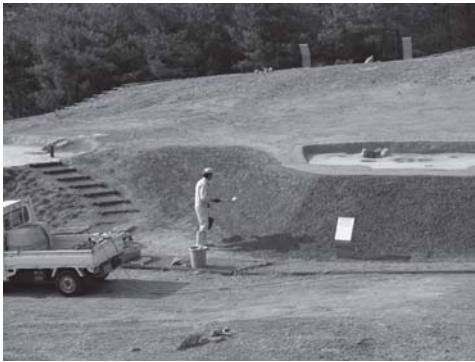
写真 174 住居跡法面補強用草種の散布
