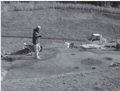
写真 172 硬化剤（ガンコマサ）硬化のための水撒き作業
