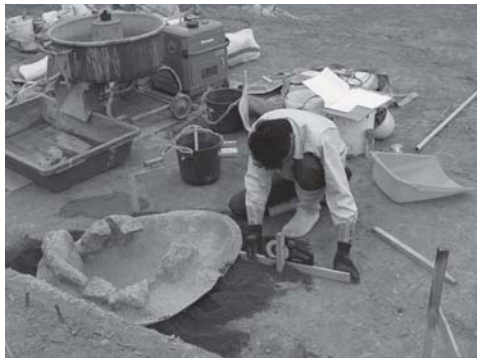
写真 166 復元石組炉の設置
