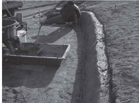
写真 163 硬化剤混合土（ガンコマサ）を使用した住居跡壁面構築
