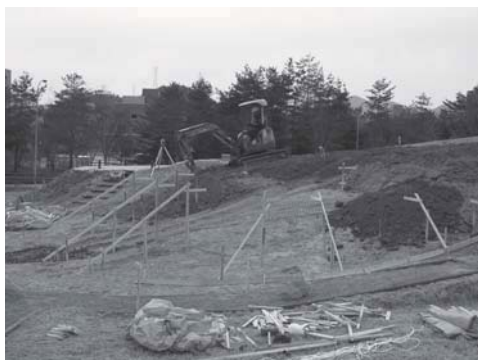
写真 160 住居跡（工房跡）土盛作業
