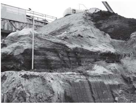
写真 126 3次掘削 37区 (G2区) 北壁上部(南西より)
