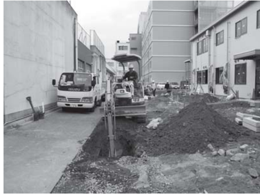
写真 45 北部排水管布設工事地区掘削状況（西より）
