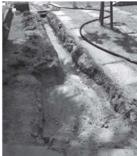
写真 83 D 地区 2 区、2 区西側電気配管掘り方コンクリート面検出状況（東より）
