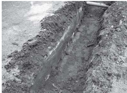
写真 46 No.1排水柵西側検出コンクリート構築物近景（西南より）
