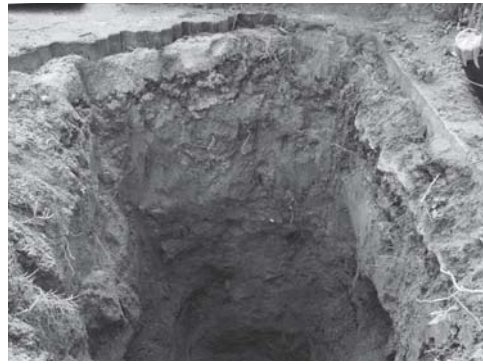
写真 140 附属学校部新設外灯基礎 2 区完掘 状況（東より）
