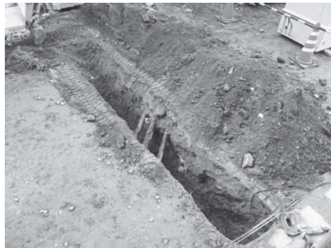
写真136 北ボイラー棟生活配水管ほか布設工事完掘状況(北より)
