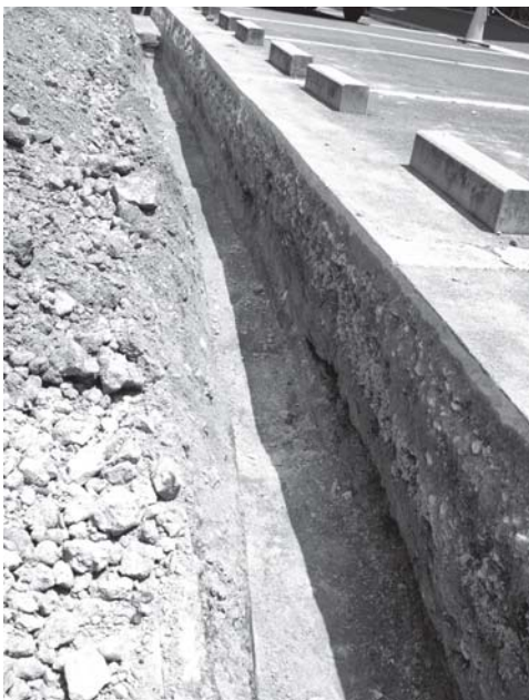
写真 66 A 地区 1・2 区間電気配管路掘り方 内土層堆積状況 (北西より)
