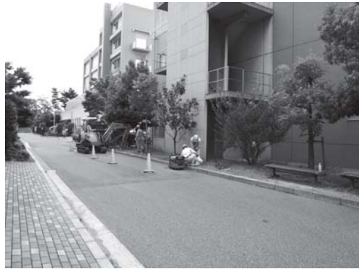
写真 71 外灯新設・改修工事(第I期)B地区 全景(西北より)
