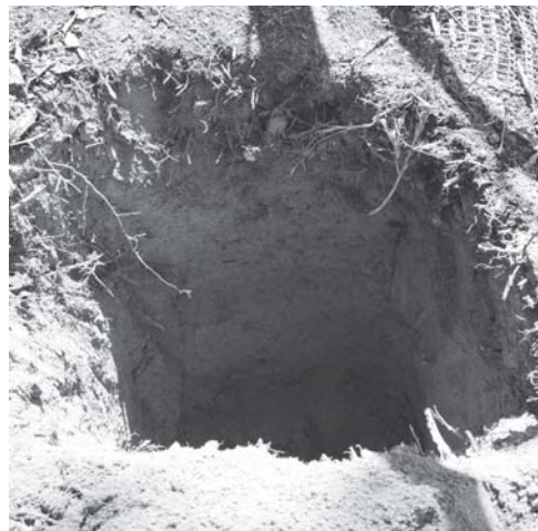
写真6 幼稚園防護柵設置工事4区完掘状況(西より)
