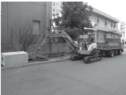
写真 93 外灯新設・改修工事（第Ⅱ期）F地区（医学部保健学科研究棟周辺）2区全景（北東より）
