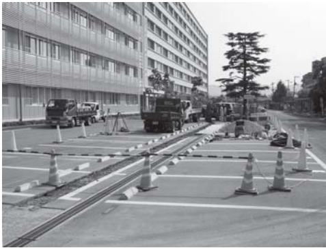
写真 80 外灯新設・改修工事（第 I 期）D 地区東半部（東北より）
