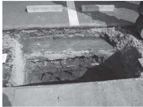
写真 81 D 地区 1 区完掘状況（南より）
