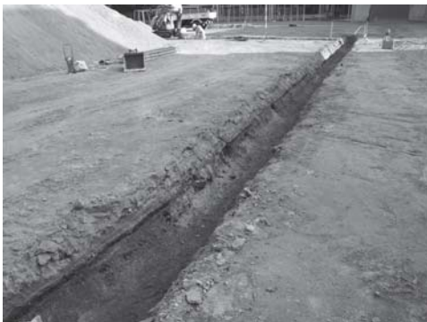
写真 143 地下排水管地区西側南北掘り方完 掘状況（北より）
