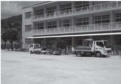
写真 148 小学校校舎南側給水管掘り方掘削状況（南東より）
