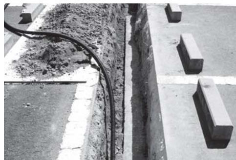
写真 70 A 地区 2・3 区間電気配管掘り方石 製構造物 (西より)
