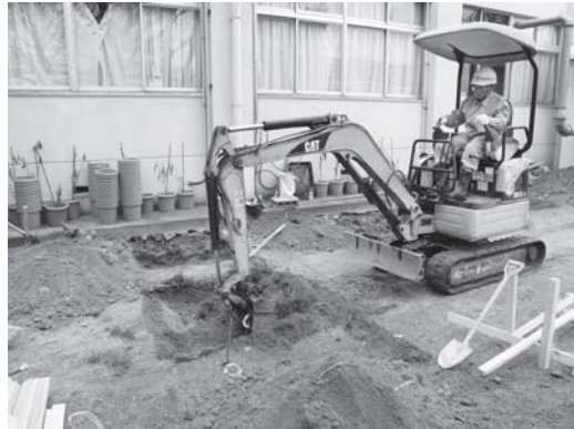
写真 145 中学校駐輪場取設工事支柱基礎掘削状況(南東より)
