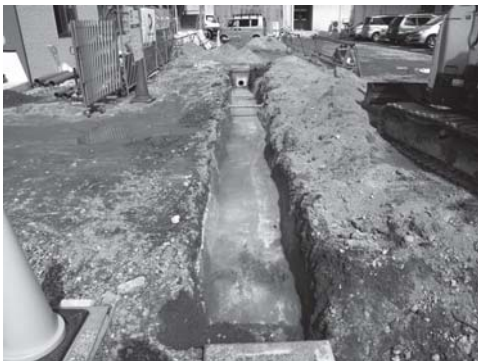
写真 48 東部南半排水管布設工事地区南北配管路調査区全景（南より）
