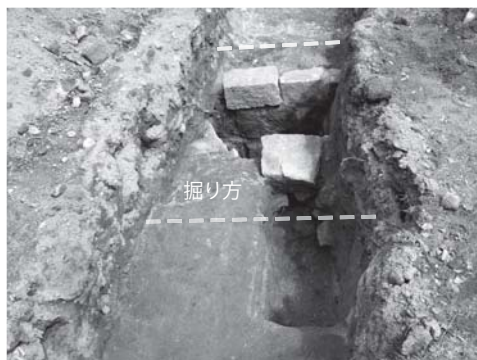
写真 22 給排水管布設地区 3 区石組溝裏込め構築状況（南より）
