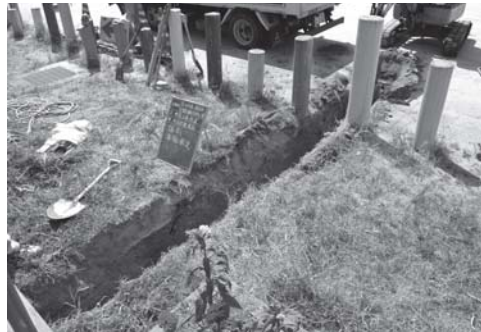
写真 149 小学校校舎南側給水管掘り方掘削状況（北西より）
