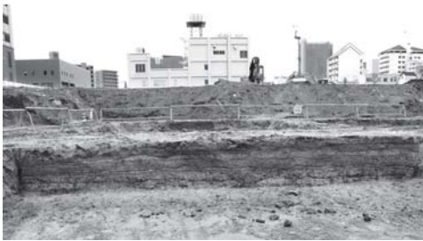
写真 110 2次掘削 26区南部(C7区)西壁
