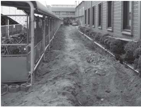
写真53 大学病院外来診療北側通路設置工事 A・B工区全景（西より）
