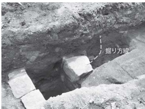
写真 21 給排水管布設地区 3 区石組溝掘り方構築状況（西北より）
