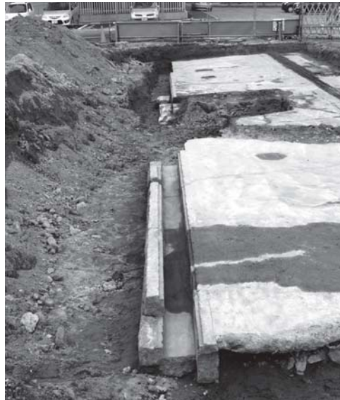
写真34 石組排水路全景（西より）
