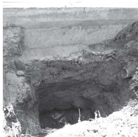
写真 138 防球ネット支柱基礎掘り方7区完掘状況(北より)
