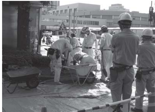
写真27 ソーラー時計基礎掘削状況（西より）
