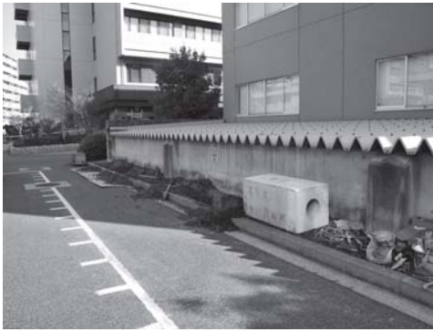
写真 95 外灯新設・改修工事（第Ⅱ期）F地区（医学部保健学科研究棟周辺）3区全景（南より）
