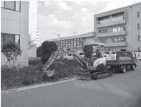
写真 91 外灯新設・改修工事（第Ⅱ期）F地区（医学部保健学科研究棟周辺）1区全景（南西より）
