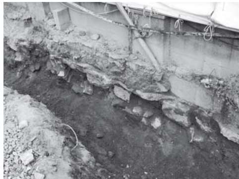
写真 26 電気配管布設地区配管掘り方西半部完掘状況（北西より）
