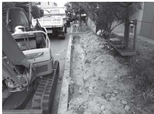
写真 73 B地区電気配管路掘り方完掘状況(西 より)
