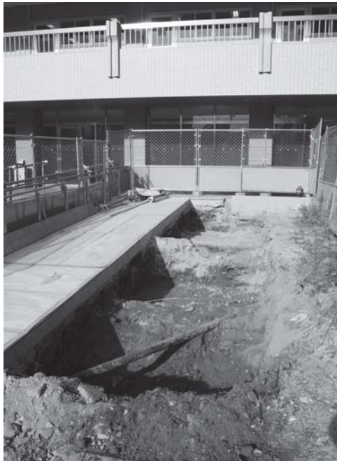
写真60 C工区(29~32区)完掘状況(西南より)
