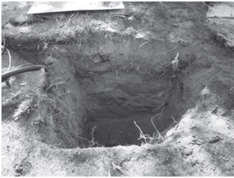
写真 139 附属学校部新設外灯基礎 1 区完掘 状況（東より）
