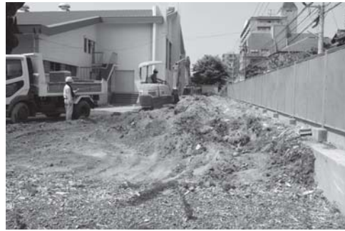
写真 137 テニスコート外部スタンド西側進入路付近掘削状況(東より)
