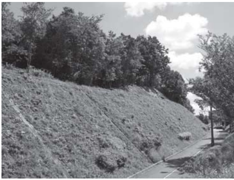
写真3 幼稚園防護柵設置工事調査区全景(南西より)
