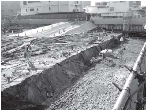
写真 108 2次掘削 14～18区(H1～H18区)南壁(矢板補強H鋼設置工事掘り方)(北東より)
