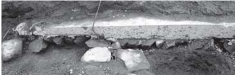
写真38 調査区東端部コンクリート床断面と基礎割栗石配置状況（西より）
