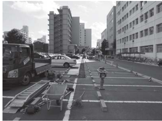
写真61 外灯新設・改修工事（第Ⅰ期）A地区 全景（西より）
