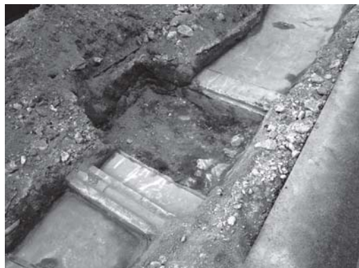
写真44 コンクリート構築物（北東より）
