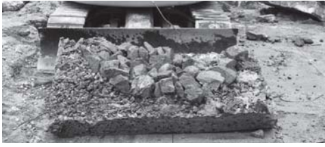
写真37 コンクリート床基礎割栗石接合状況
