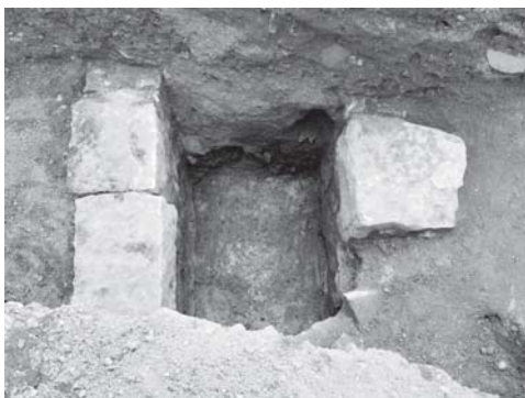
写真 19 給排水管布設地区 3 区石組溝検出状況（西より）
