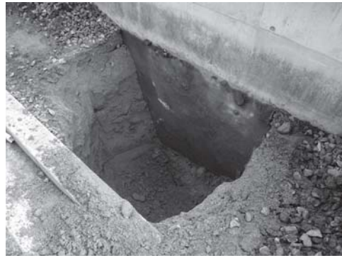
写真 96 F地区3区完掘状況（南西より）
