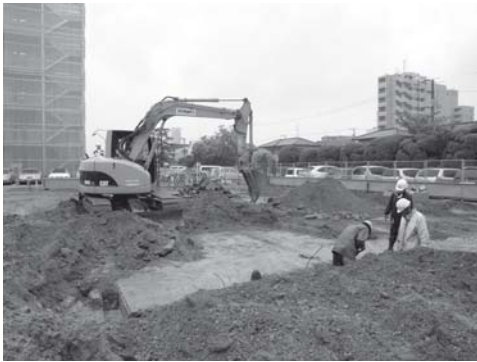
写真31 大学病院管理棟基礎工事地区調査状況（北西より）
