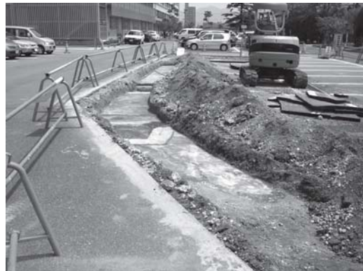
写真43 南部排水管布設工事地区中央部および東部（西より）
