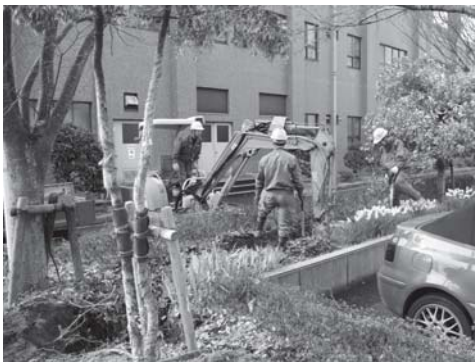
写真 97 外灯新設・改修工事（第Ⅱ期）G地区（図書館北側）全景（南西より）
