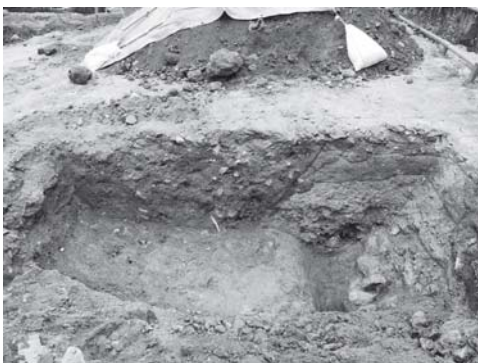
写真 17 給排水管布設地区 1 区完掘状況（西より）
