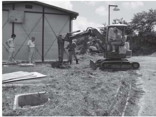
写真1 農場地区調査区全景と掘削状況
