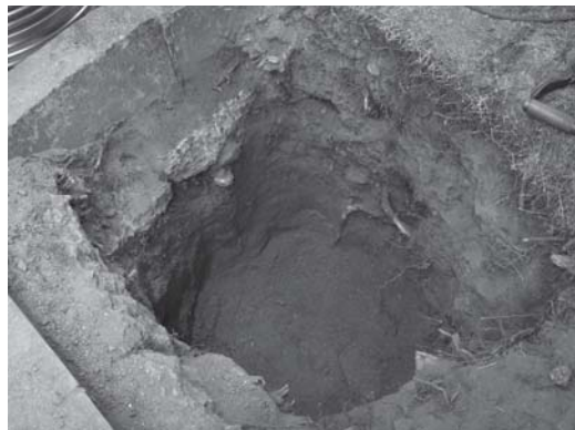
写真28 ソーラー時計基礎掘り方完掘状況（東南より）
