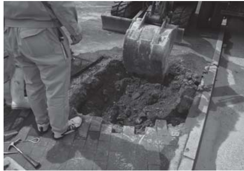
写真 29 正門交差点信号機基礎掘り方掘削状況（北より）
