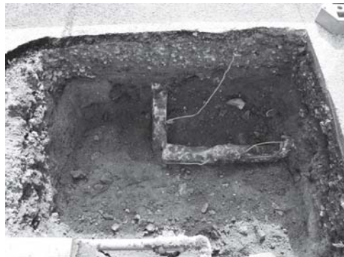
写真58 B工区34区コンクリート構築物検出状況（西より）
