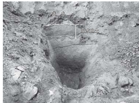
写真 104 1次掘削8区（B4区）北壁
