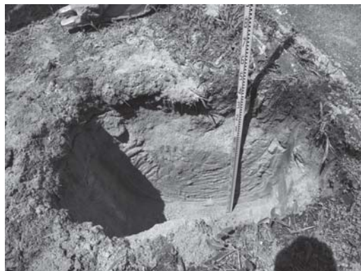
写真2 外灯掘り方完掘状況
