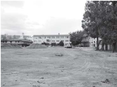
写真 141 附属学校部小学校運動場改修工事 全景（東より）
