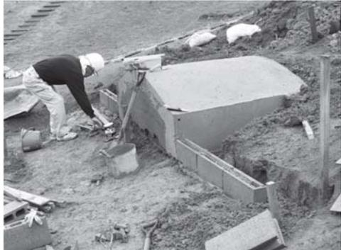
写真 67 窯跡焚口部周囲基礎成形
