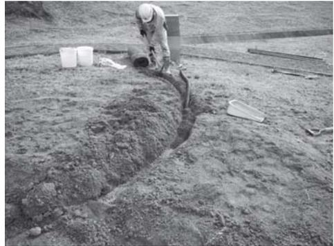
写真 73 窯跡前庭部排水施設の設置
