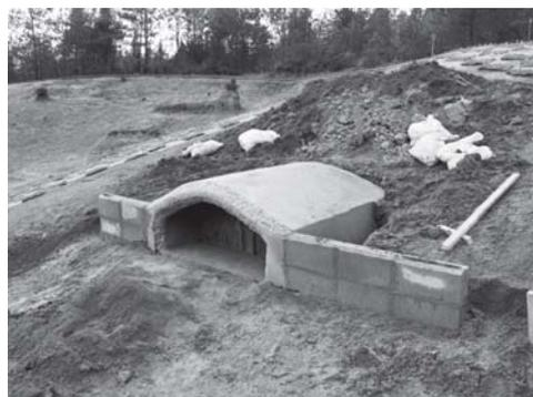
写真 69 窯跡焚口部基礎の完成状況
