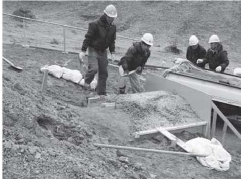
写真 66 窯跡焚口部天井成形
