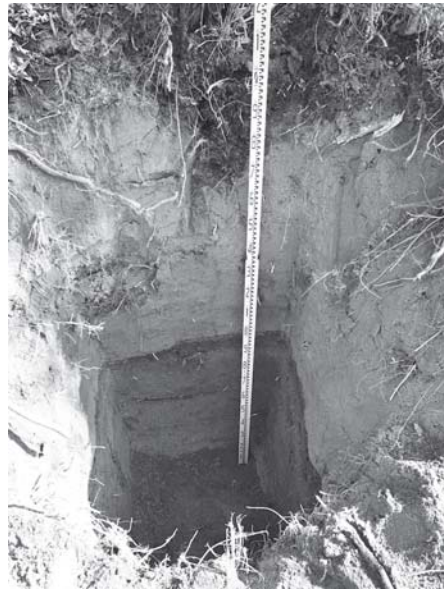
写真5 北グランド西側地区 No.6 調査区完掘状況(西より)
