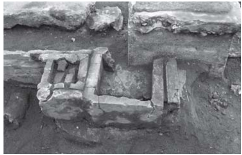
写真 23 既存施設撤去工事地区排水柵
