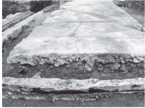
写真 21 既存施設撤去工事地区道路遺構断面
