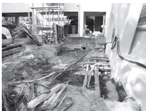
写真 57 中・高校舎改修工事玄関スロープ新設工事地区掘削状況
