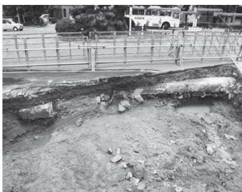
写真 18 排水溝布設工事北地区建物基礎 検出状況
