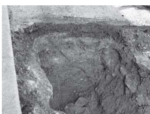
写真 59 中・高校舎改修工事体育館連絡通路改修工事地区堆積層（体育館側）
