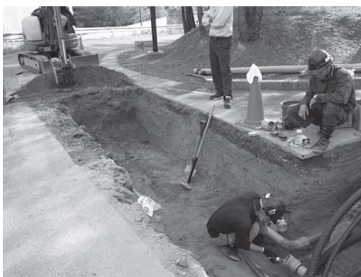
写真2 電気配管掘り方掘削状況
