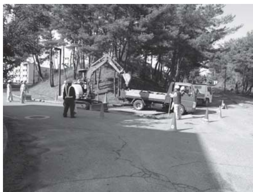
写真1 調査区全景と掘削状況
