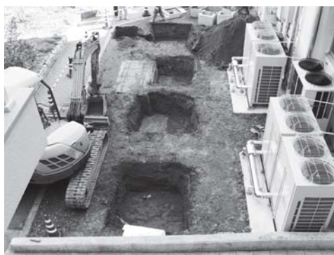
写真 53 医学部基礎第 2 研究棟北側駐輪場地区の調査完了状況
