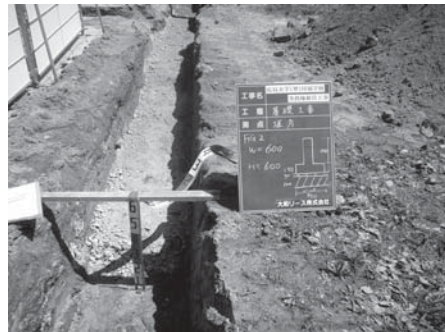
写真55 事務棟新営工事建物基礎掘り方掘削状況
