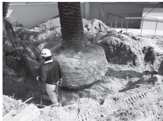
写真 29 植栽移設工事地区掘削状況
