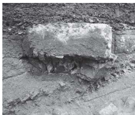
写真 19 排水溝布設工事北地区南北 建物基礎南端部検出状況
