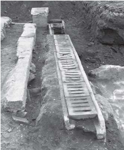
写真 22 既存施設撤去工事地区側溝
