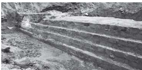
写真 32 煉瓦建物基礎煉瓦構築状況 (上：北辺部外側、下：西辺部内側)
