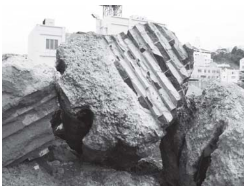
写真 34 煉瓦建物基礎断面
