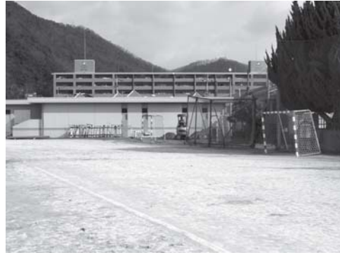
写真 60 プール南側排水管新設工事全景
