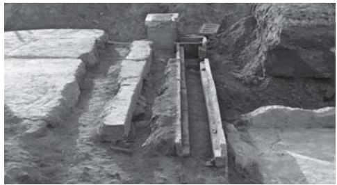
写真 24 側溝完掘状況
