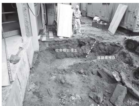
写真 56 中・高校舎改修工事エレベーター新設工事地区堆積層
