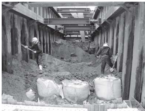
写真 15 南北共同溝布設工事掘削状況
