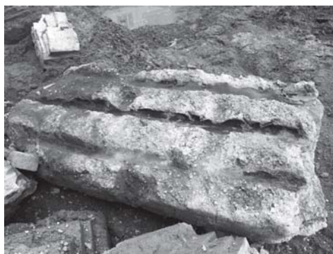
写真 35 煉瓦建物コンクリート基礎下底面
