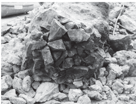
写真52 門柱底部基礎栗石接合状況
