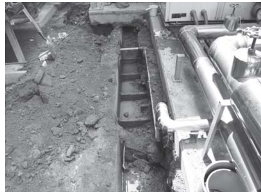
写真14 南東部ステージ基礎掘り方建物基礎検出状況
