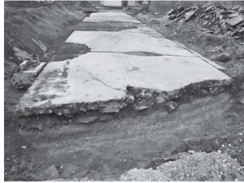
写真 39 道路遺構および横断面
