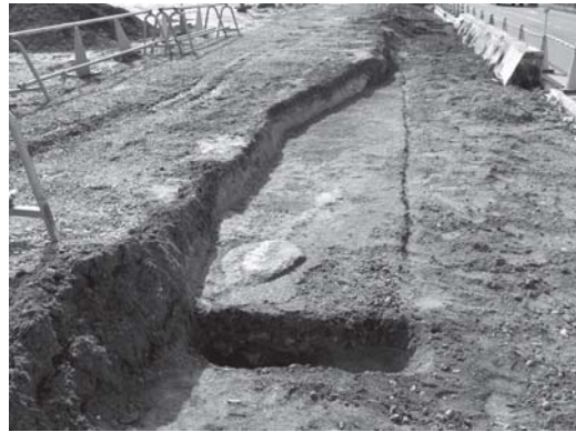
写真 27 外壁撤去工事地区舗装面検出状況
