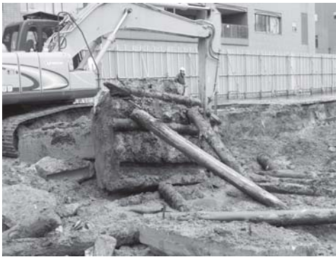
写真 36 煉瓦建物基礎支柱抜き状況
