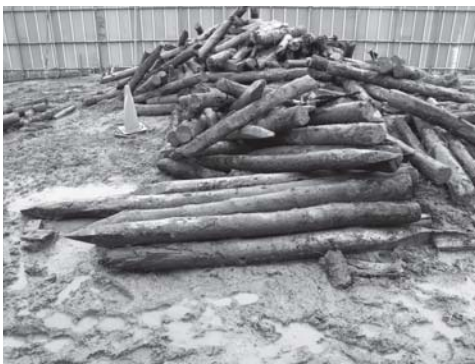
写真 37 煉瓦建物基礎杭抜き集積状況
