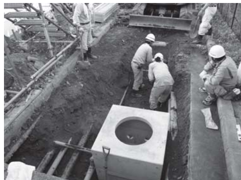
写真 15 電気配管付替掘り方掘削状況(2)
