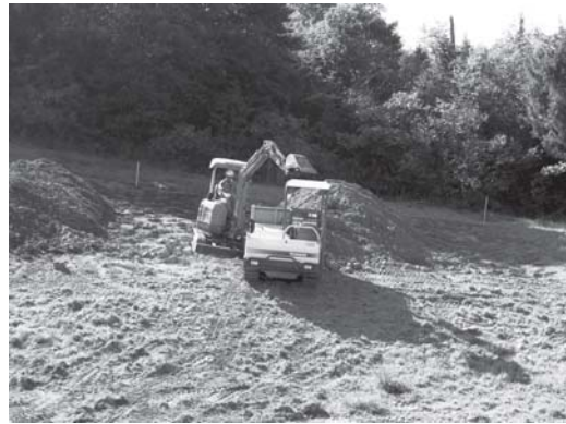
写真1 盛土掘削状況
