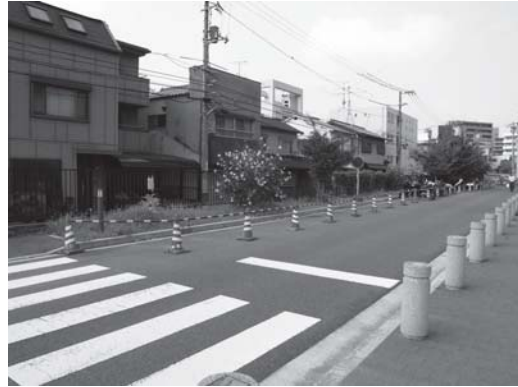
写真7 駐輪場移設工事第1区全景
