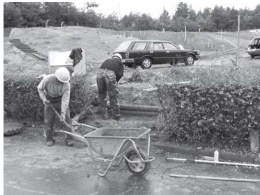
写真2 入口階段設置状況
