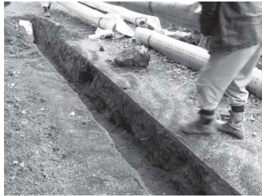
写真33 新設東西配管掘り方掘削状況
