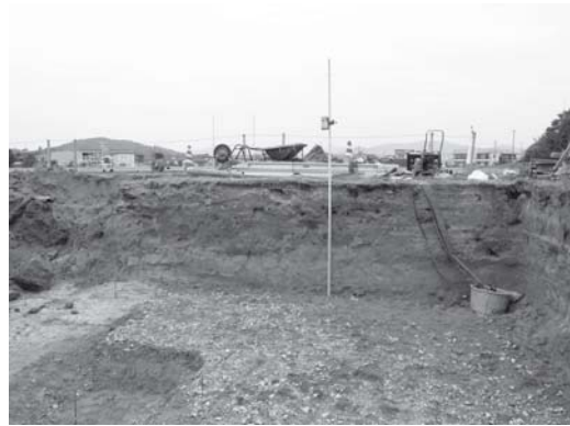
写真4 新設便所基礎掘り方掘削状況
