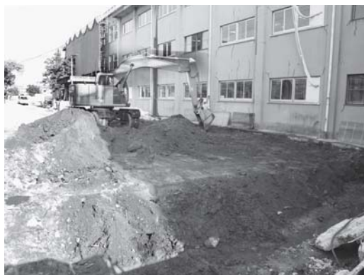
写真45 附属小学校増築工事地区掘削状況 (旧制広島高等学校造成土上面露出状況)
