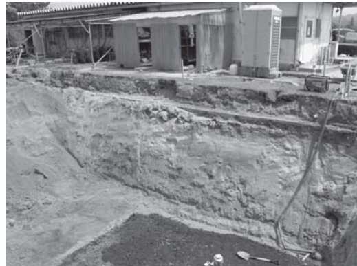
写真5 浄化槽基礎掘り方掘削状況
