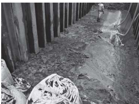
写真 36 共同溝 1 区 4 次掘削木質堆積層露出状況（地表下約 7 m）
