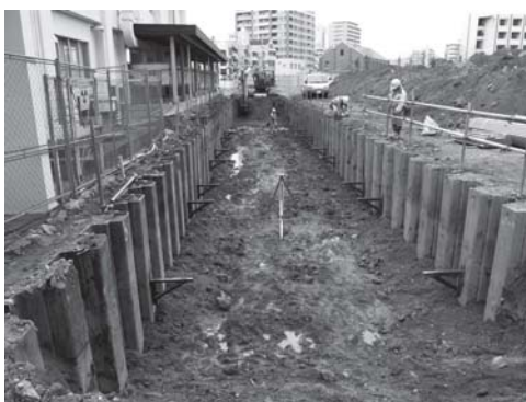
写真 35 共同溝 1 区 1 次掘削完了状況（地表下約 2 m）
