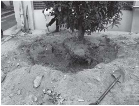
写真 10 高木移植のための掘り方掘削状況
