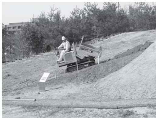
写真 3 階段部分土盛り状況
