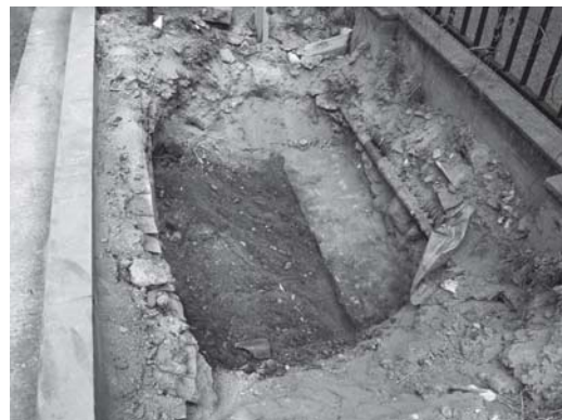
写真9 駐輪場移設工事第1区 No.14 基礎掘り方検出コンクリート基礎および排水路遺構
