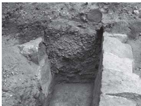
写真 27 植栽移設No.1 地点石組溝埋積状況
