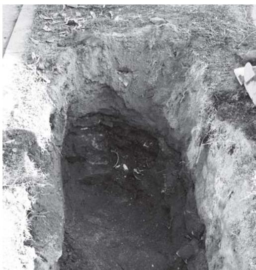
写真32 既設ガス管接合部分掘り方掘削状況
