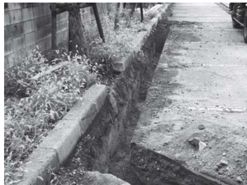
写真 13 ガス管敷設掘り方掘削状況
