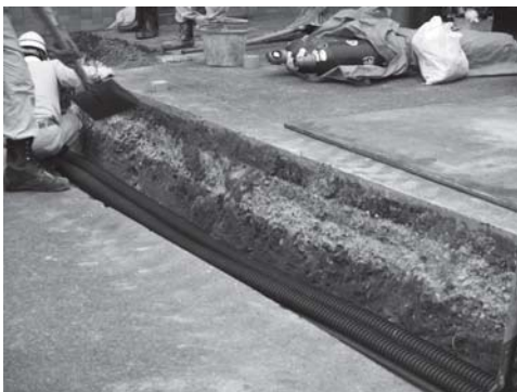
写真 14 電気配管付替掘り方掘削状況(1)
