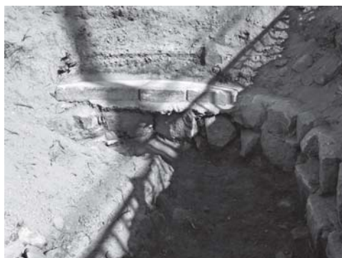
写真 29 植栽移設No.5 地点南北石組
