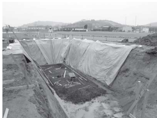
写真6 浄化槽基礎掘り方完掘状況
