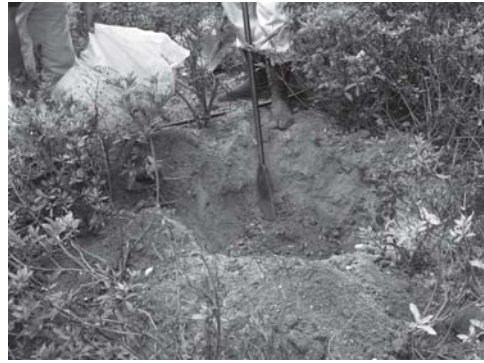
写真 11 高木植栽移設先掘り方掘削状況
