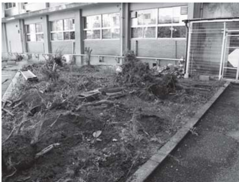
写真 12 植撤去状況(高木)
