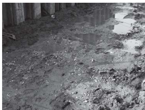
写真 37 共同溝 2 区 1 次掘削底面貝殻（カキ主体）層露出状況（地表下約 2 m）
