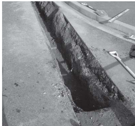
写真34 新設南北配管掘り方掘削状況
