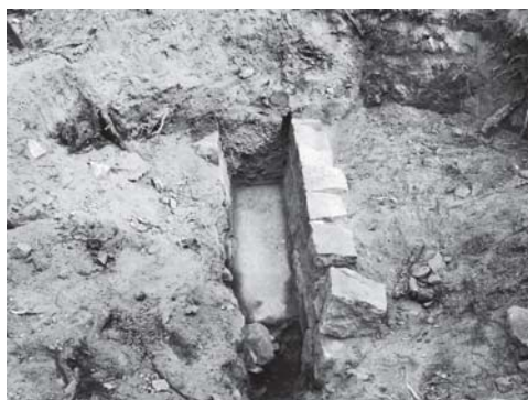
写真 25 植栽移設No.1 地点検出石組溝全景
