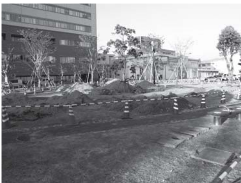
写真22 植栽移設先全景
