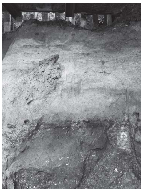
写真 39 共同溝 3 区南端部堆積状況（下半部：地表下約 3.5 m～約 7 m）
