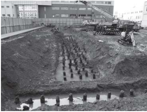
写真 16 研究 A 棟基礎柱列露出状況 (2区および3区東端部)
