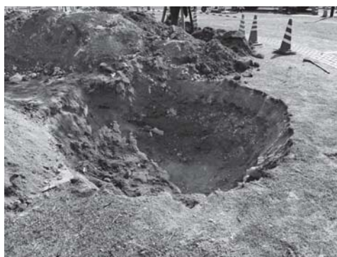
写真23 クスノキNo.1移植用掘り方掘削状況
