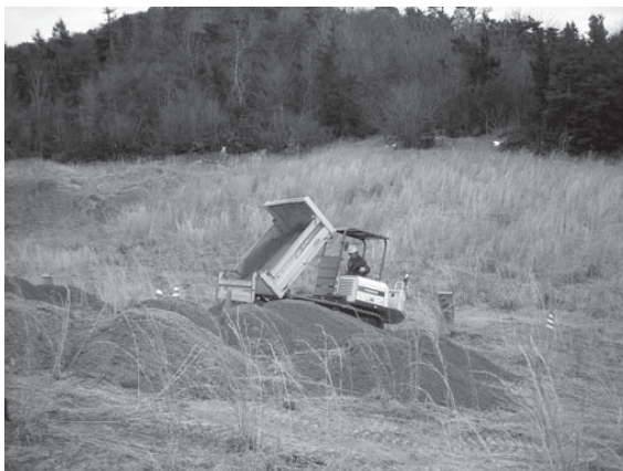
写真 39 散策道路用土搬入状況
