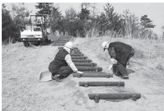
写真 40 散策道路階段部分整備状況
